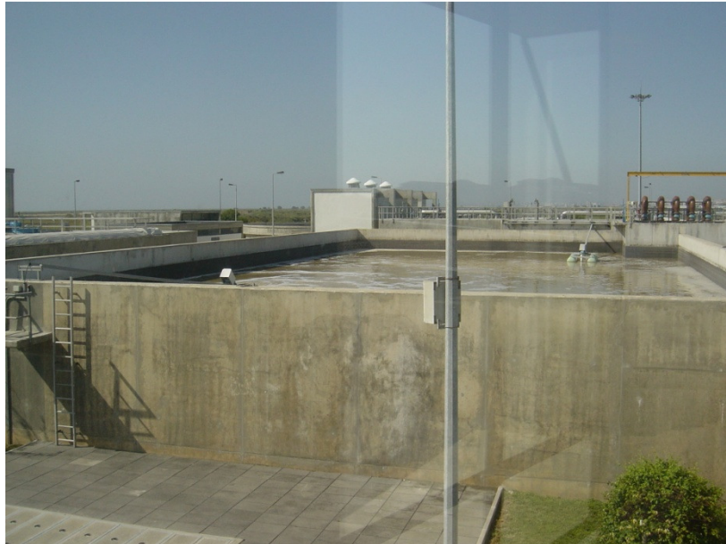
Figura 2: Tanque de homogeneização e equalização. Fonte: ETAR de Alverca, 23 de Maio de 2013.
