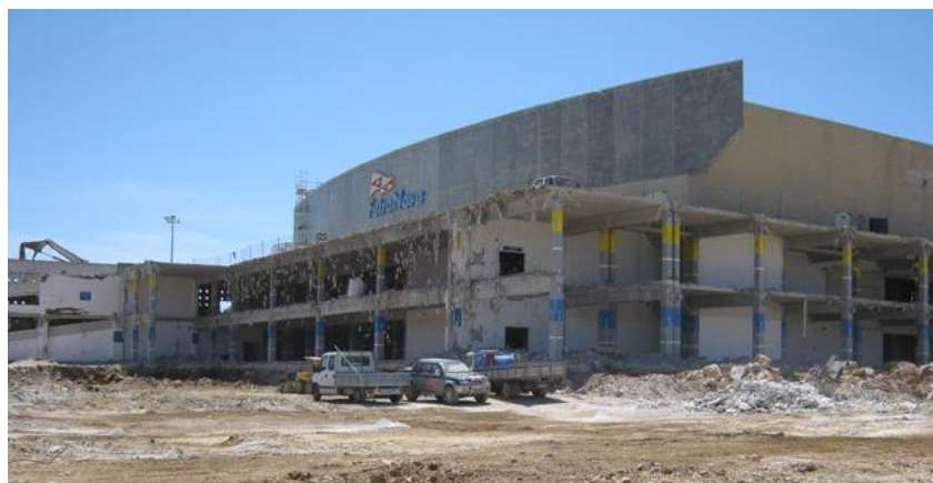
Figura 7.29 – Edifício Feira Nova – Caso estudo 2
