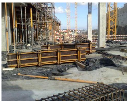
Figura 7.24 – Cofragem de pilares - Caso de Estudo 2
