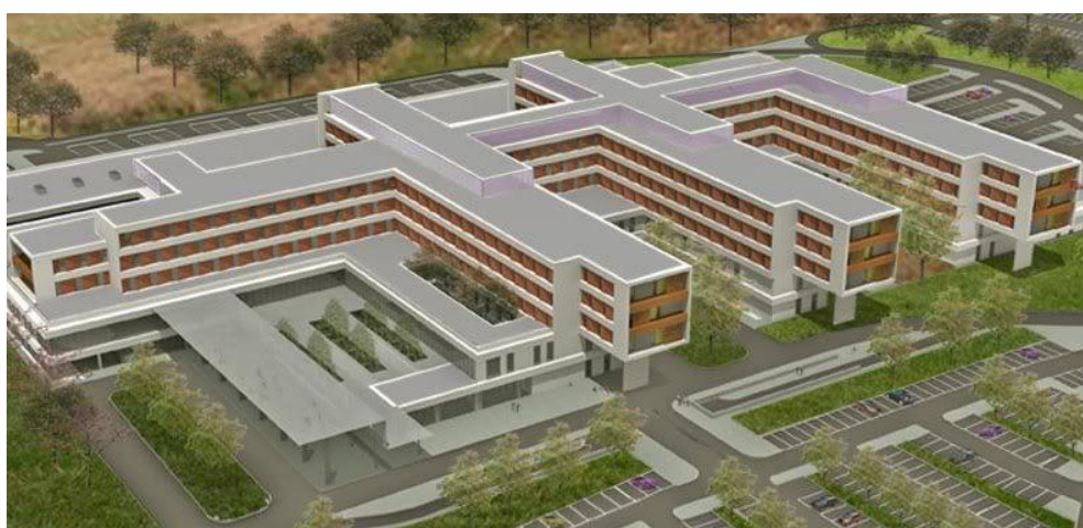
Figura 7.33 – Edifício Hospitalar - Caso estudo 3
