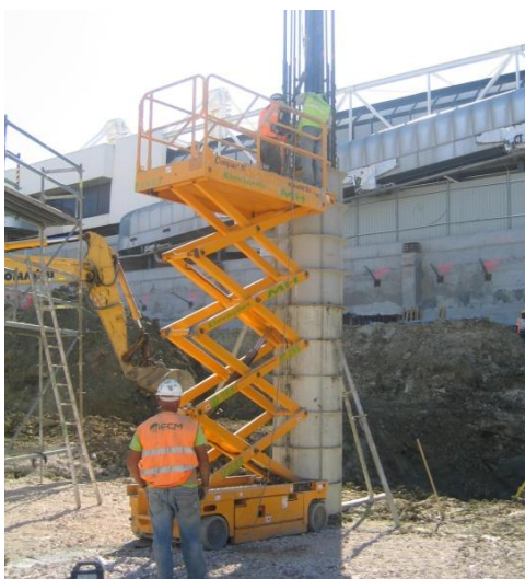
Figura 7.4 – Cofragem metálica em pilares - Caso de Estudo 1
