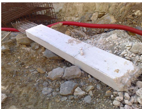
Figura 7.27 – Demolição de um Pilar – Caso estudo 2
