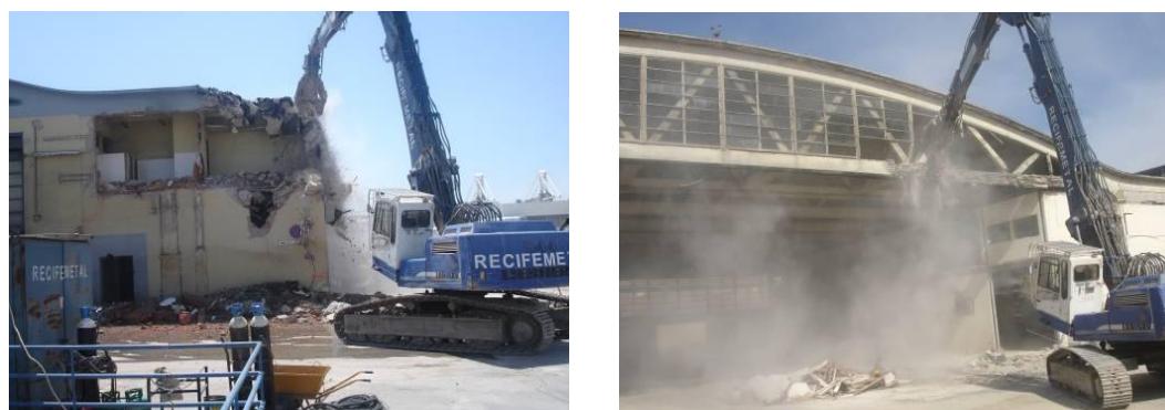
Figura 7.13 – Demolição com meios mecânicos
