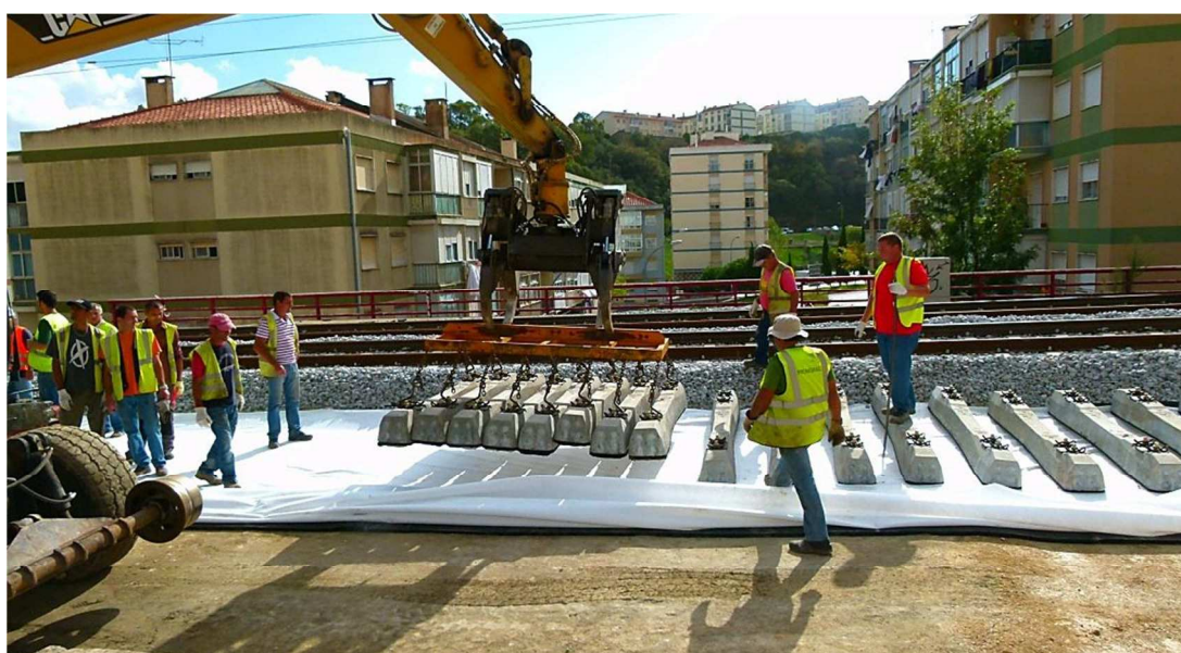
Figura 34 - Colocação de travessas com palmilhas resilientes [8]
