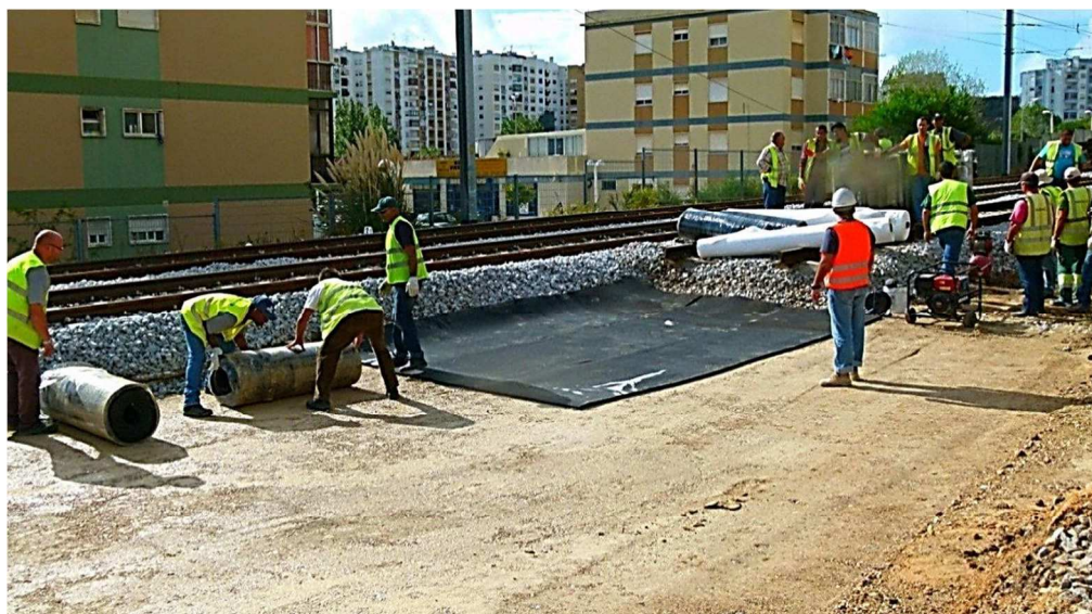
Figura 36 - Colocação de manta de balastro [8]
