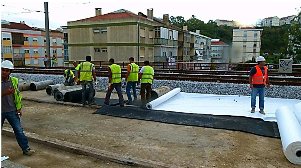
Figura 37 - Colocação de geotêxtil sobre a manta de balastro [8]
