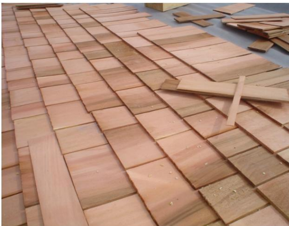
Figura 84 – Aplicação de telha Shingle
