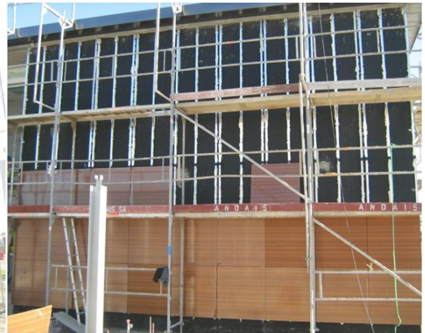
Figura 53 - Aplicação de painéis fenólicos
