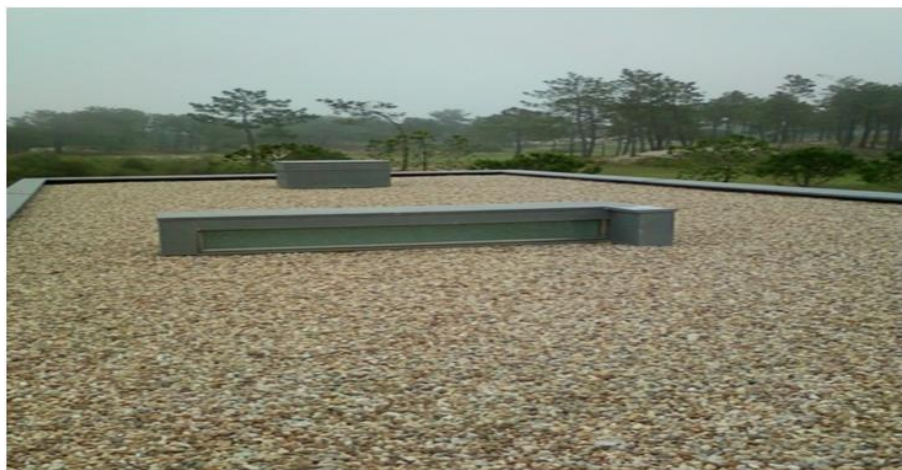
Figura 68 – Cobertura com acabamento e protecção mecânica em “calhau rolado”
