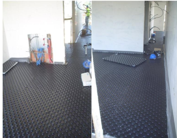
Figura 99 – Aplicação de tela porta-tubos com isolamento térmico
