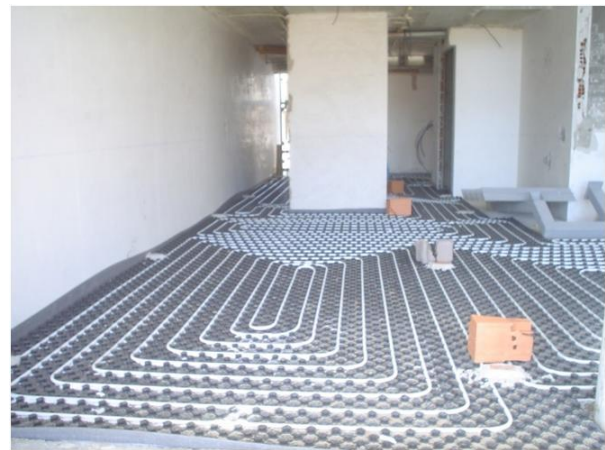
Figura 101 – Aplicação de tela porta-tubos
