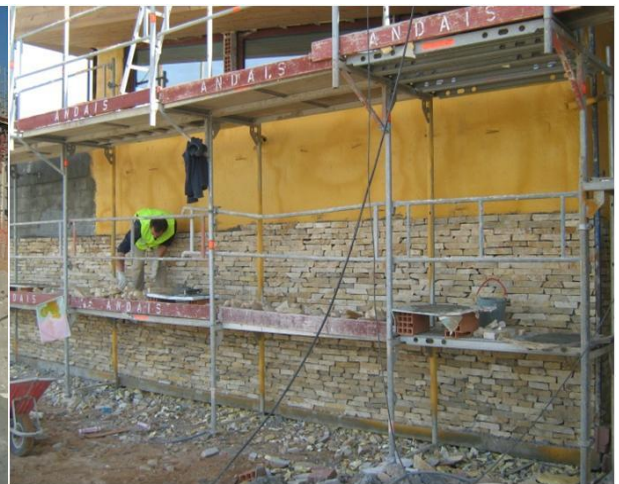
Figura 51 – Revestimento de fachadas em pedra calcária
