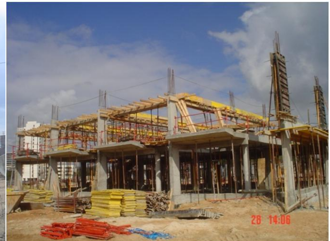
Figura 16 – Lançamento Cofragem Vigas Cobertura
