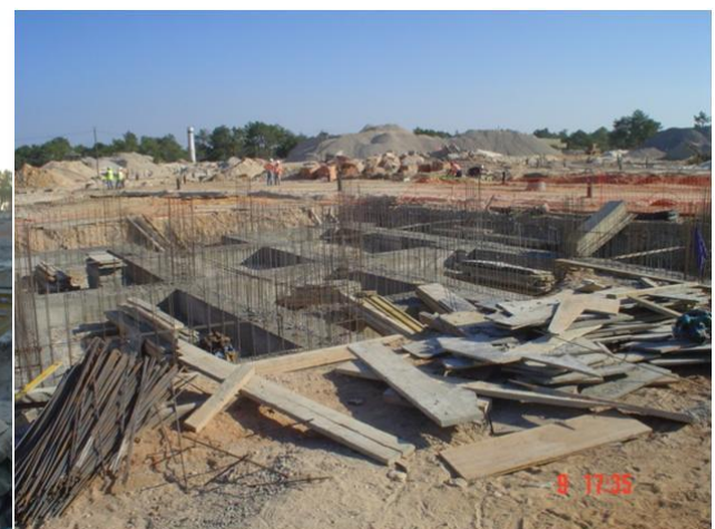
Figura 8 – Sapatas betonadas e descofradas
