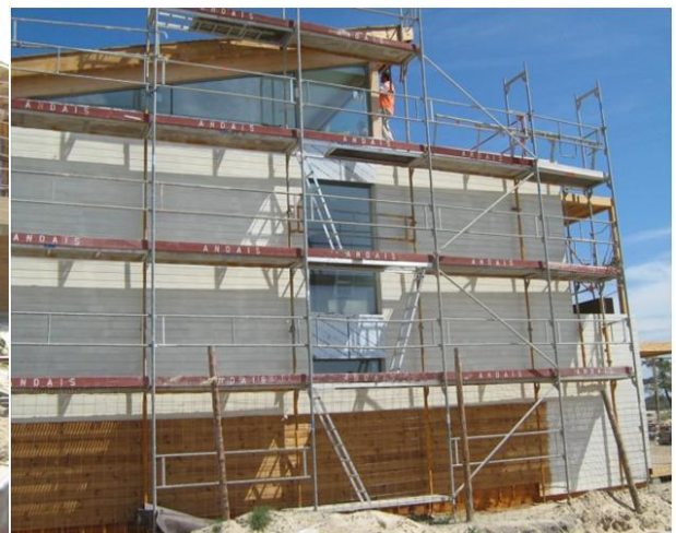
Figura 45 – Pintura para protecção da fachada em madeira modificada
