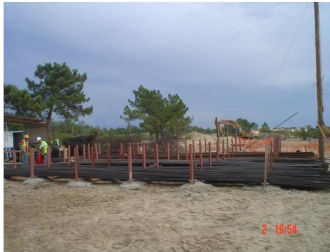
Figura 71 - Estaleiro de frente de obra
