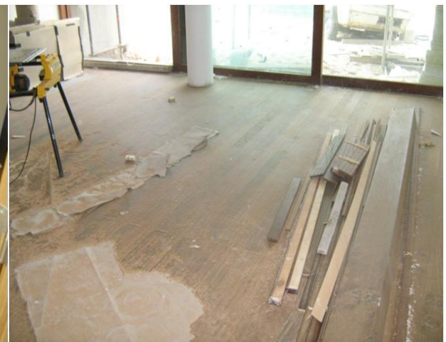
Figura 59 – Aplicação de pavimento de madeira maciça de IPE colado
