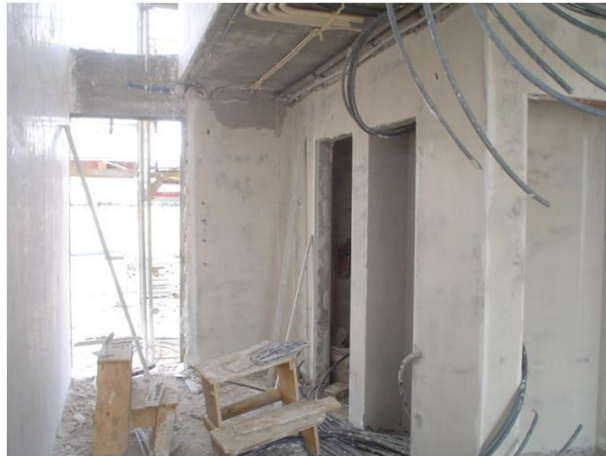
Figura 23 – Execução de Estruque em paredes
