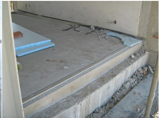
Figura 31 – Impermeabilização de Soleiras
