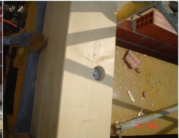
Figura 77 – Fixação de vigas de madeira
