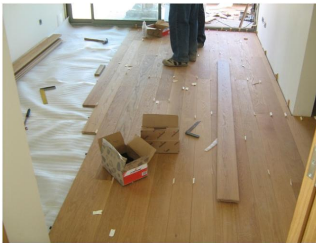
Figura 58 – Aplicação pavimento flutuante de madeira maciça de Carvalho
