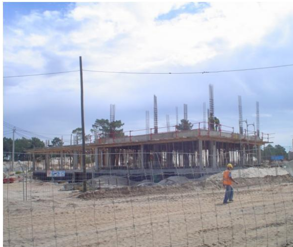
Figura 15 – Cofragem Laje piso 1
