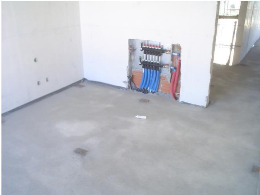
Figura 102 - Execução da última camada de betonilha
