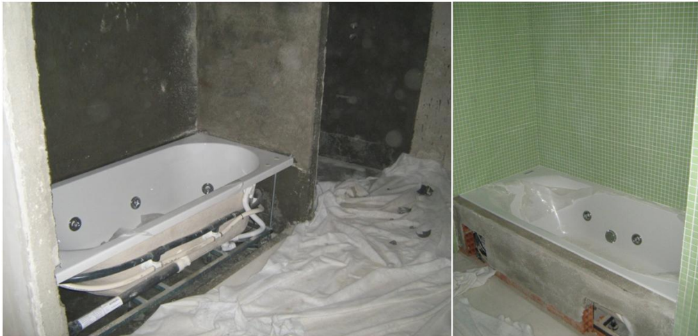
Figura 28 – Assentamento de Banheira
