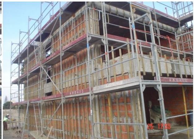
Figura 88 - Aplicação de travessas de fixação
