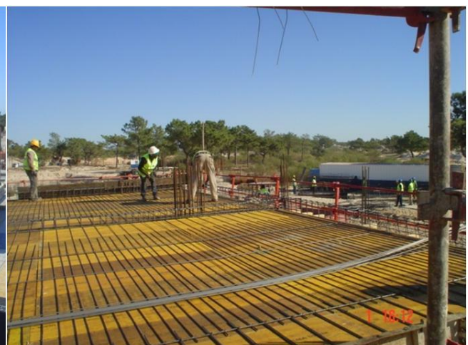
Figura 12 – Armadura Laje piso 0
