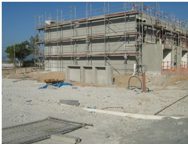
Figura 50 – Revestimento de fachadas com sistema Hotskin
