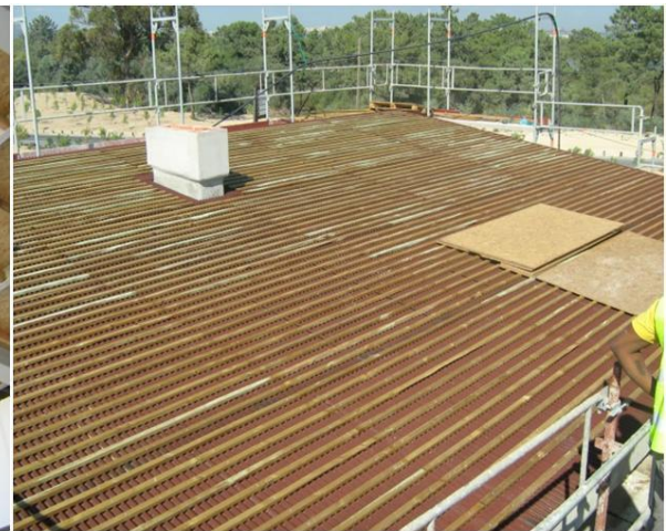
Figura 67 - Aspecto final de cobertura em telha Shingle
