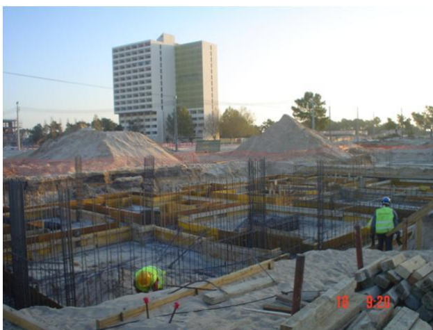
Figura 7 – Cofragem e armadura em sapatas
