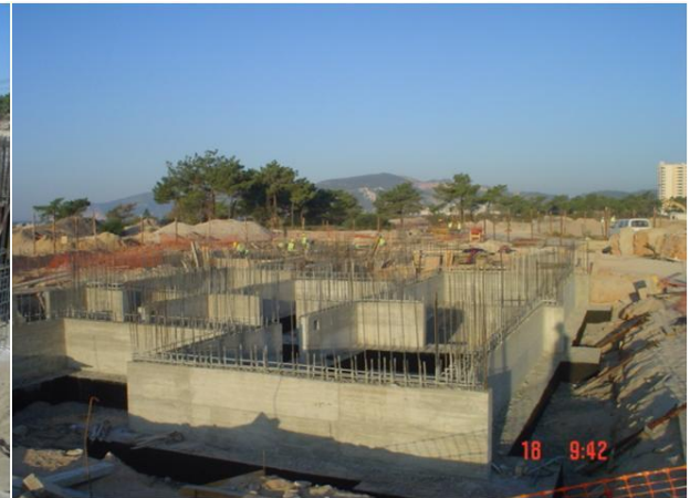
Figura 10 – Muros de Fundação betonados e descofrados
