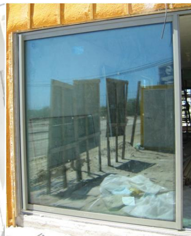
Figura 33– Montagem de caixilharia em alumínio
