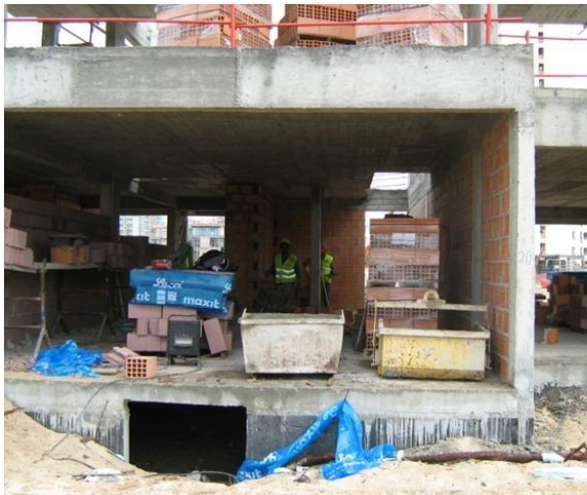
Figura 19 – Execução Alvenarias piso 0
