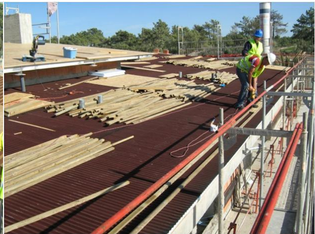
Figura 83 – Aplicação de estrutura para assentamento de telha Shingle
