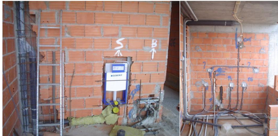
Figura 21 – Abertura de Roços para rede de Águas
