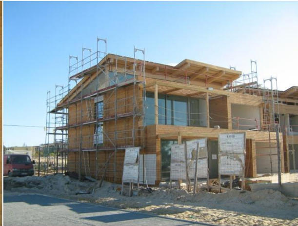
Figura 92 – Aspecto final do revestimento
