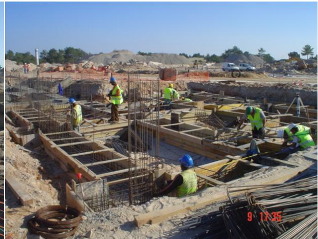
Figura 6 - Cofragem e armadura em sapatas
