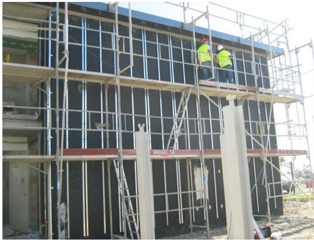
Figura 52 - Aplicação de estrutura para revestimento com painéis fenólicos
