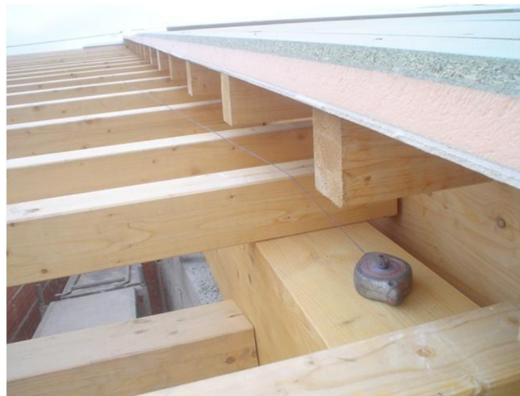
Figura 81 – Aplicação de painel Sandwich
