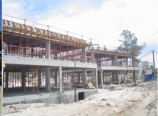
Figura 18 - Laje cobertura betonada
