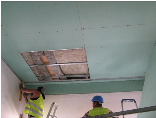
Figura 40 – Aplicação de gesso cartonado em tectos falsos
