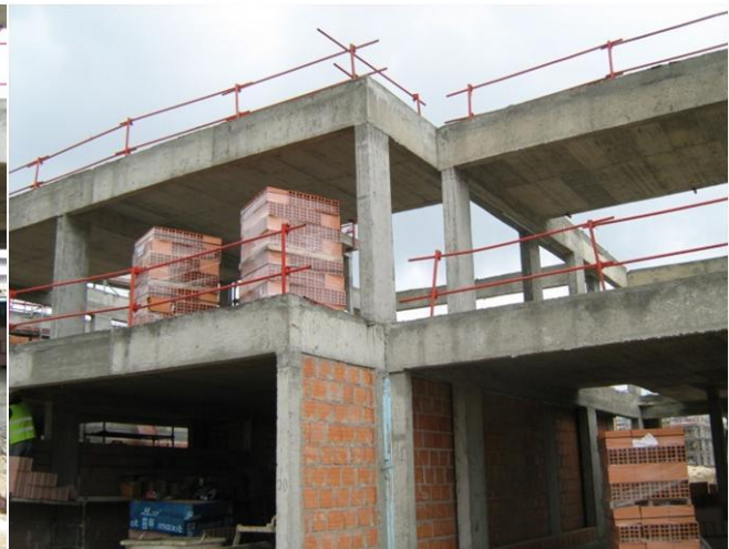
Figura 20 – Execução Alvenaria piso 1
