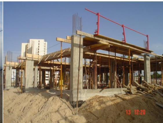
Figura 14 – Lançamento cofragem piso 0
