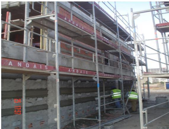
Figura 87 - Execução de mestras para correcção de prumadas
