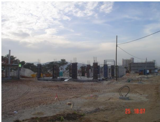
Figura 13 – Cofragem Pilares piso 0
