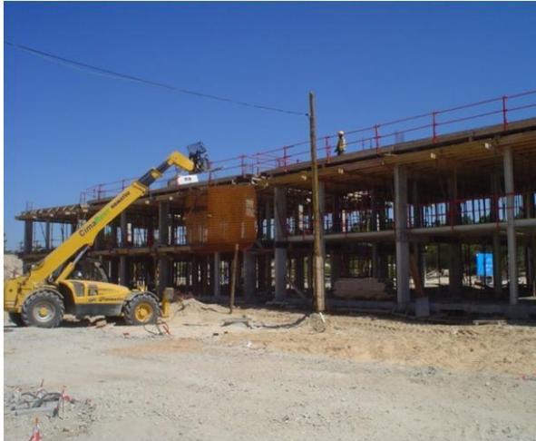
Figura 17 - Cofragem Laje cobertura
