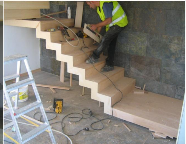
Figura 63 - Escada revestida a madeira
