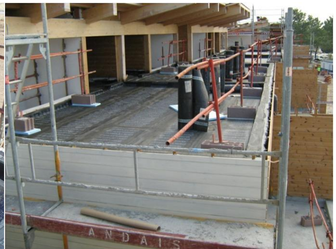
Figura 35 – Impermeabilização de Terraços
