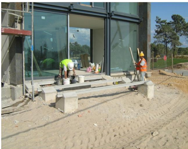
Figura 60 – Execução de estrutura para assentamento de Deck
