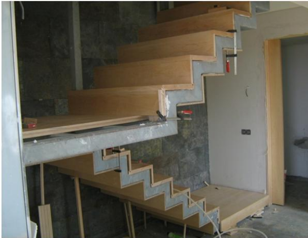
Figura 62 - Revestimento de Escadas metálicas
