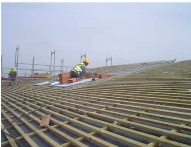
Figura 64 – Estrutura em madeira para aplicação de Shingle
