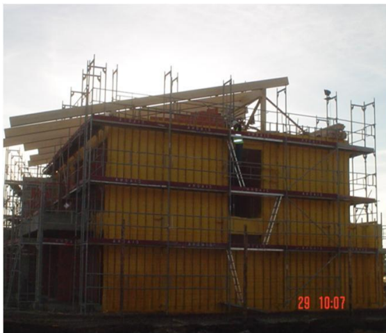
Figura 78 - Estrutura em Madeira : vista geral
