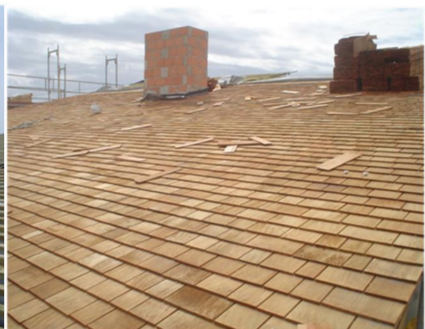
Figura 65 – Aspecto final de cobertura em telha Shingle
