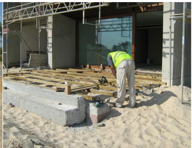
Figura 61 – Aplicação de Deck
