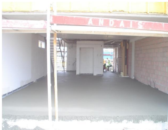
Figura 24 – Betonilha de regularização : 1ª camada
