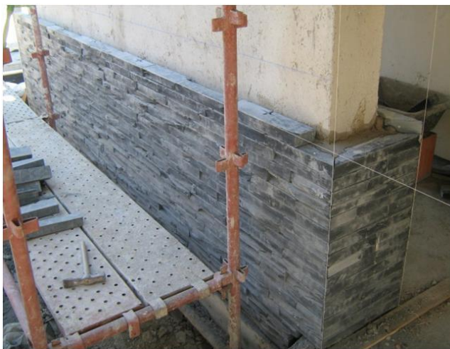
Figura 46 – Revestimento em Ardósia preta de Valongo
