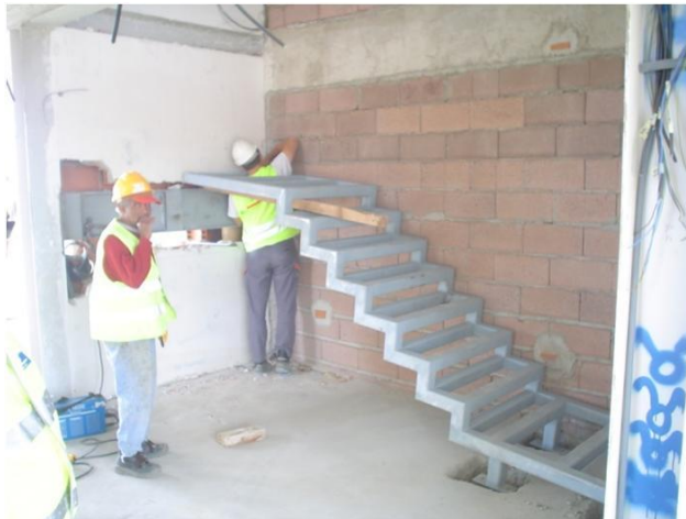
Figura 26 – Assentamento de escada metálica apoiada nas extremidades
