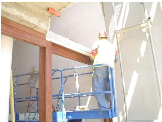
Figura 32 – Montagem de caixilharia em madeira
