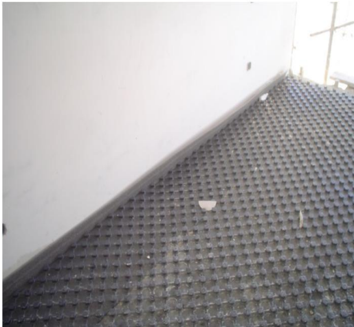
Figura 98 - Aplicação banda perimetral
