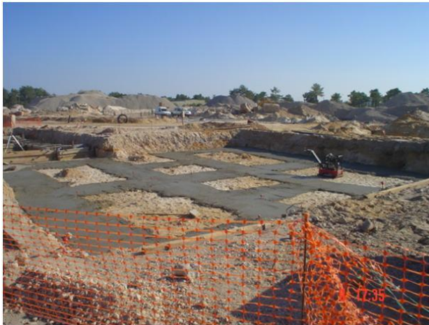
Figura 5 - Aplicação betão limpeza
