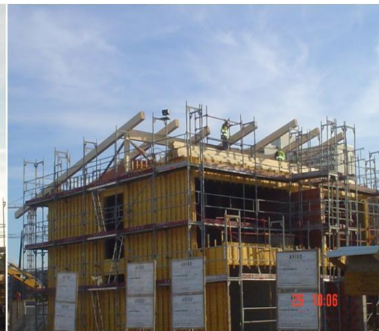
Figura 79 – Estrutura em madeira
