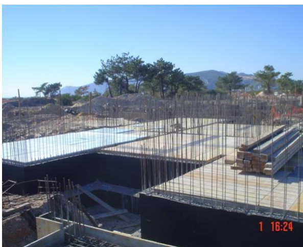
Figura 11 – Cofragem Laje piso 0
