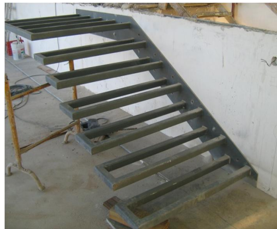
Figura 27 – Assentamento de escada metálica de apoio lateral
