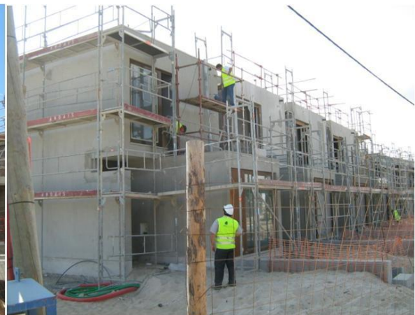
Figura 95 - Restantes camadas de Maxit 408, barramento armado e revestimento cimentício
