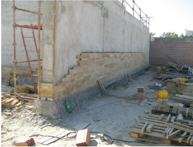
Figura 48 – Execução de revestimento em xisto Shara
