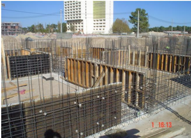
Figura 9 – Armadura e Cofragem em Muros de Fundação
