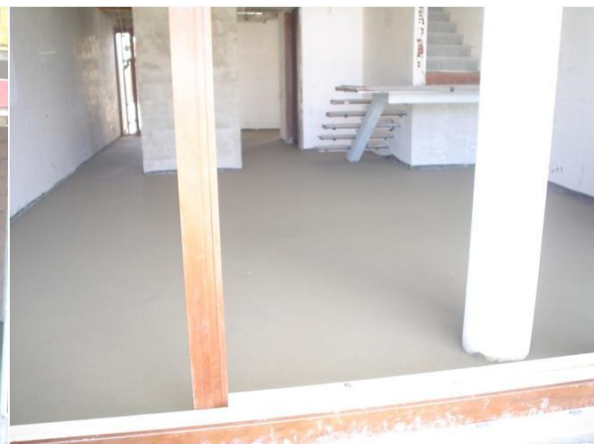
Figura 25 – Betonilha de Acabamento para receber revestimento
