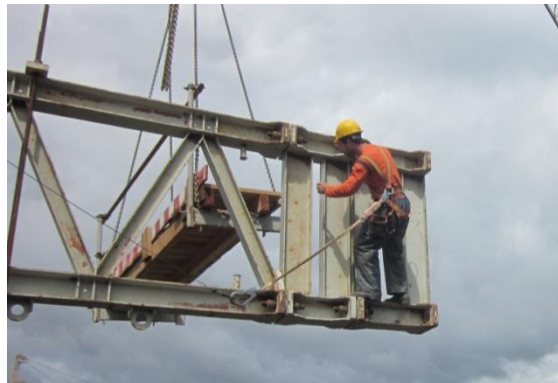
Montagem da estrutura principal dos carros de avanço (CA): pórtico e asnas
