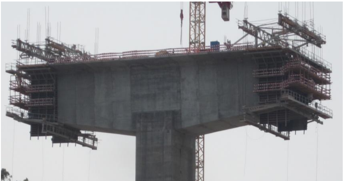
Primeiras 4 aduelas betonadas e carros de avanço posicionados nas aduelas 5.
