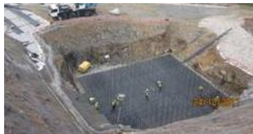
Contenção de escavações: pregagens, betão projetado e redes
