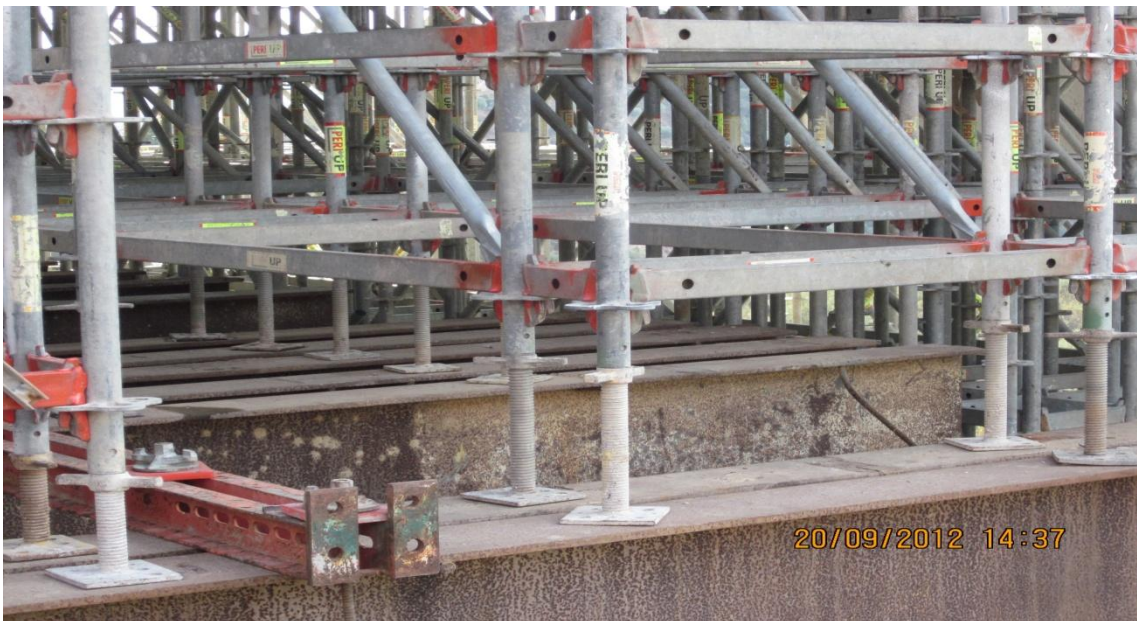
Cimbre ao solo, salva taludes e cofragem exterior para aduela junto do encontro
