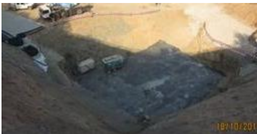
Contenção de escavações: pregagens, betão projetado e redes
