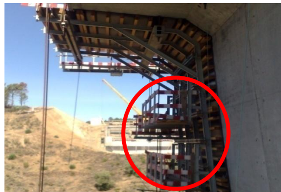
Plataformas de trabalho da cofragem exterior
