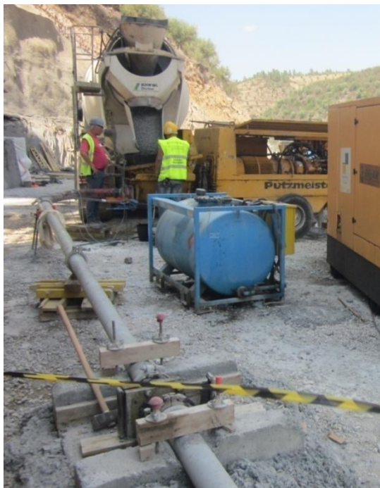
Bomba de betão e tubagem do sistema de elevação do betão
