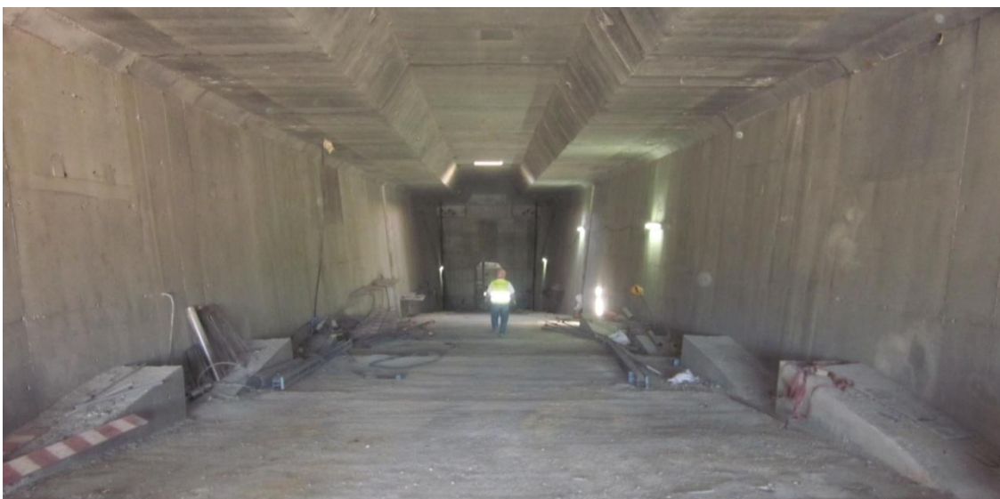
Vista geral dentro do tabuleiro (encontro -> pilar)
