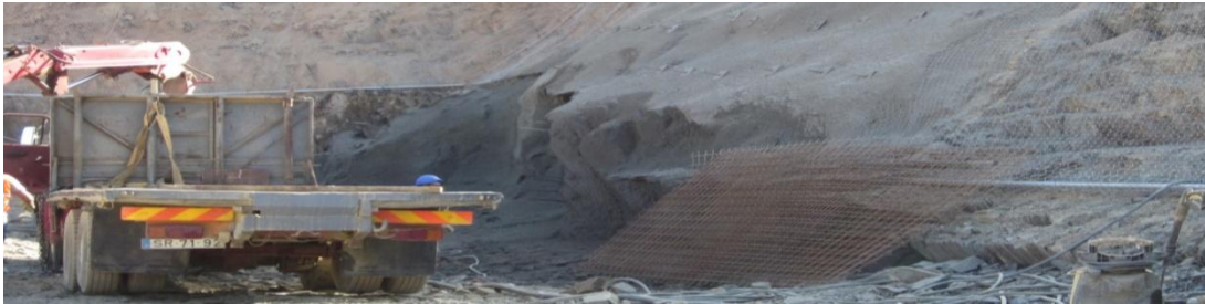
Contenção de escavações: pregagens, betão projetado e redes
