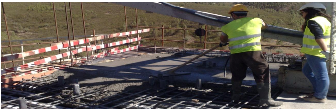
Betonagem do banzo superior da(s) aduela(s)
