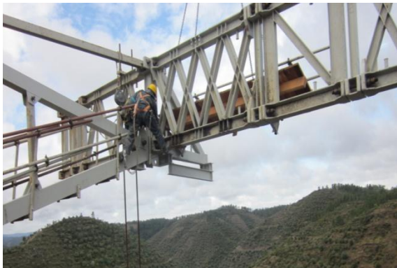
Montagem da estrutura principal dos carros de avanço (CA): pórtico e asnas
