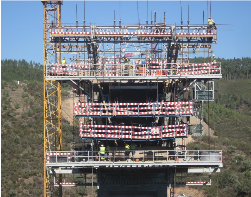
Toda a estrutura e cofragens do Carro de avanço montadas
