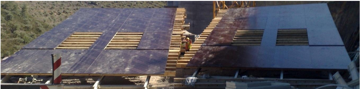
Pré-montagem ao nível do solo da cofragem exterior
