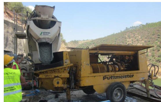
Bomba de betão e tubagem do sistema de elevação do betão
