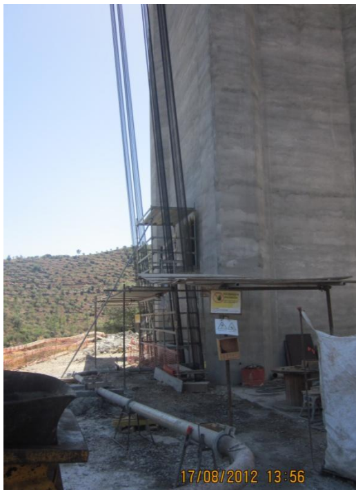
Apoio dos tirantes do sistema de equilíbrio exterior: à esquerda na base do pilar e à direita no tabuleiro
