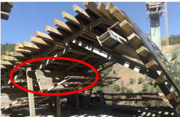
Plataformas de trabalho da cofragem exterior
