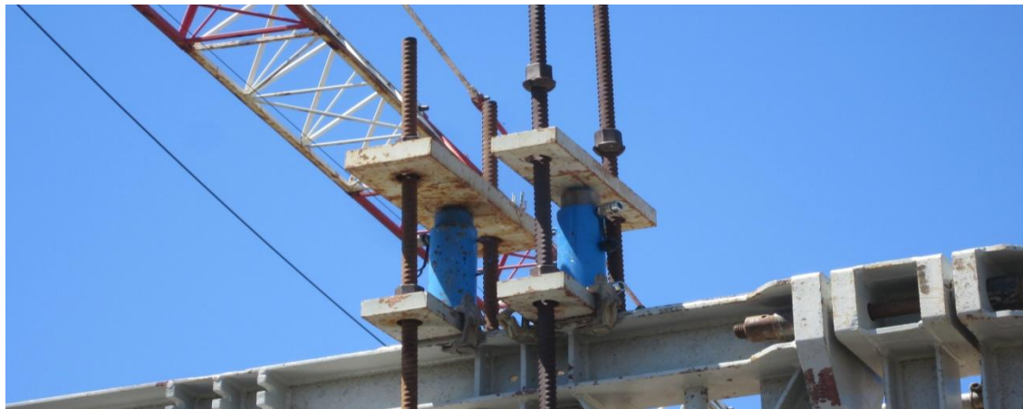
Pontos de suspensão das cofragens das aduelas
