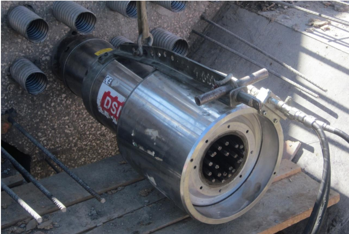
Aplicação de pré-esforço nas aduelas
