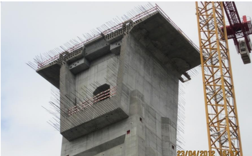
Execução da aduela zero
