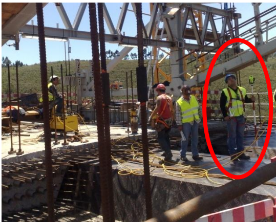
Medições topográficas para ajuste/fixação das cofragens
