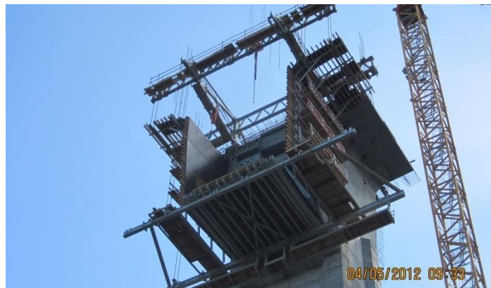
Cofragens e plataformas de trabalho exteriores montadas
