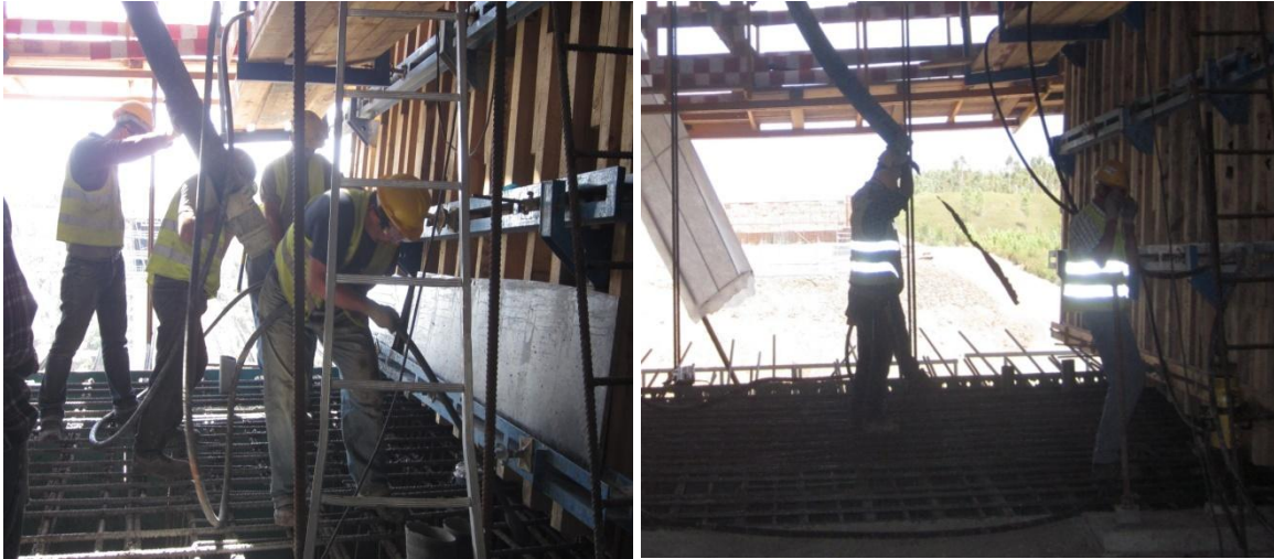
Betonagem do banzo inferior da(s) aduela(s)
