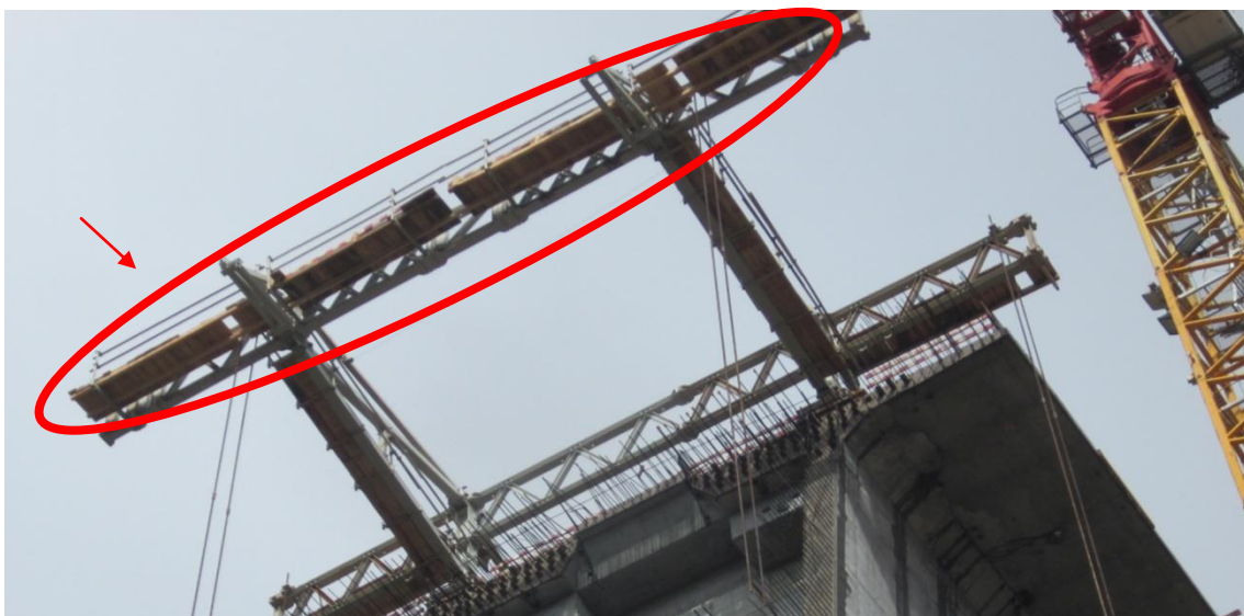
Montagem das plataformas de trabalho das asnas
