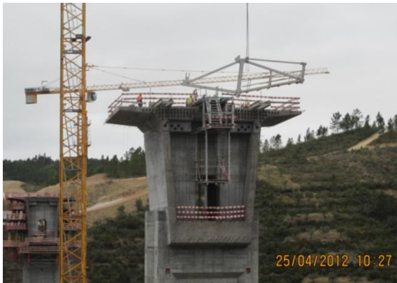
Montagem da estrutura principal dos carros de avanço (CA): pórtico e asnas
