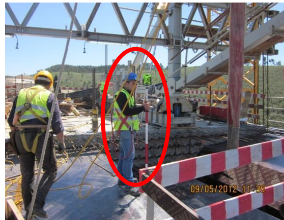
Medições topográficas para ajuste/fixação das cofragens
