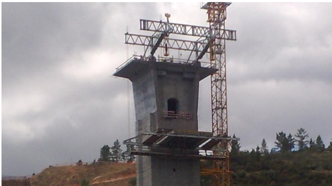
Cofragem de fundo montada/fixada
