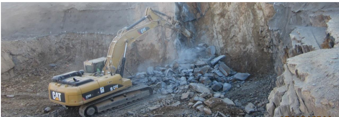
Escavação para as fundações dos pilares. Recurso a explosivos e meios mecânicos.
