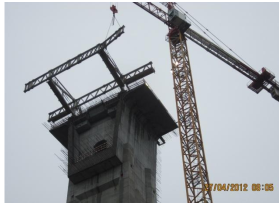
Montagem da estrutura principal dos carros de avanço (CA): pórtico e asnas
