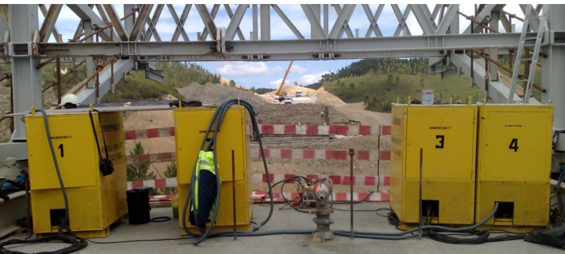
Cofragem de fundo e sistema de elevação Strand Jack
