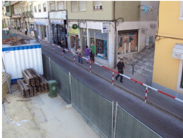
Figura 2.5. – Via de acesso à obra
