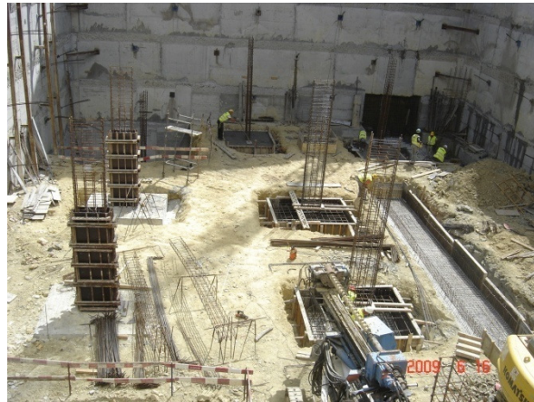
Figura 6.5. – Execução das sapatas centrais
