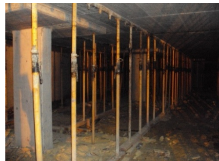
Figura 6.18. – Escoramento directamente na laje
