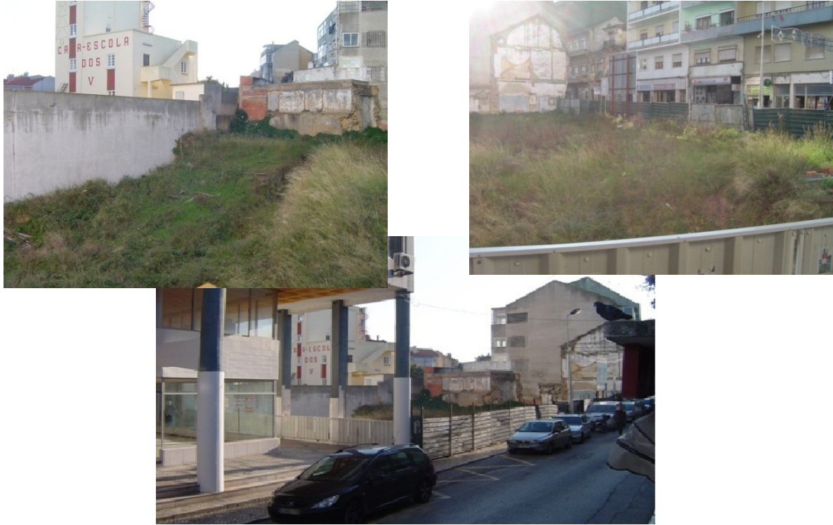
Figura 2.2. – Aspecto do local da obra antes do início dos trabalhos
