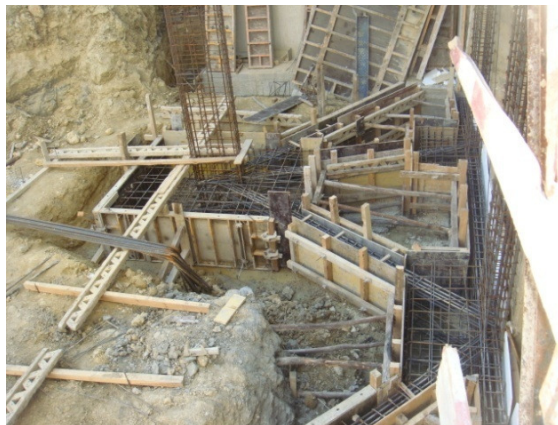
Figura 6.3. – Sapatas e vigas de fundação junto à edificação existente
