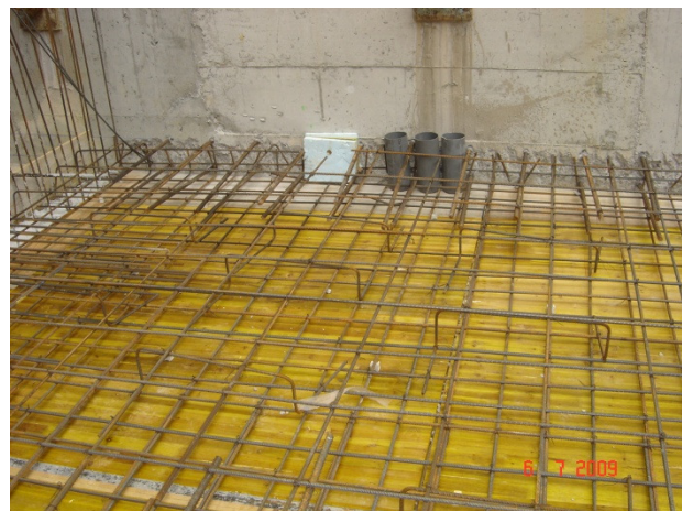
Figura 6.15. – Negativo na laje para tubagem da rede de esgotos
