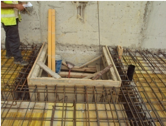
Figura 6.14. – Negativo na laje para ventilação do parque de estacionamento
