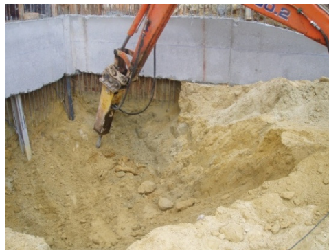
Figura 5.2. – Martelo hidráulica - desmorte das partes rochosas do maciço
