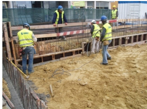
Figura 3.14. – Betonagem e vibração da viga de coroamento
