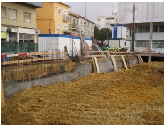
Figura 3.15. – Viga de coroamento do topo Nascente
