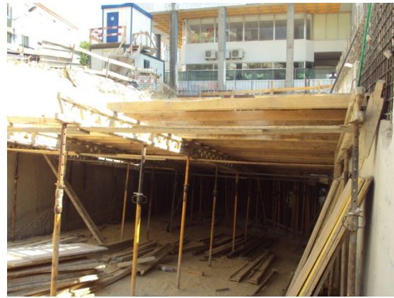
Figura 6.17. – Escoramento da cofragem da rampa
