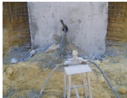
Figura 4.4. – Reinjecção da ancoragem
