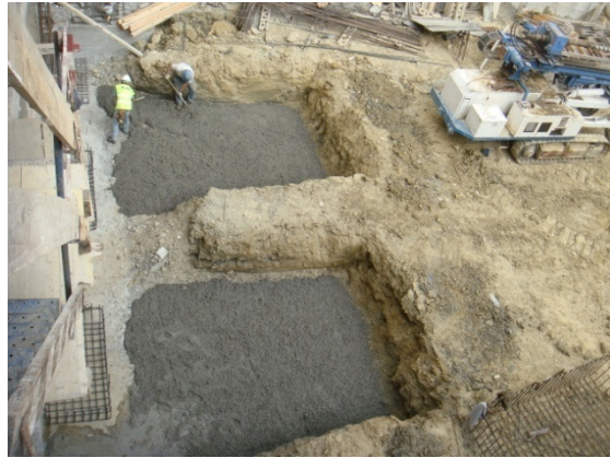
Figura 6.2. – Fundo das sapatas com betão de regularização
