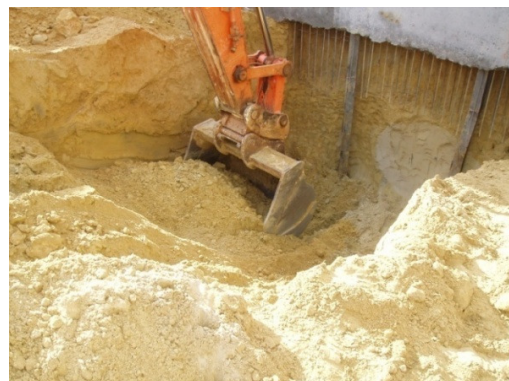
Figura 3.19. – Escavação de um painel
