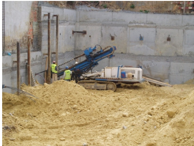
Figura 4.2. – Furação de um painel no topo Nascente
