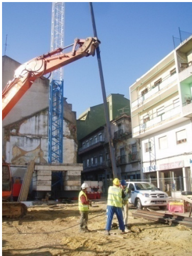
Figura 3.8. – Colocação de perfis
