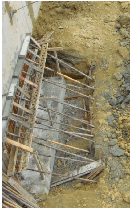
Figura 3.35. – Escoramento da cofragem dos painéis no 4º nível
