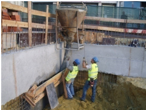
Figura 3.25. – Betonagem de um painel do 1º nível
