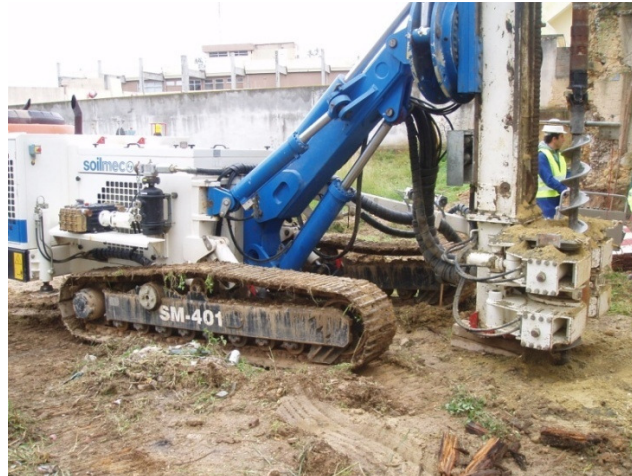
Figura 3.5. – Perfuração do terreno no topo Sul
