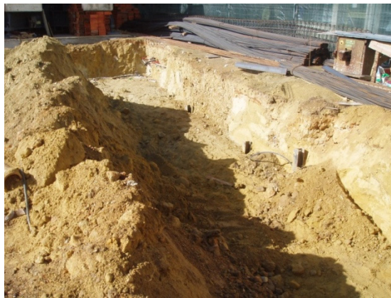
Figura 3.11. – Escavação da vala para a viga de coroamento
