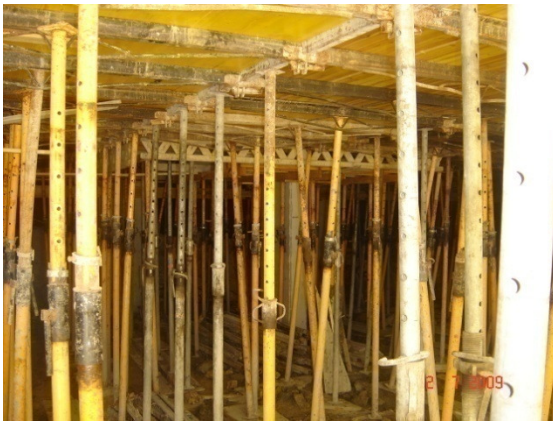
Figura 6.16. – Escoramento da cofragem da laje
