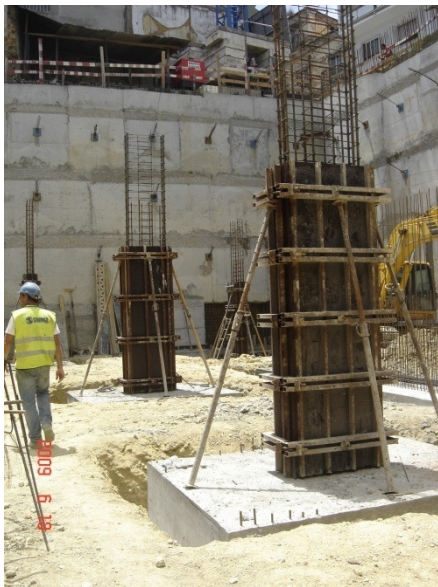
Figura 6.7. – Cofragens dos pilares no piso -4
