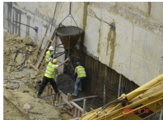
Figura 3.34. – Betonagem da sapata da parede
