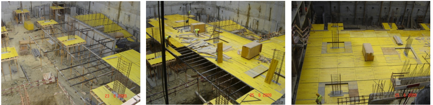
Figura 6.11. – Processo evolutivo de execução da cofragem da laje no piso -3
