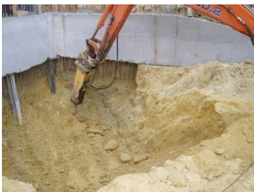
Figura 3.20. – Martelo a executar o desmonte do maciço rochoso
