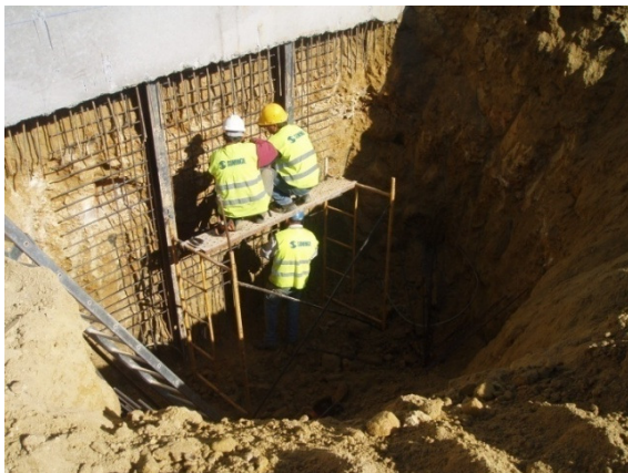
Figura 3.21. – Aplicação da armadura num painel
