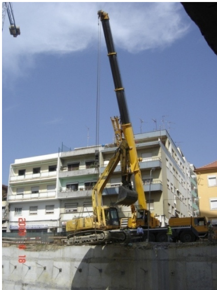
Figura 5.5. – Retirada da escavadora hidráulica
