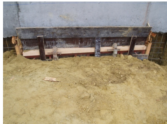
Figura 3.24. – Escoramento de um painel
