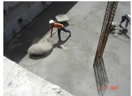
Figura 6.26. – Aplicação superficial de endurecedor no betão
