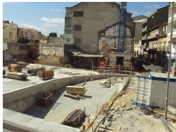
Figura 6.32. – Rampa de acesso ao parque
