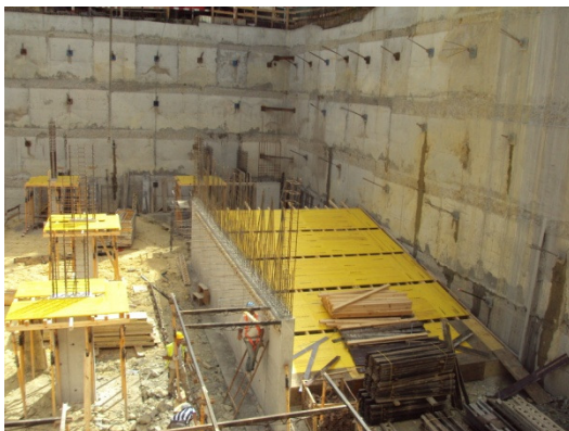
Figura 6.12. – Execução da cofragem da rampa no piso -3
