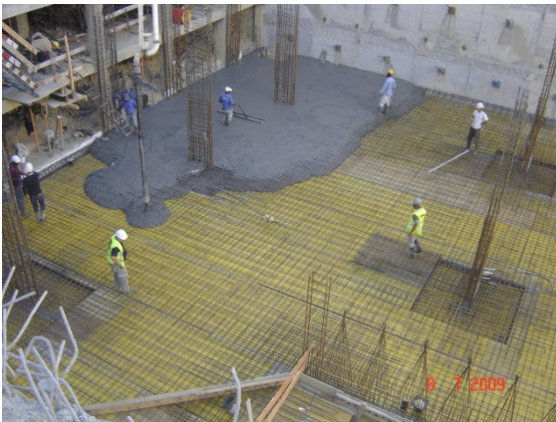
Figura 6.24. – Betonagem da laje do piso -3
