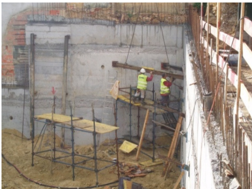
Figura 3.30. – Soldadura das escoras de canto
