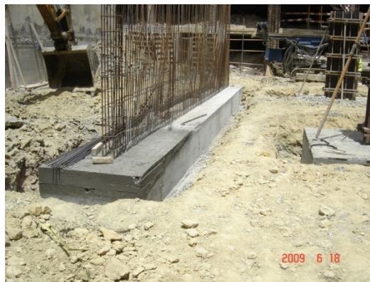
Figura 6.6. – Sapata do muro de apoio da rampa
