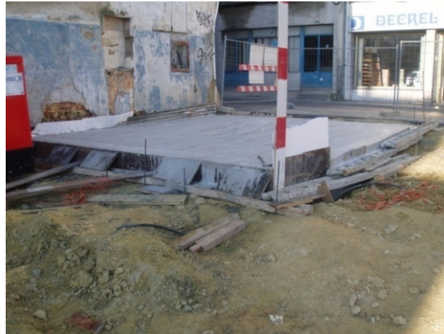
Figura 2.8. – Sapata de base para a grua torre
