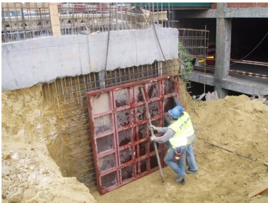
Figura 3.23. – Cofragem de um painel
