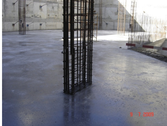
Figura 6.28. – Aspecto do acabamento final da laje
