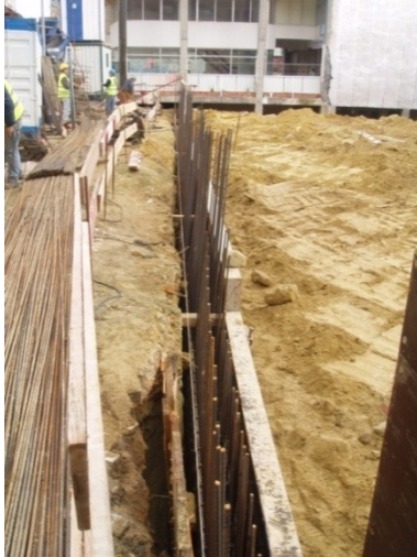
Figura 3.13. – Cofragem e armadura da viga de coroamento
