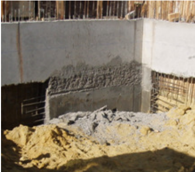
Figura 3.29. – Face interior da parede após a demolição do “bico de pato”
