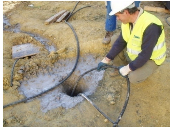
Figura 3.9. – Bolbo de selagem – execução da selagem do perfil
