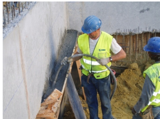
Figura 3.26. – Vibração do betão
