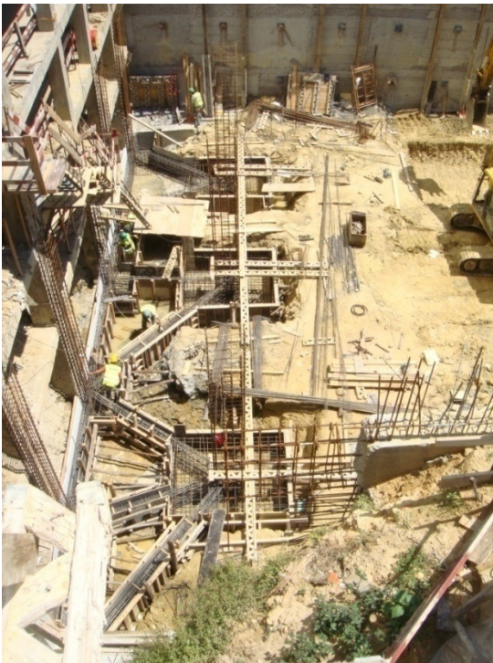
Figura 6.4. – Sapatas dos pilares antes da betonagem
