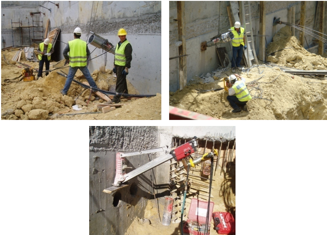
Figura 4.5. – Aplicação de carga e ensaios às ancoragens
