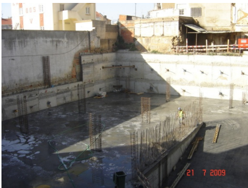
Figura 6.29. – Rega de laje após afagamento
