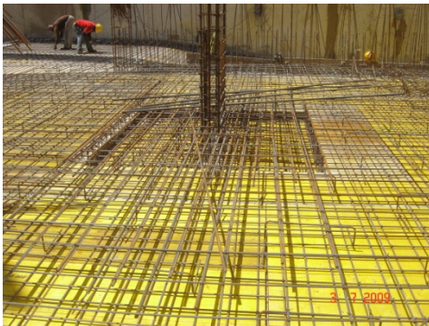
Figura 6.19. – Reforço da armadura da laje na zona do capitel
