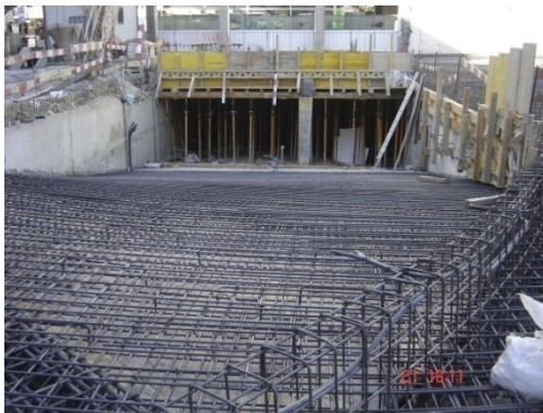
Figura 6.31. – Execução da rampa de acesso ao parque
