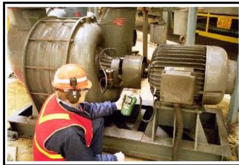
Figura 2.2 – Exemplo de um técnico a realizar uma medição de vibrações a um Grupo Electrobomba.
