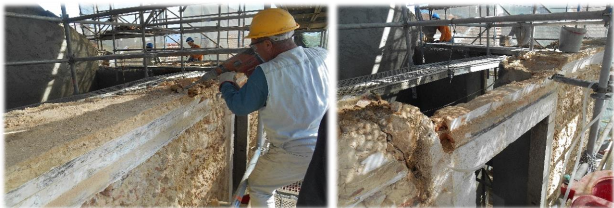
Fig. 82 – Início do processo de execução do lintel de coroamento
