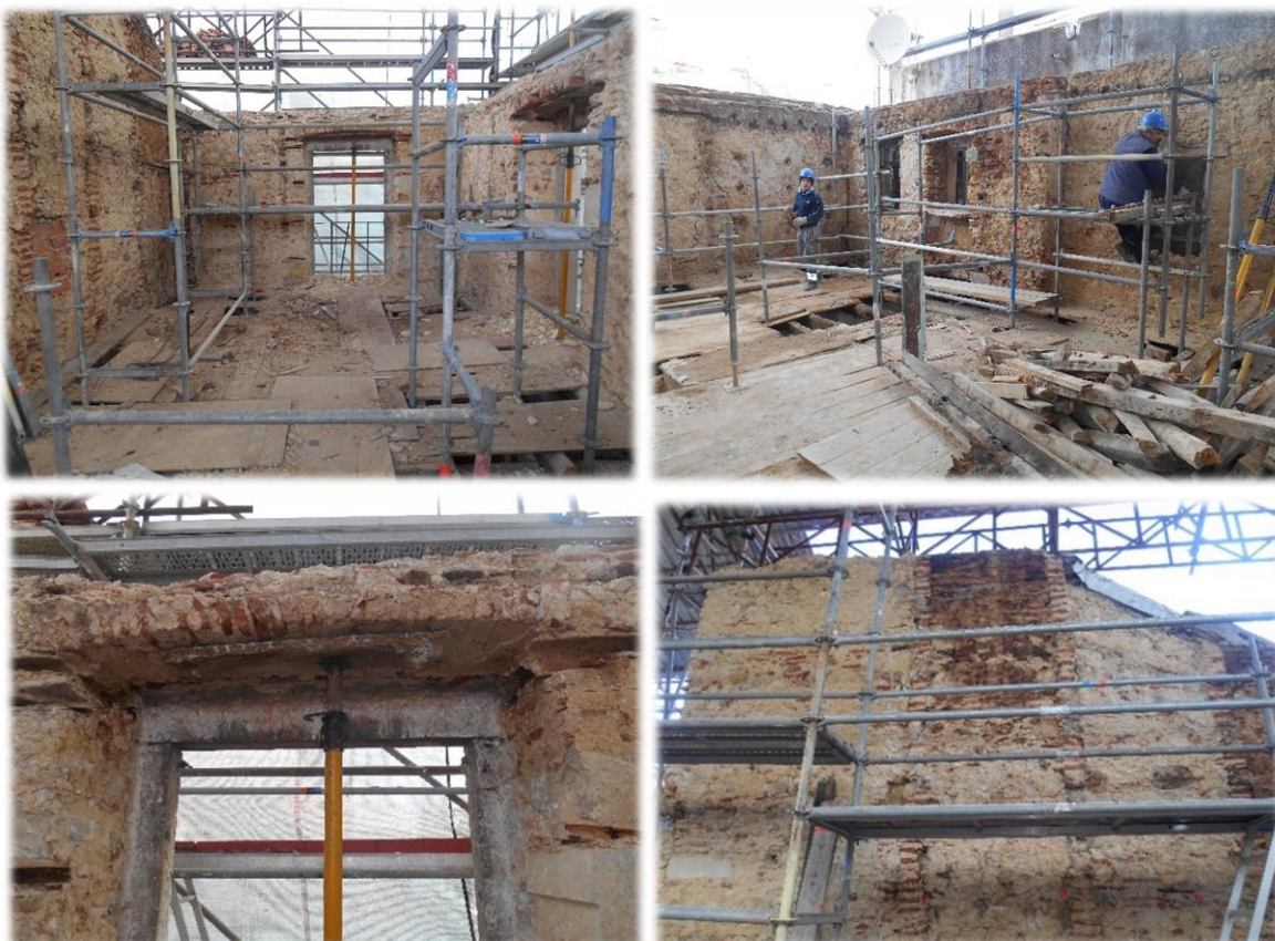
Fig. 70 – Sequência da execução de remoção do suporte existente interior
