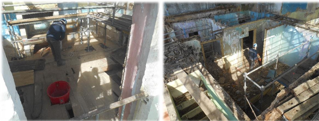
Fig. 69 – Sequência da execução de demolição do 2.º piso
