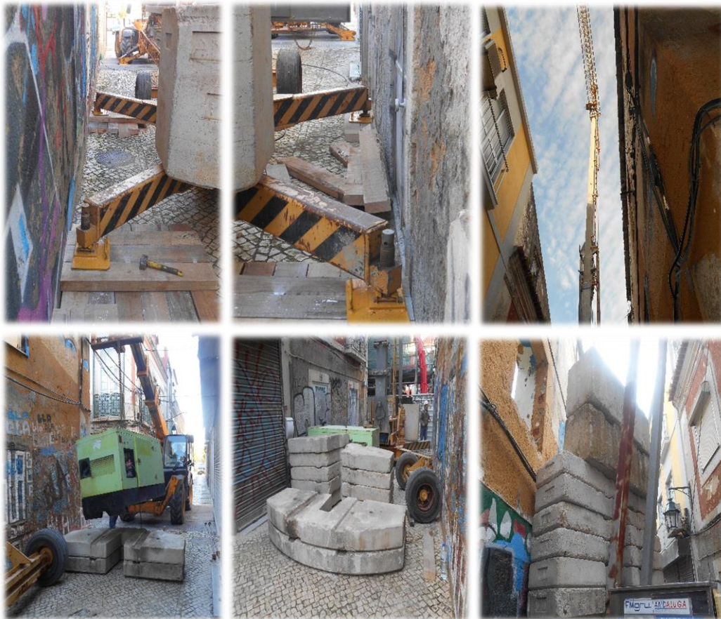
Fig. 64 – Montagem da grua
