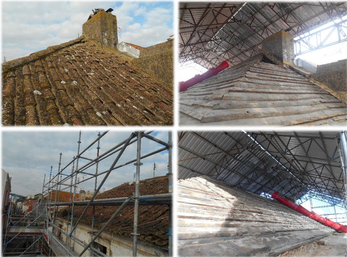
Fig. 67 – Remoção da cobertura existente
