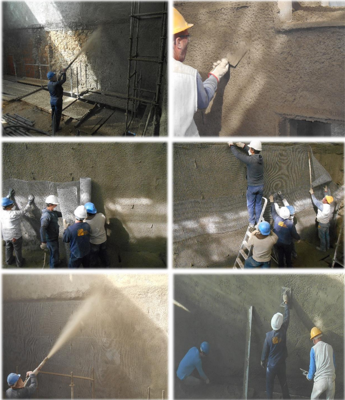
Fig. 78 – Sequência do processo de projeção do betão no 1º piso
