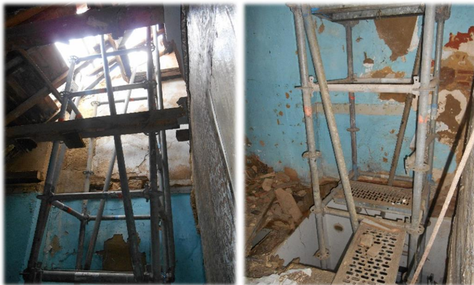
Fig. 66 – Pormenor da estrutura de contrafortes
