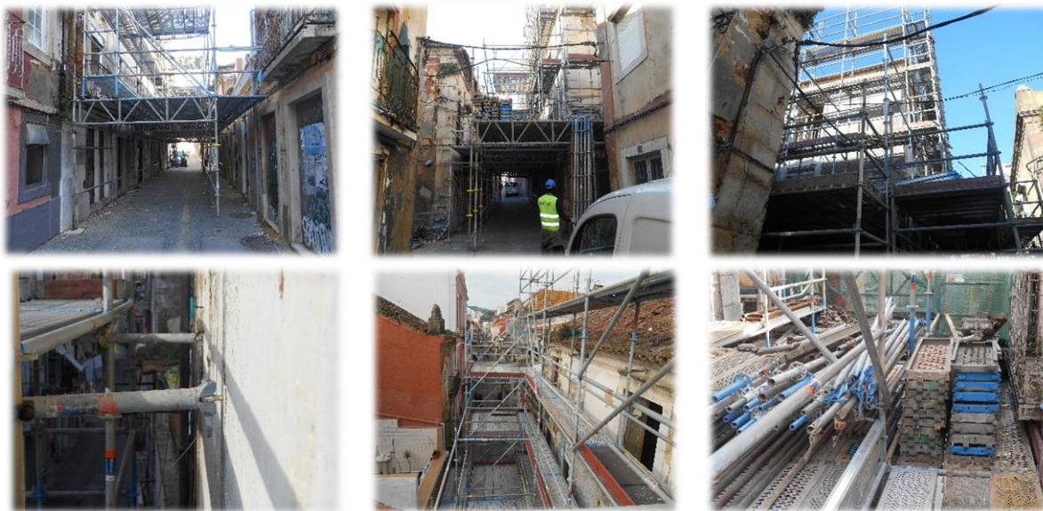
Fig. 60 – Montagem dos andaimes
