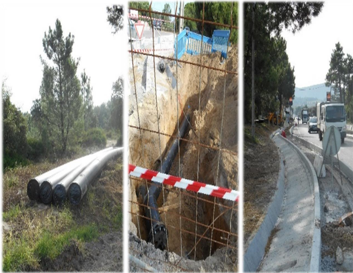
Fig. 9 – Trabalhos de execução de novas condutas para abastecimento de água
