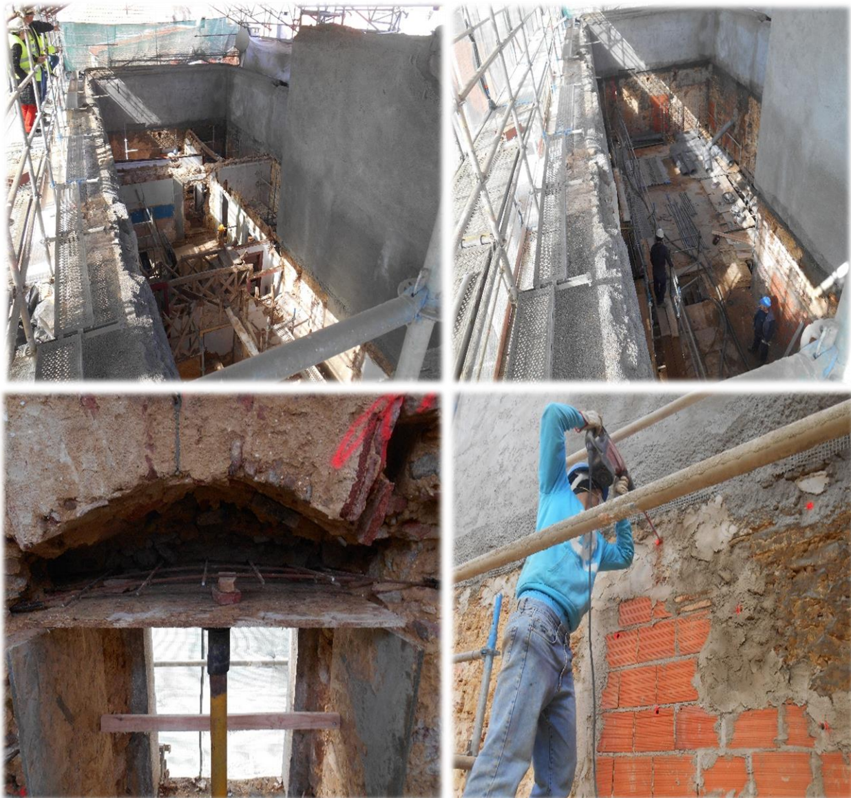
Fig. 77 – Sequência de demolições do pavimento do 1º piso
