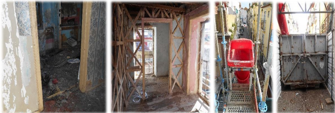
Fig. 62 – Início de demolições interiores
