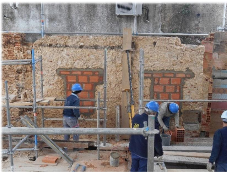
Fig. 71 – Execução de alvenaria de tijolo nas janelas a tardoz
