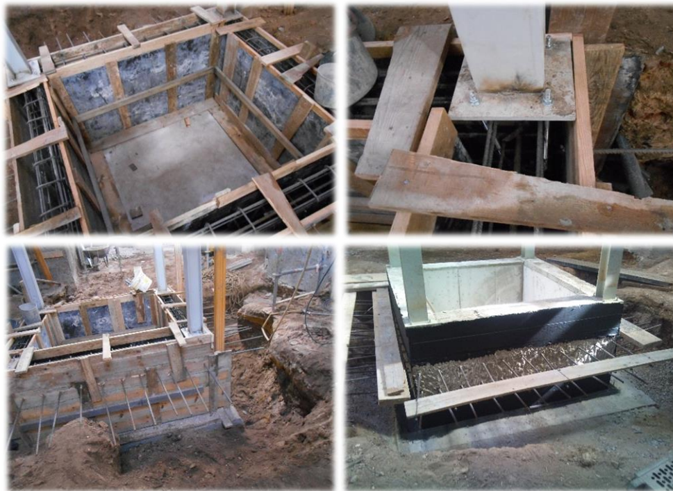
Fig. 90 – Trabalhos de execução da caixa do elevador
