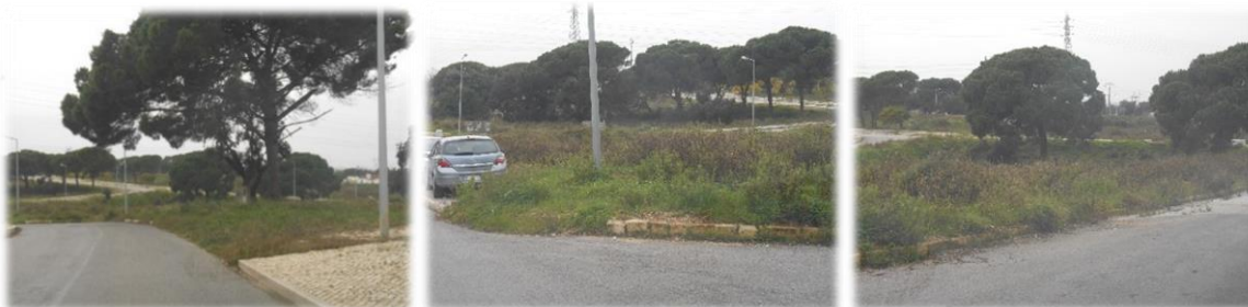
Fig. 14 - Área de calçada de vidro miúdo inexistente e sem lancil
