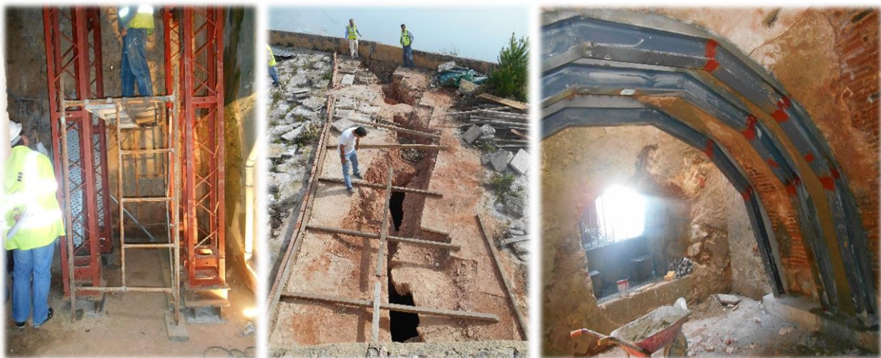
Fig. 7 – Trabalhos de escoramento das abóbadas
