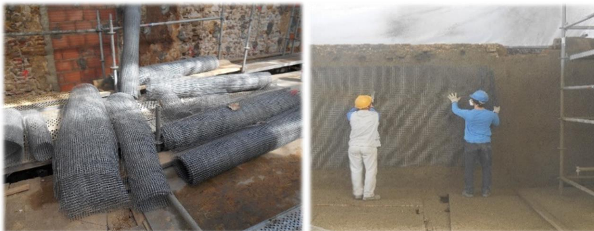
Fig. 74 – Aplicação da rede de fibra de vidro com suporte nos conetores
