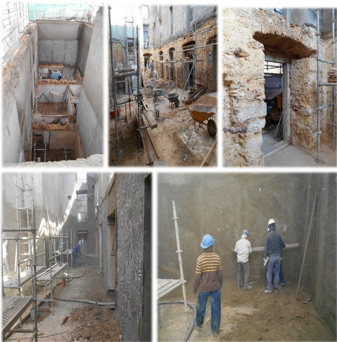
Fig. 79 – Sequência do processo de demolição e projeção do betão no piso 0
