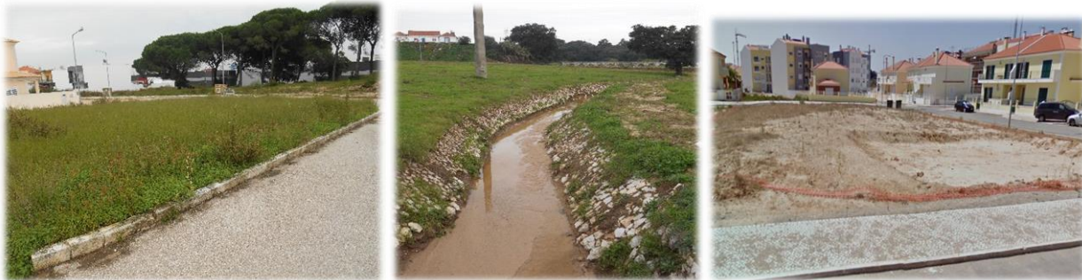
Fig. 20 – Zona de arranjos exteriores inacabada
