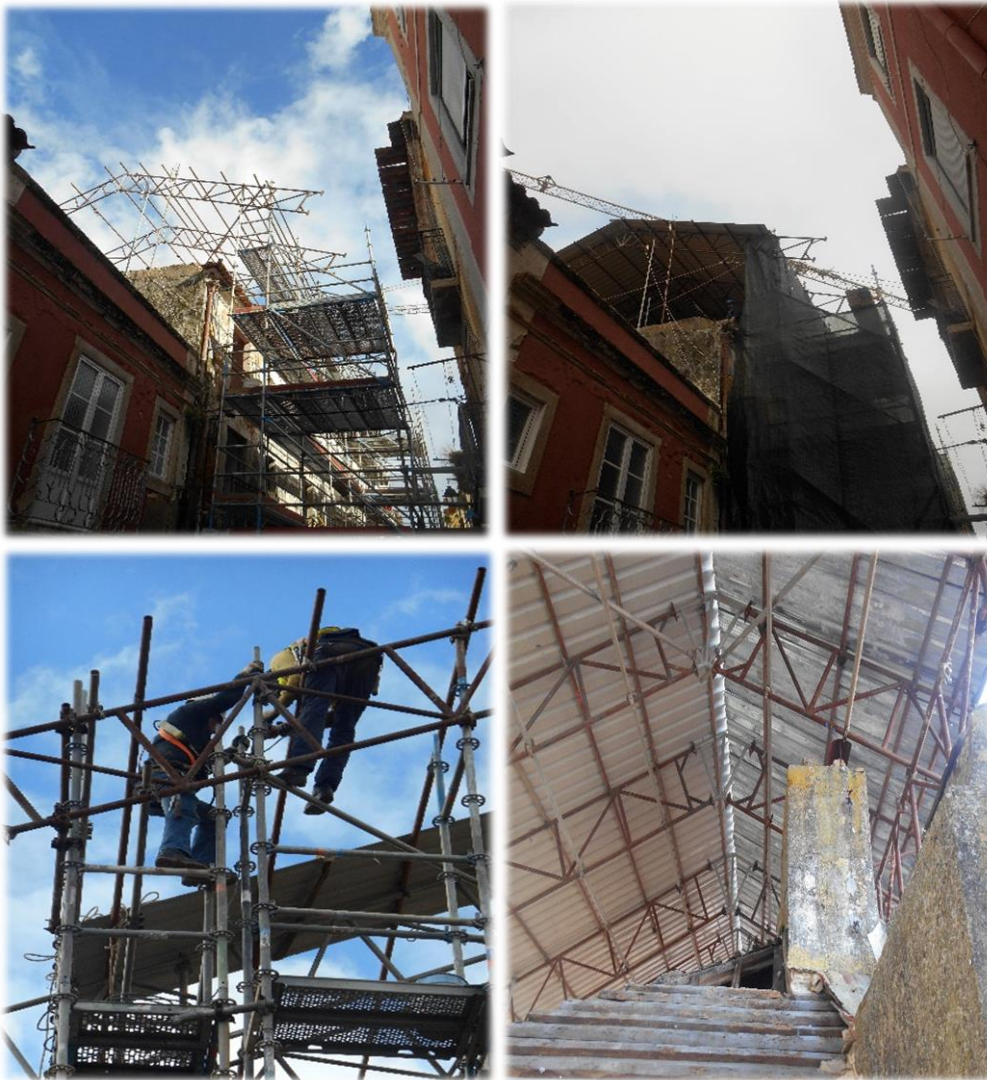
Fig. 65 – Montagem da cobertura provisória
