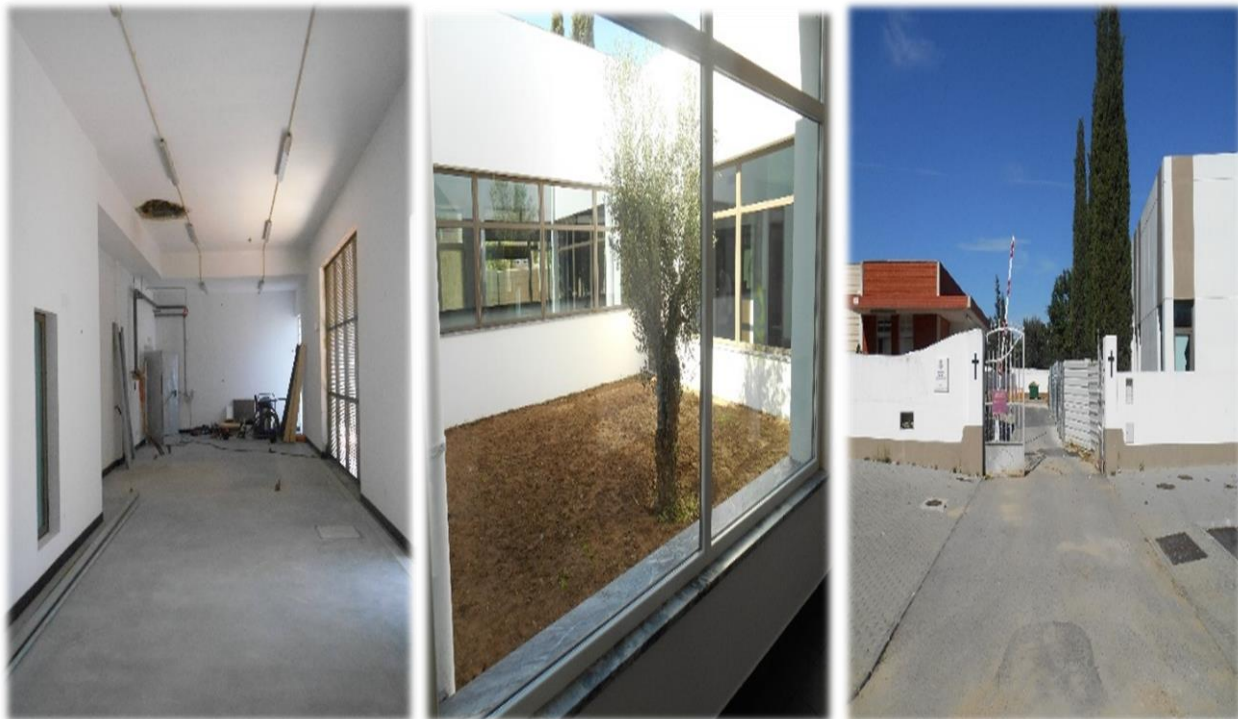
Fig. 8 – Execução do Crematório no Cemitério da Paz
