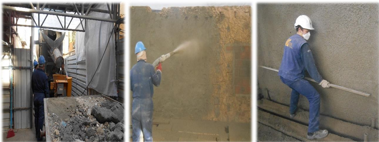
Fig. 73 – Sequência do processo de projeção do betão no 2º piso
