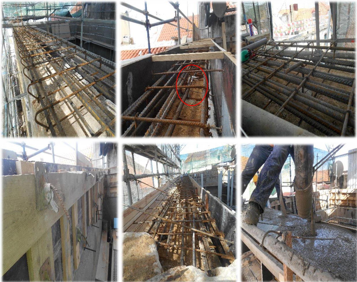
Fig. 83 – Sequência do processo de execução do lintel de coroamento
