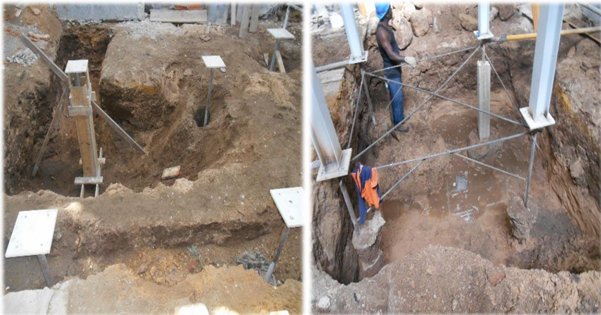
Fig. 87 – Execução de microestacas e apoio de pilares metálicos
