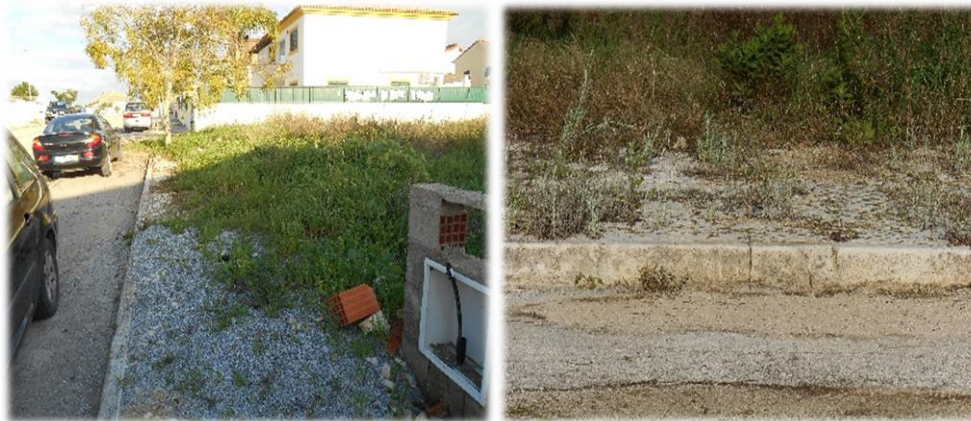
Fig. 18 - Ausência de ramais de ligação doméstica e pluvial
