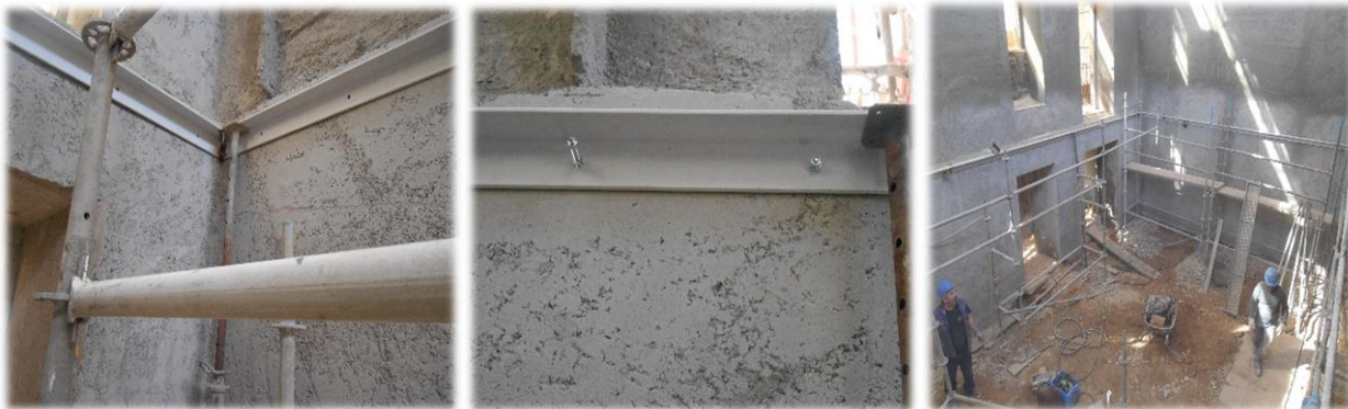
Fig. 81 – Execução de cantoneiras metálicas para suporte das lajes colaborantes
