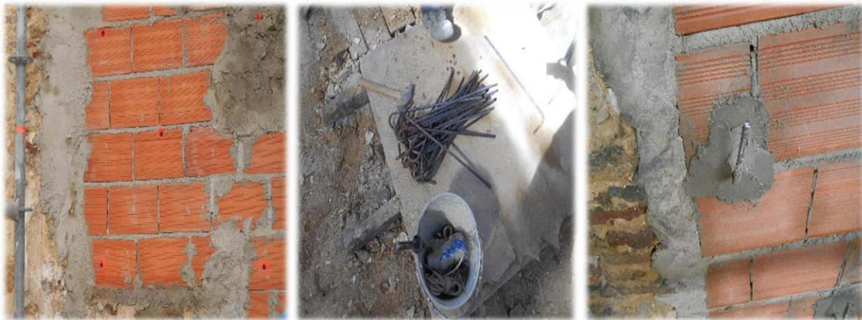
Fig. 72 – Execução de conectores para armação da rede de fibra de vidro
