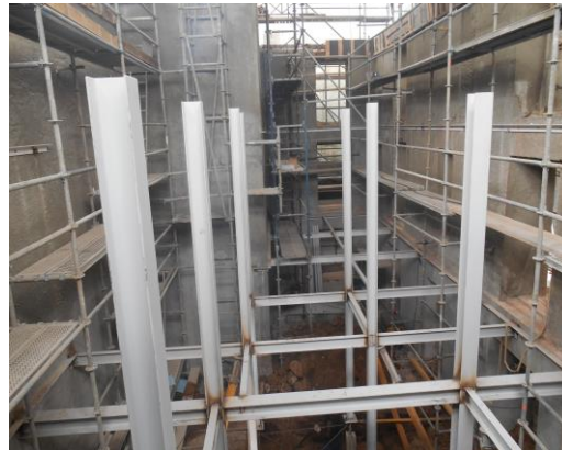
Fig. 89 – Trabalhos de execução da estrutura metálica do 1º piso
