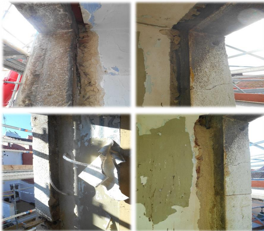
Fig. 63 – Injecções de resinas epóxicas
