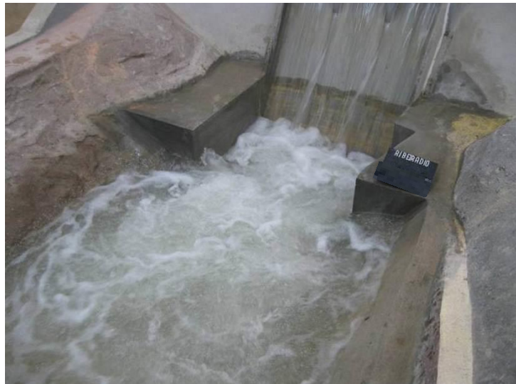
Foto 51- Solução E. Escoamento do caudal 2000 m 3 /s
