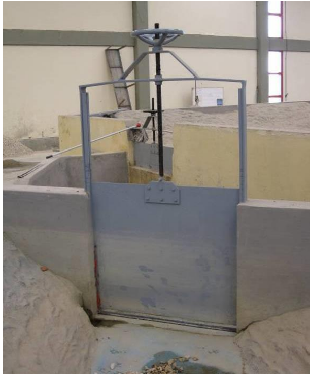
Foto 10 – Comporta a jusante
