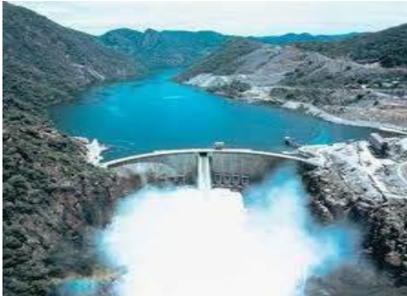
Foto 3– Barragem de Cahora Bassa
