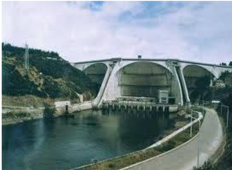
Foto 2– Barragem da Aguieira
