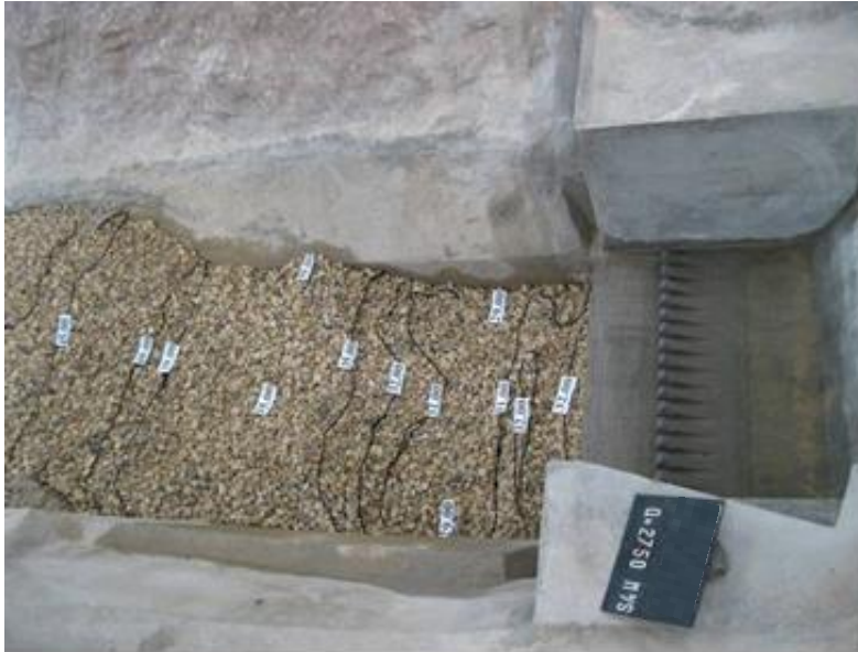
Foto 42 – Solução C. Erosão do leito para o caudal 2750 m 3 /s
