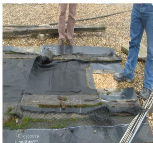
Figura 3.10 – Loulé: amostra exposta sobre uma cobertura.
