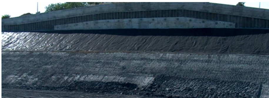
Figura 2.19 – Aplicação de geomembrana na Autoestrada A10 em taludes de escavação em margas para evitar a degradação dos materiais expostos às condições atmosféricas (Cardoso, 2014).
