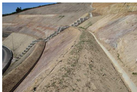
Figura 2.18 – Aplicação de geomembrana em “banquetas vivas” na Autoestrada A21 – Malveira (antes e após reabilitação do talude)
