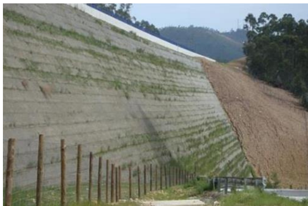
Figura 2.17 – Aterro reforçado com geossintéticos na autoestrada A32.
