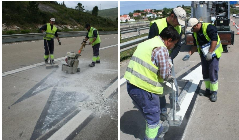
Figura 3.15 – Eliminação de marcas e repintura
