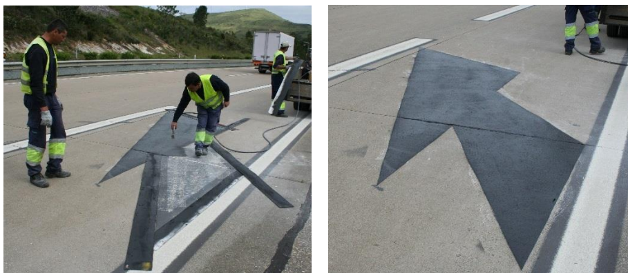
Figura 4.9 – Aplicação de primário sobre pavimento em betão
