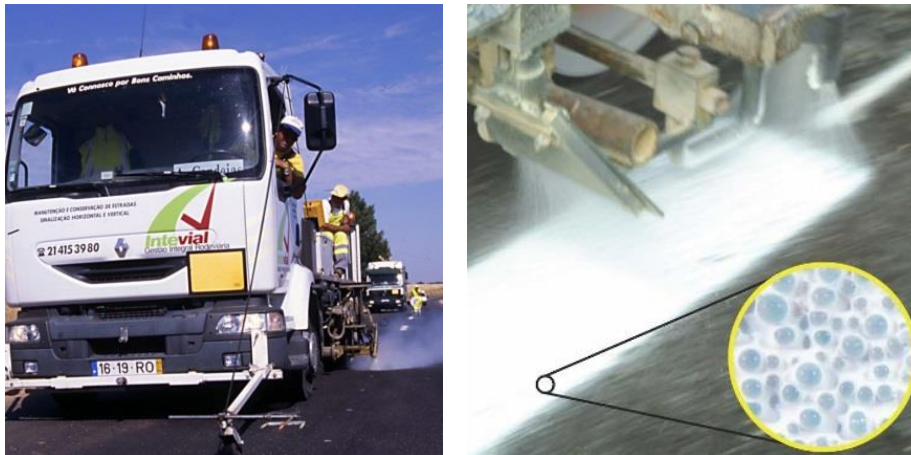
Figura 4.20 – Execução mecânica de marcas rodoviárias [22] [19]
