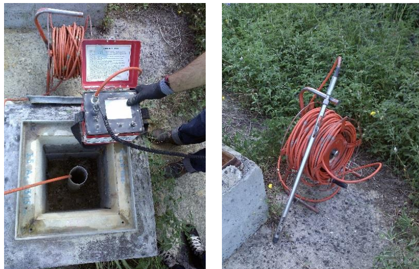
Figura 3.6 – Verificação de deslocamentos nos taludes com inclinómetro
