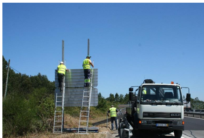
Figura 5.12 – Substituição de painéis laterais na A8
