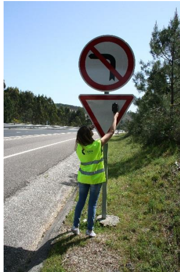
Figura 5.15 – Inspeção estática de sinalização vertical na receção provisória
