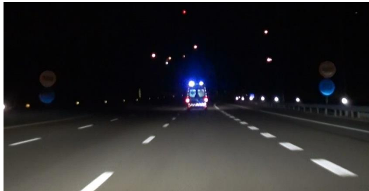
Figura 4.27 – Sinalização vertical com coeficiente de retrorreflexão reduzido
