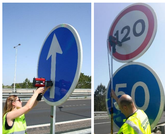
Figura 3.16 – Medição do coeficiente de retroreflexão da sinalização vertical
