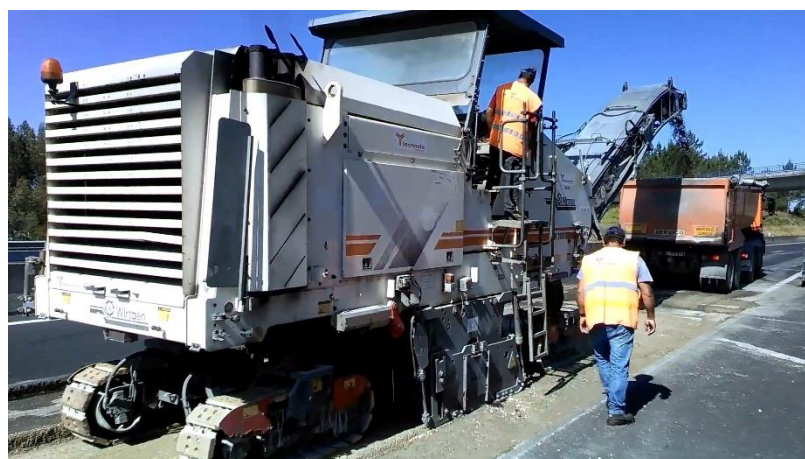
Figura 3.20 – Fresagem do pavimento na A15
