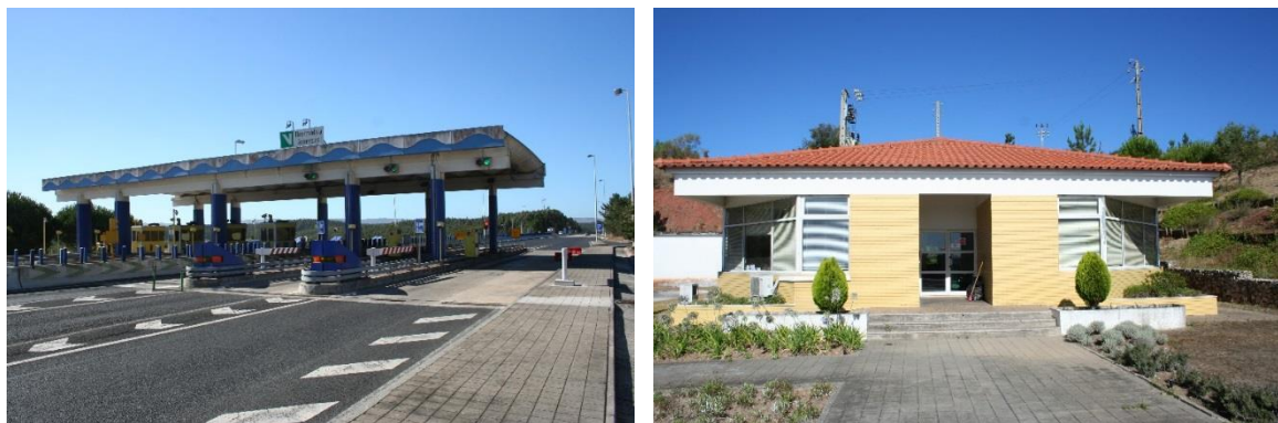
Figura 3.4 – Portagem de plena via e edifício de apoio na A8 (Bombarral)
