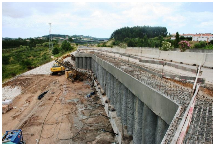
Figura 3.22 – Estabilização de talude na A15 ao km 6+150
