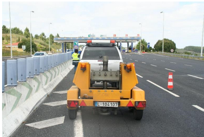
Figura 3.10 – Ensaio do pavimento com defletómetro de impacto
