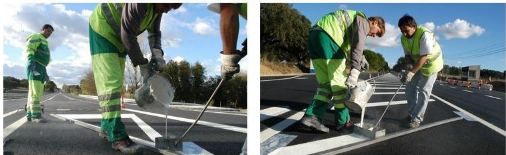
Figura 4.19 – Execução manual de marcas rodoviárias [22]
