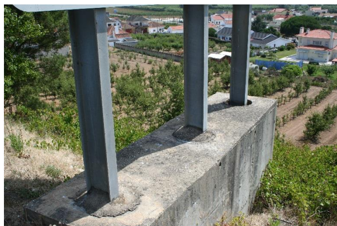
Figura 4.26 – Maciço de fundação de painel de sinalização
