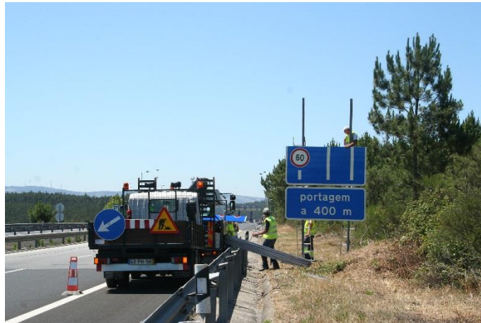
Figura 3.19 – Substituição de painel lateral na A8 (portagem do Bombarral)
