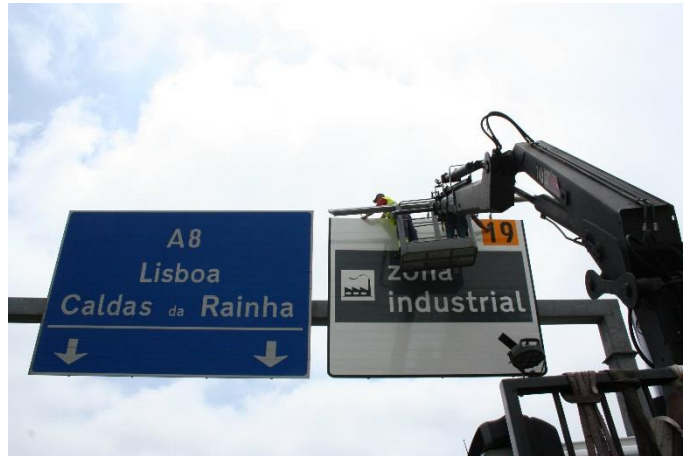
Figura 4.25 – Montagem de painel de sinalização na A8
