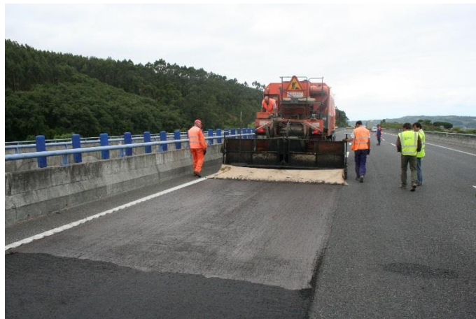
Figura 3.21 – Aplicação de microaglomerado betuminoso a frio ( slurry )
