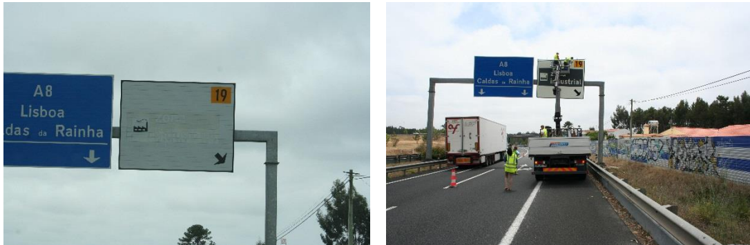
Figura 5.13 – Substituição de painéis em pórtico na A8
