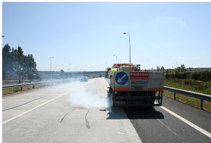
Figura 3.18 – Repintura de marcas rodoviárias na A8 com equipamento móvel
