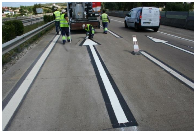
Figura 4.18 – Execução de sinalização em pavimento de betão na A8
