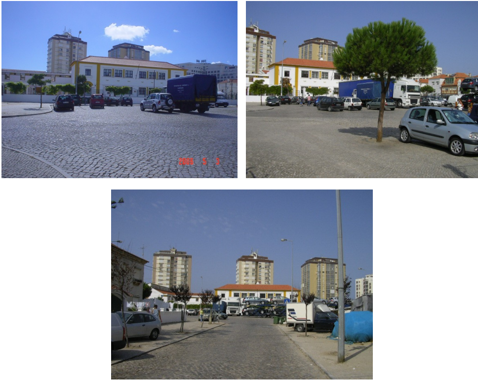
Figura 4.10 – Imagens da zona envolvente à Escola – Praça – antes da intervenção
