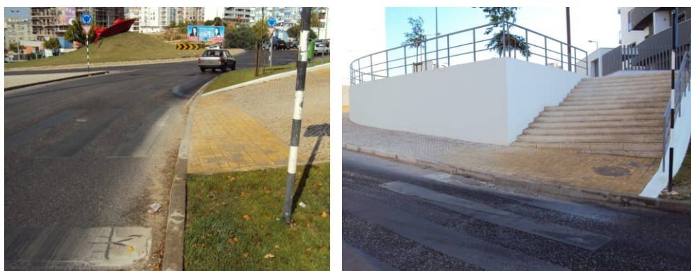
Figura 5.10 – Condições de acesso à travessia
