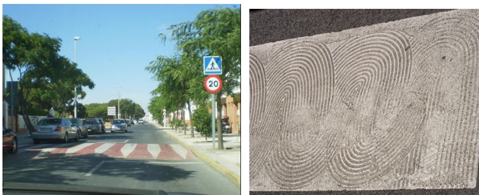
Figura 5.13 – Exemplos sinalização horizontal em passeadeiras (Espanha)
