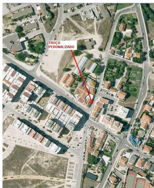
Figura 5.19 – Imagem do local antes da intervenção (Fonte: Google)
