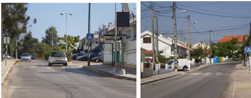
Figura 6.4 – Passadeiras com sobrelevação do pavimento
