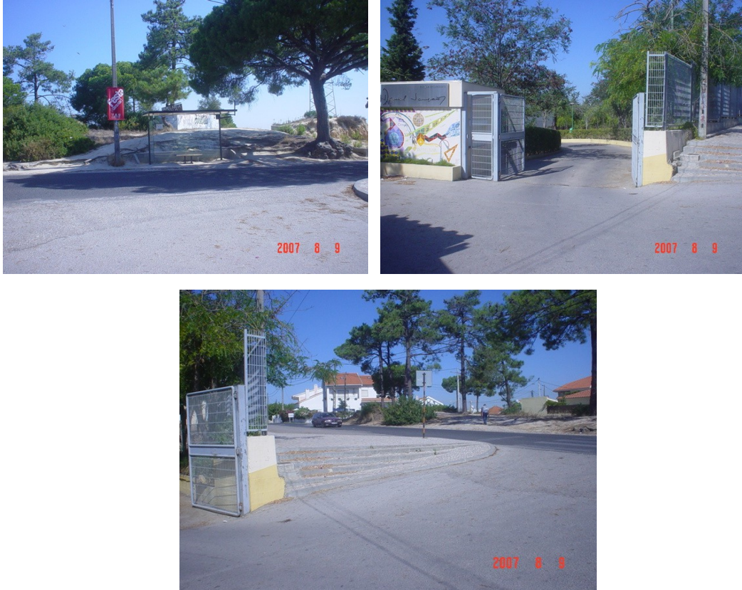
Figura 4.7 – Imagens da entrada da Escola Secundária antes da intervenção
