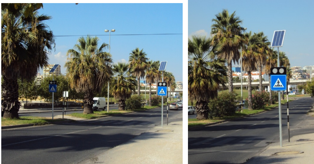
Figura 6.7 – Fotografias da Passadeira com a sinalização instalada
