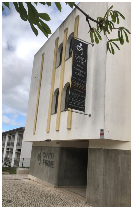
Figura 3 – Escola de Música de Canto Firme em Tomar
