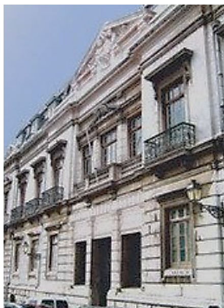
Figura 1 – O Conservatório Nacional na Rua dos Caetanos em Lisboa até 2018
