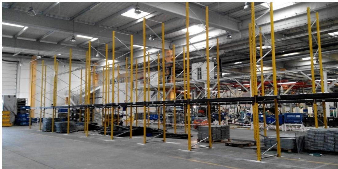
Figura 3.33: Montagem das estantes (Fonte: Schnellecke Portugal , 2015)
