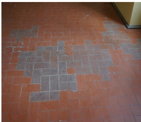
Figura 22 – Reparação dos empolamentos e das fissuras no pavimento
