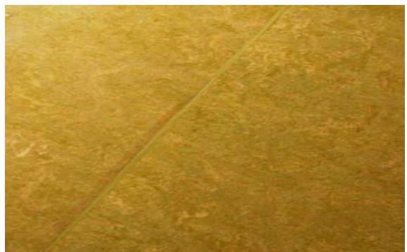
Figura 28 – Resultado final da junta termosoldada
