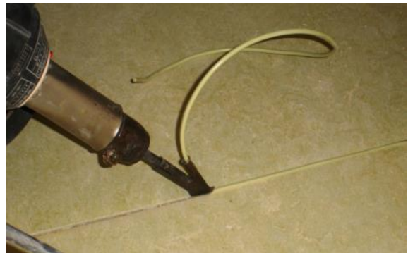
Figura 26 – Aplicação do cordão de soldar com pistola de ar quente
