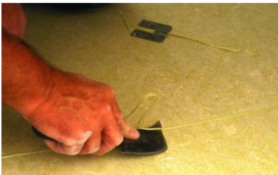
Figura 27 - Remoção do cordão de soldar em excesso aplicado
