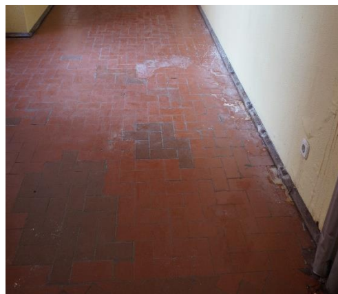
Figura 23 – Reparação dos empolamentos do pavimento
