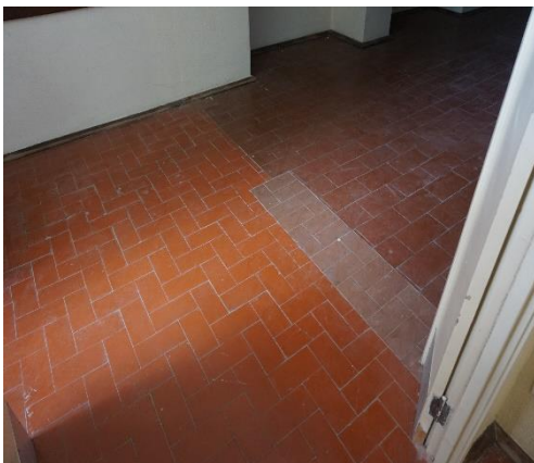
Figura 20 – Reparação dos empolamentos do pavimento
