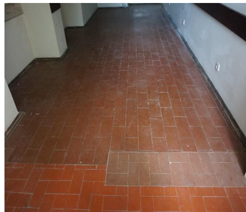
Figura 21 – Reparação dos empolamentos do pavimento
