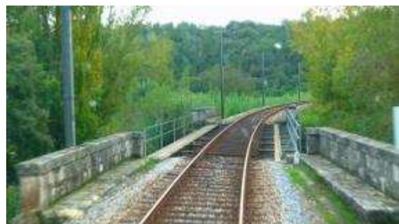
Figura 5-7 Pontão Metálico ( Pk 5+297)
