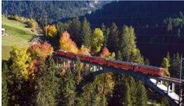
Figura 3-5 Viaducto de Langwies, Suíça [9]
