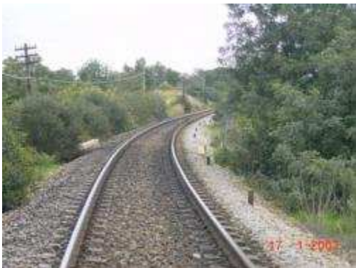
Figura 4-18 Estacas de piquetagem [13]
