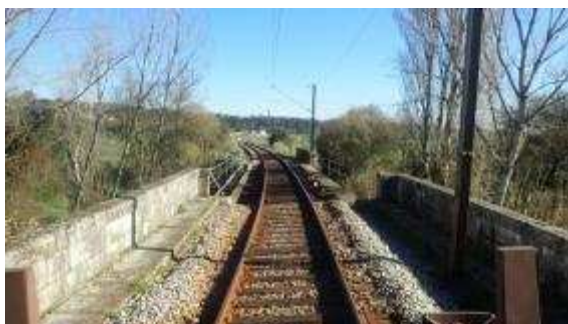
Figura 5-6 Pontão Metálico ( Pk 5+297)
