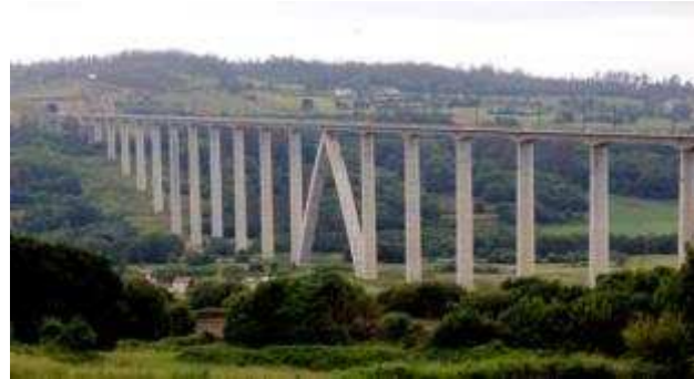
Figura 3-6 Viaduto Arroyo del Valle, linha Madrid-Valladolid [10]
