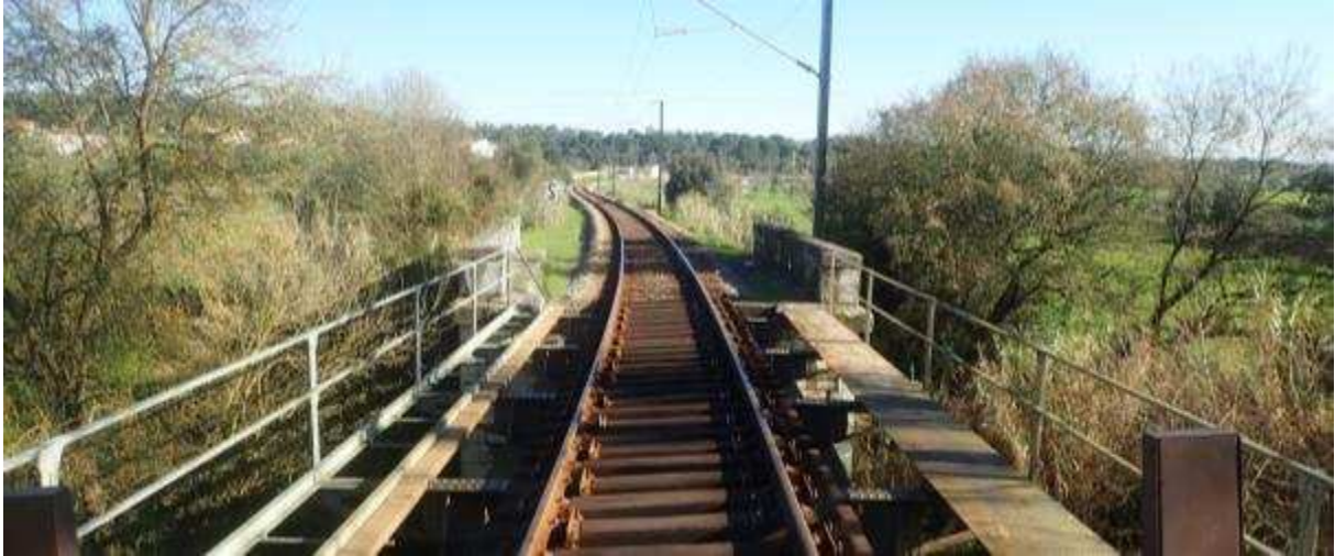
Figura 5-8 Pontão Metálico ( Pk 5+297)
