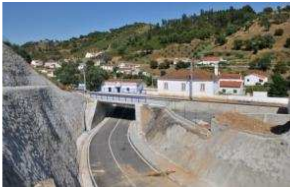
Figura 4-14 Passagem inferior rodoviária [29]
