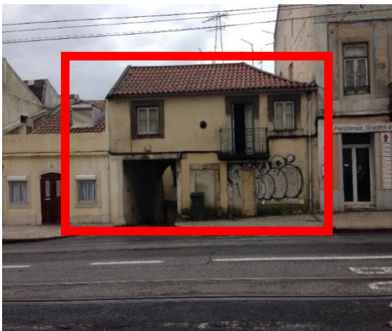
Figura 4 – Rua da Junqueira, 245 e 247
