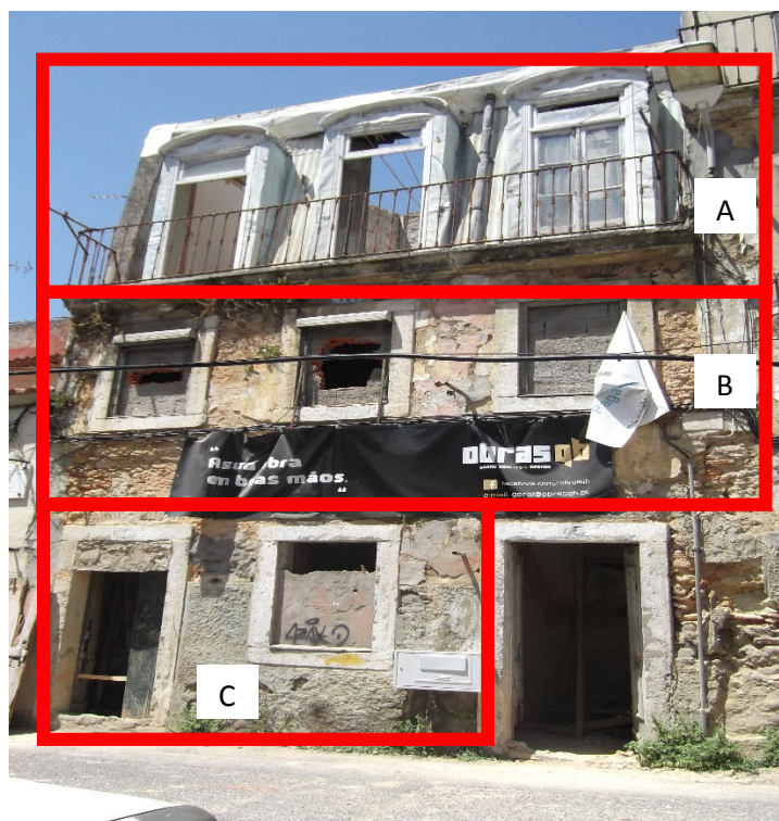
Figura 8 – Fachada, Rua das Barracas, 69
