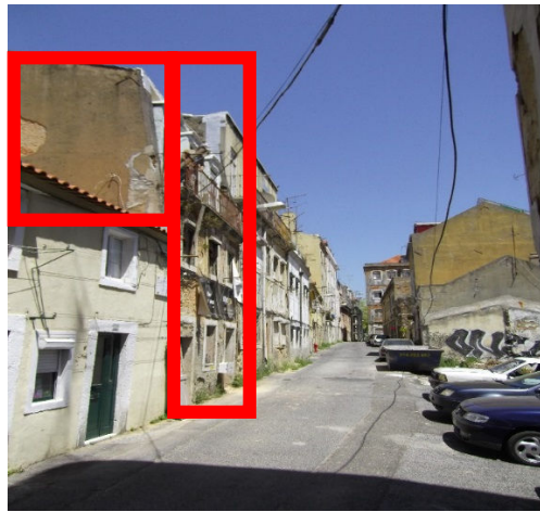
Figura 9 - Rua das Barracas
