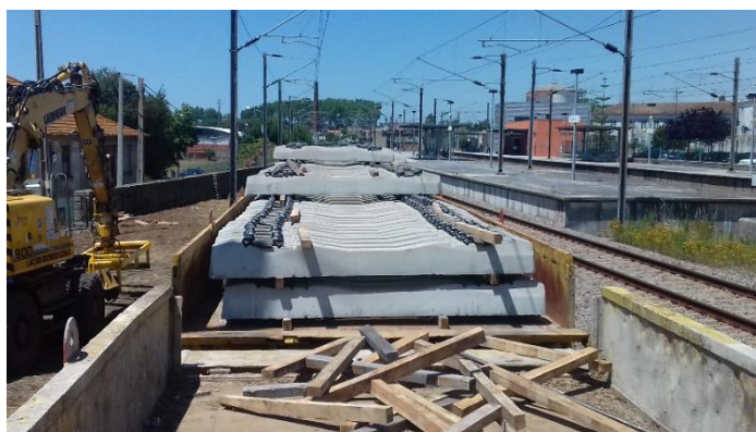
Figura 4.11 - Acondicionamento da carga nos vagões.
