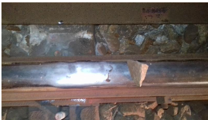
Figura 3.52 - Barretas de reforço instaladas.
