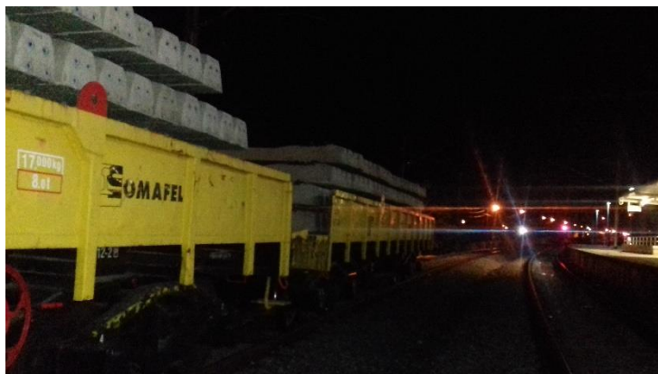
Figura 4.12 - Comboio carregado em distribuição de travessas.
