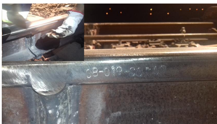
Figura 4.50 - Marcação das soldaduras.
