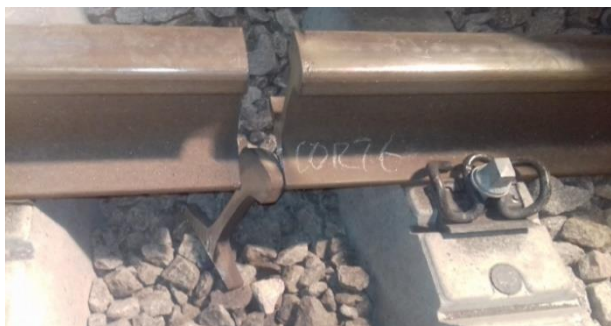
Figura 4.39 - Zona de corte de carril em excesso.
