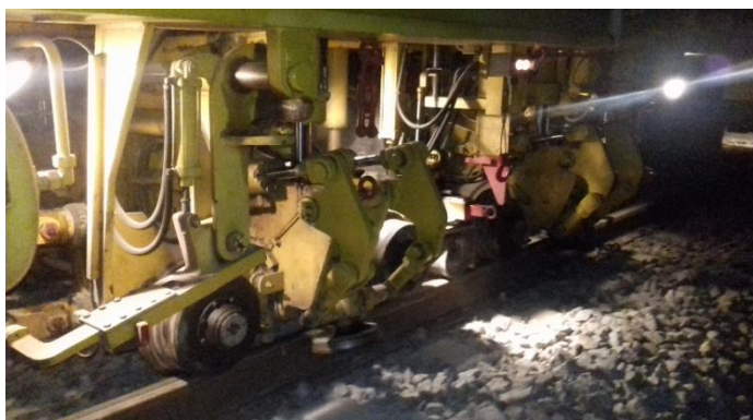
Figura 4.32 - Estabilização da via.
