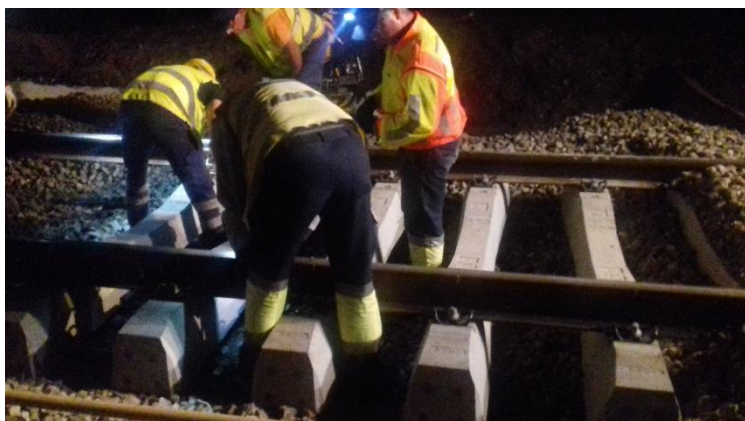
Figura 4.23 - Intervenção da equipa responsável pelos equipamentos de sinalização.
