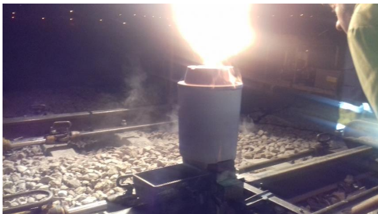
Figura 4.41 - Soldadura aluminotérmica, ao Km 286.851.
