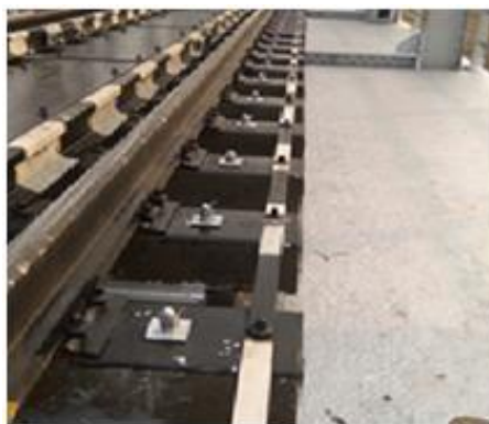
Figura 3.32 - Travessas em material compósito. [47]
