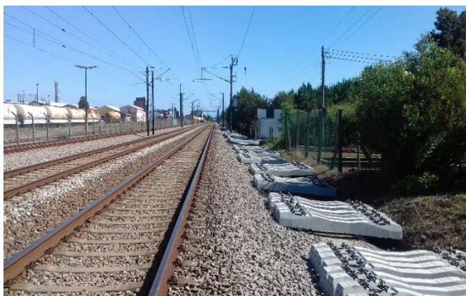
Figura 4.15 - Travessas distribuídas ao longo da via.
