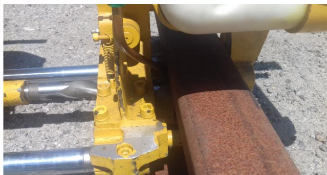
Figura 3.51 - Furação de carril para colocação de barretas.
