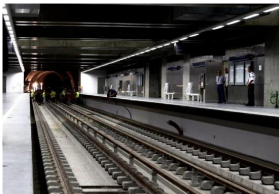
Figura 3.18 - Apoio discreto com travessas assentes.
