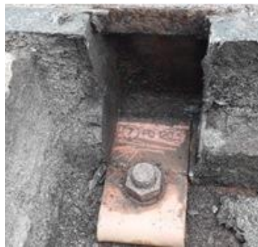
Figura 3.43 - Fixação tipo RNP/GUIDE/PRX120. (Ricardo Magalhães, Somafel, 2019)
