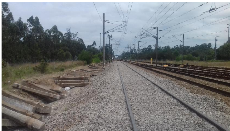
Figura 4.35 – Troço finalizado após segundo ataque pesado.
