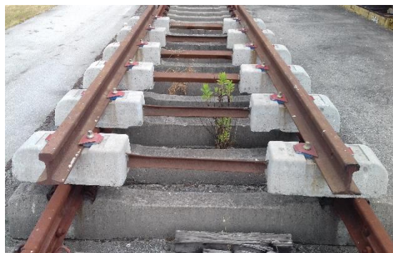
Figura 3.30 - Travessas bi-bloco em cima, Travessas monobloco em baixo.
