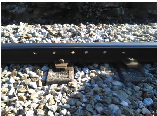
Figura 2.14 - Substituição de JIC por fecho.
