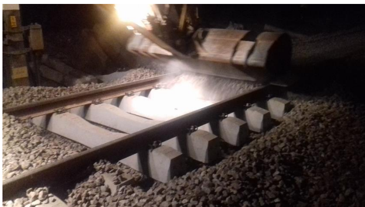
Figura 4.22 – Guarneçamento das novas travessas.
