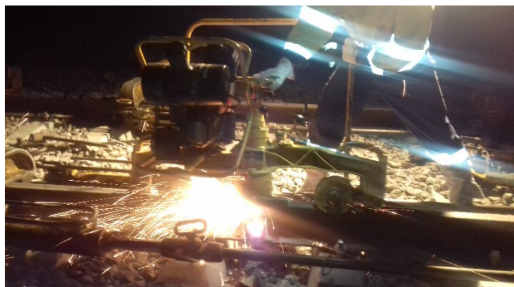
Figura 4.43 - Esmerilagem de soldadura.
