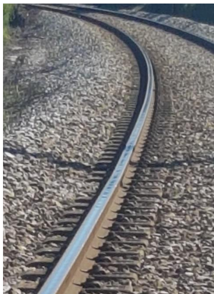
Figura 3.40 - Desgaste ondulatório (Linha da Beira Alta, Km 118.924).
