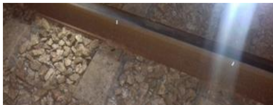
Figura 4.17 - Marcação de colocação das travessas.
