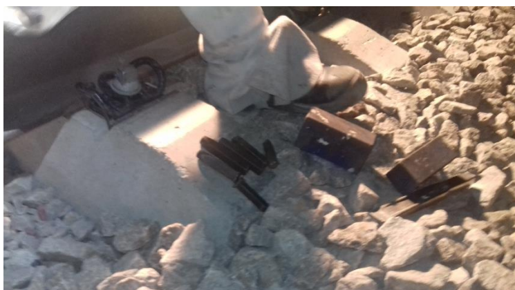
Figura 4.49 - Conjunto de “ferros” para marcação de identificação das soldaduras.
