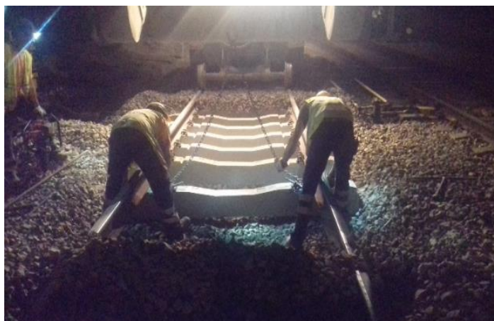
Figura 4.21 - Instalação de travessas novas.
