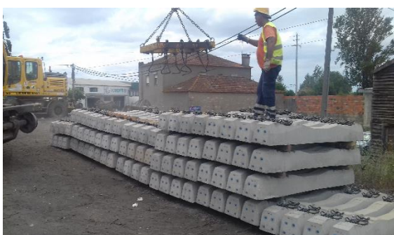
Figura 4.5 - Empilhamento de travessas em estaleiro.
