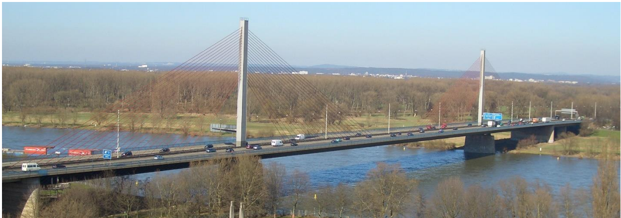
Figura 2.16 - Ponte Friedrich Ebert, Alemanha (1967).
