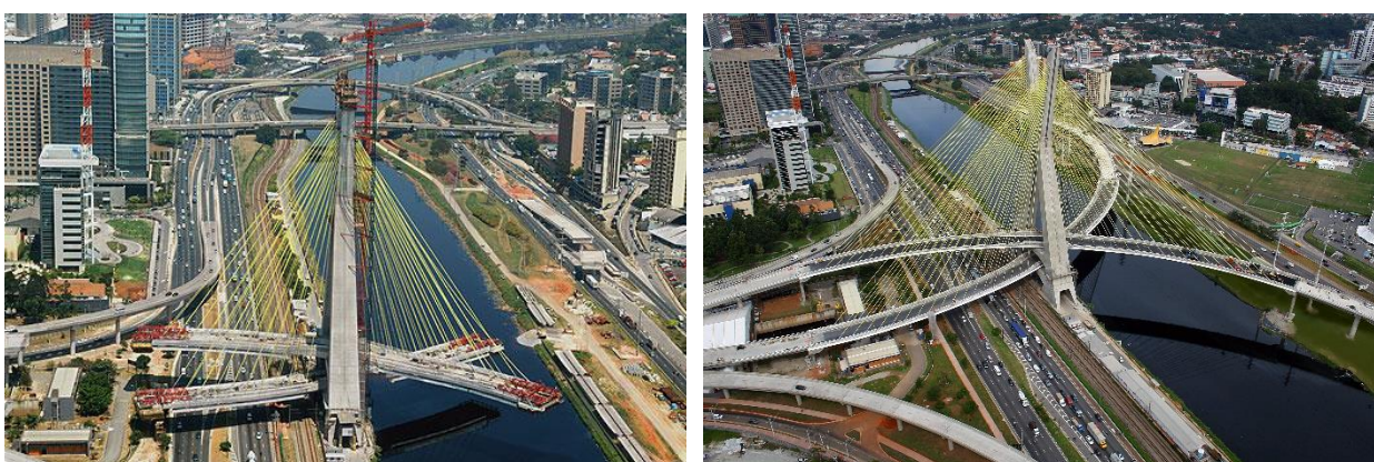
Figura 2.7 - Ponte Octavio Frias de Oliveira, Brasil (2008): a) fase de construção; b) em serviço.
