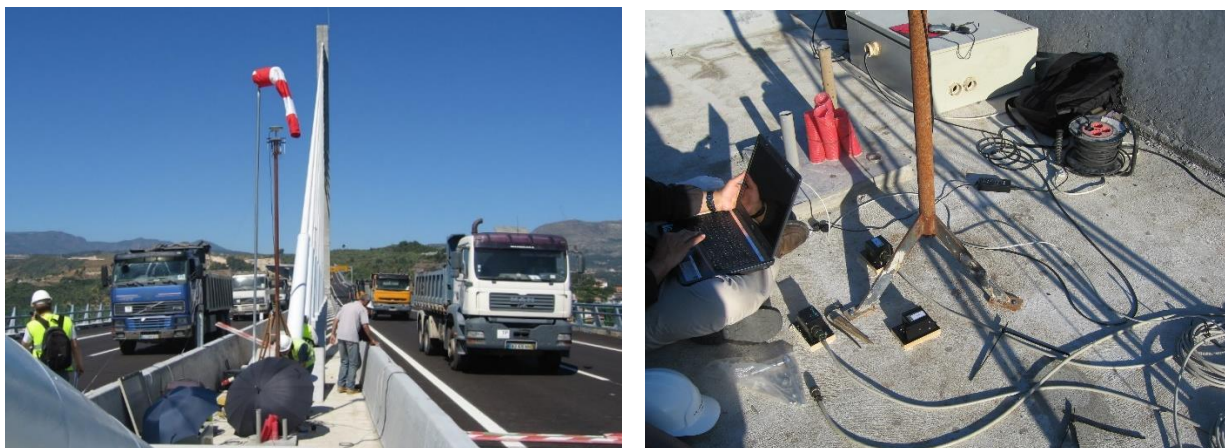
Figura 5.12 - Medição de vibrações durante os ensaios de carga, no viaduto do Corgo (Wenzel & Pichler, 2005).
