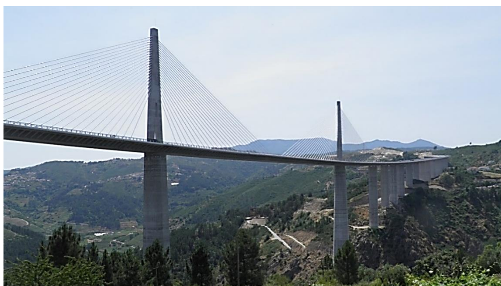
Figura 1.1 - Viaduto do Corgo.
