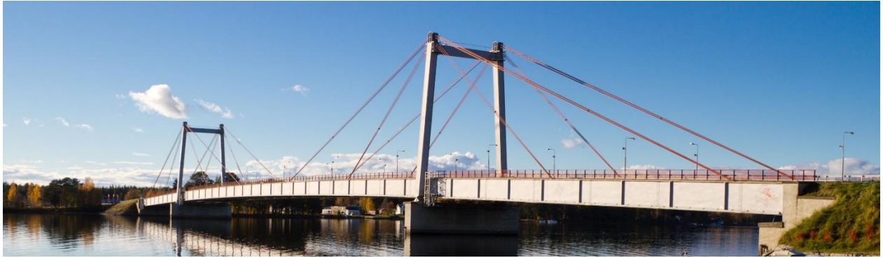
Figura 2.3 - Ponte de Strömsund, Suécia (1956).
