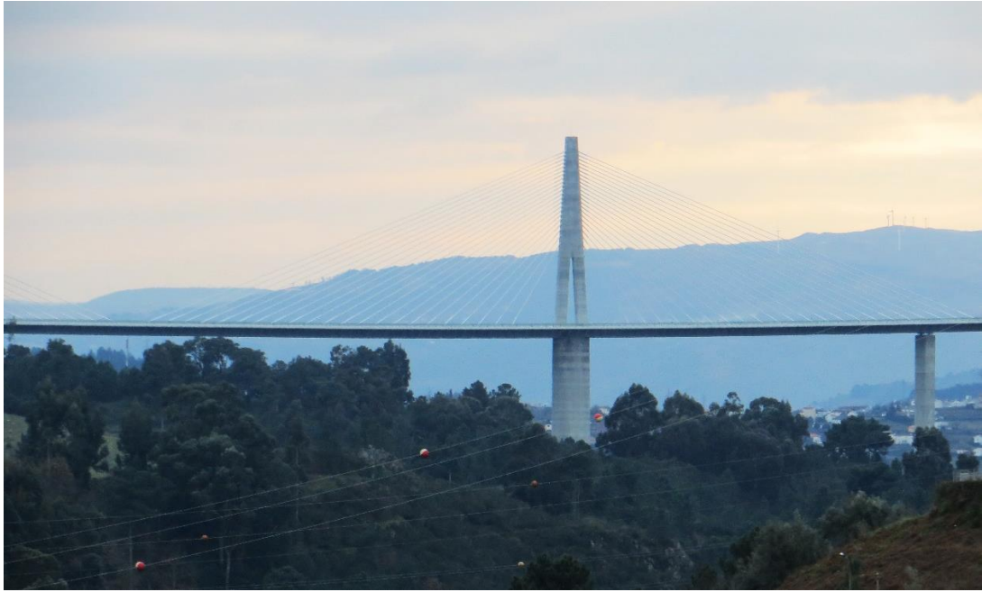
Figura 5.6 - Vista lateral de um mastro do viaduto do Corgo.
