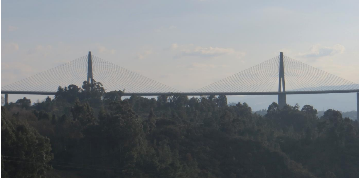
Figura 5.4 - Vista lateral do viaduto do Corgo.
