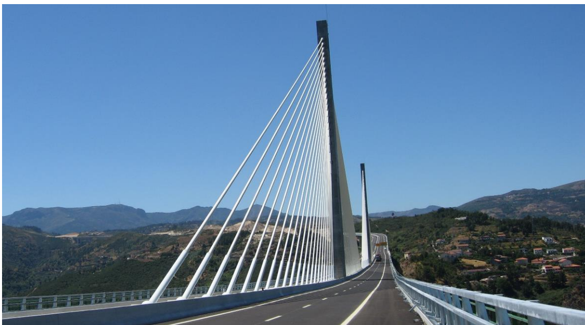
Figura 2.12 - Ponte atirantada com suspensão central (viaduto do Corgo, Portugal, 2014).
