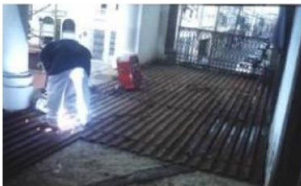
Figura 3.14 - Substituição integral do antigo pavimento em madeira [Branco et al , 2004]
