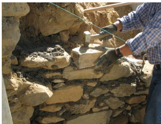
Figura 2.4 - Construção de um muro em alvenaria de pedra ordinária; S. Vicente da Beira, Castelo Branco
