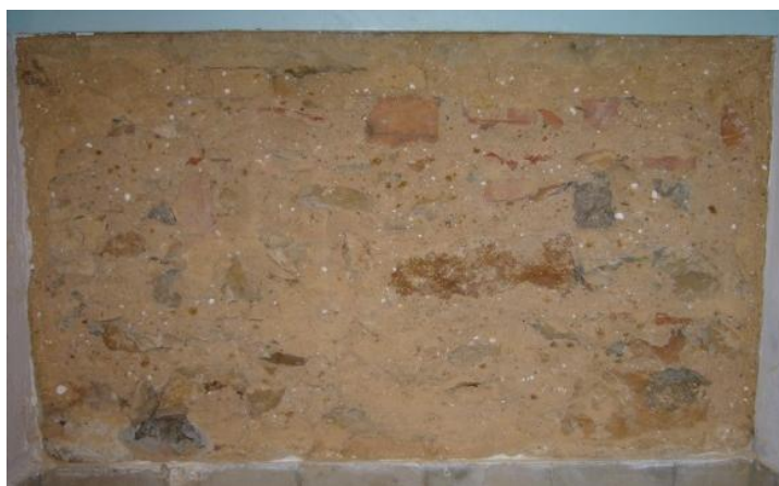
Figura 2.3 – Parede em alvenaria de pedra ordinária, Parede, Cascais
