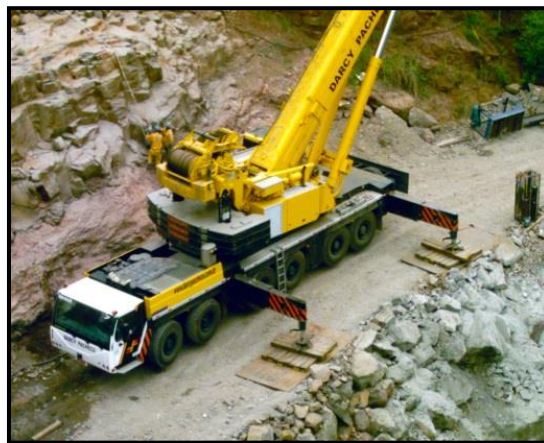
Figura 3.7 - Exemplo da grua utilizado para a plataforma [s35].
