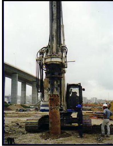
Figura 3.10 - Execução das estacas [s27].
