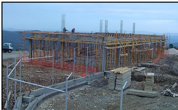
Figura 3.13 - Edifício de comando [2].
