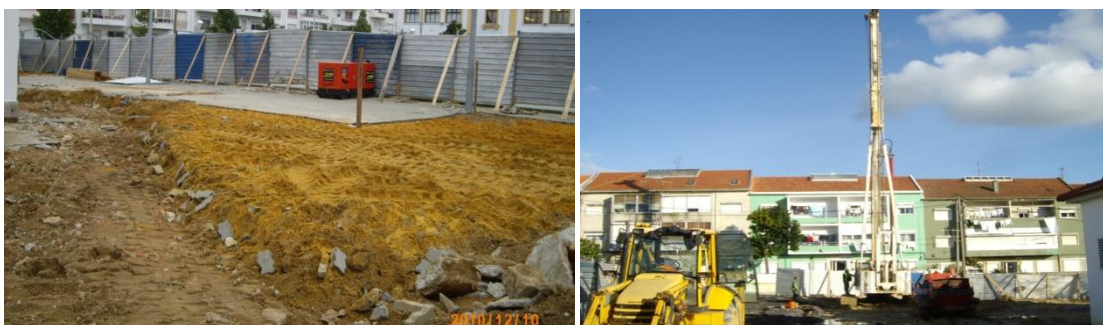
Fig. 12 e 13 – Movimentação de terras e execução de estacas de betão armado.
