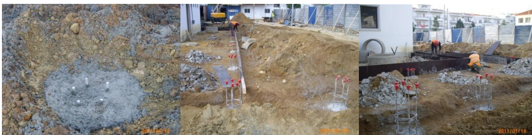
Fig 16, 17 e 18 – Saneamento da cabeça das estacas.
