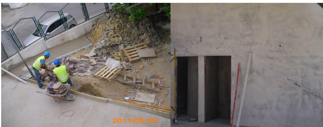
Fig 84 e 85 – Betonilha da rampa e revestimento em estuque.
