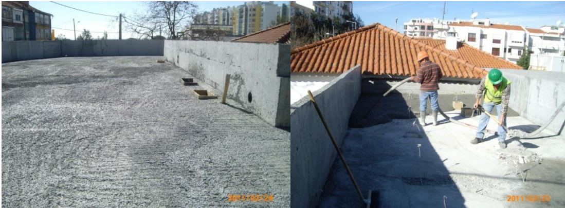
Fig 38 e 39 – Laje da cobertura betonada e aplicação da betonilha.
