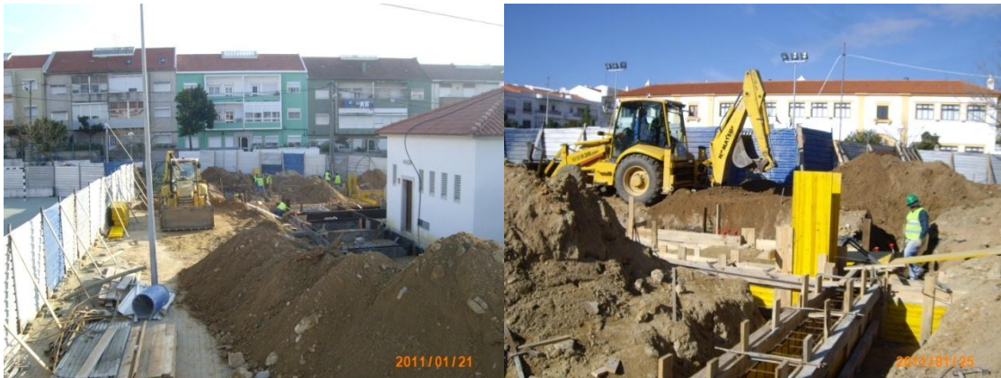
Fig 19 e 20 – Cofragem das vigas de fundação.
