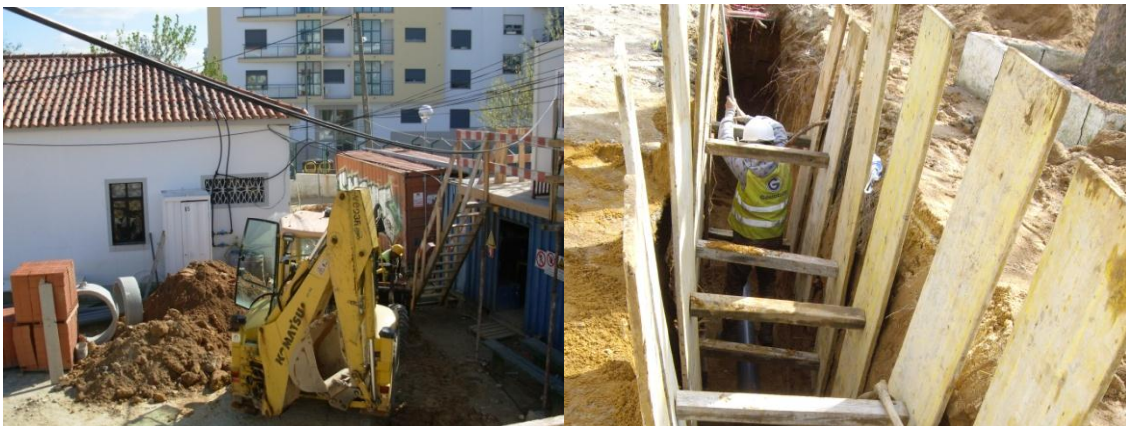
Fig 40 e 41 – Execução da rede de esgotos com entivação.
