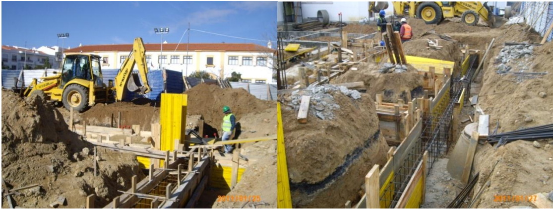
Fig 23 e 24 – Cofragem e armação das vigas de fundação.
