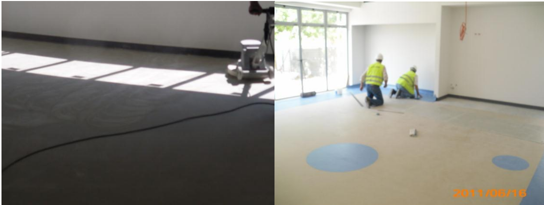
Fig 102 e 103 – Preparação da superfície e posterior aplicação de vinílicos.
