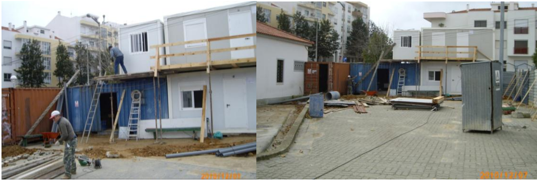
Fig. 10 e 11 – Montagem e vista do interior do Estaleiro.
