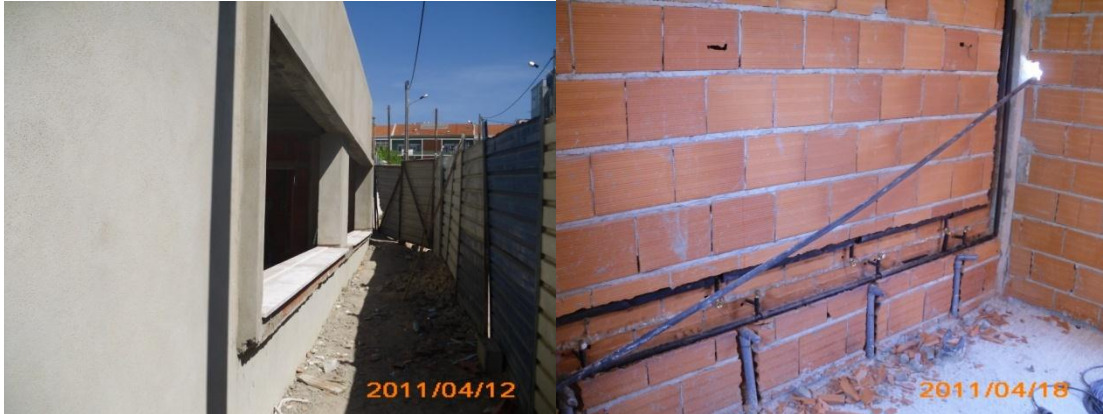
Fig 60 e 61- Molduras dos envidraçados e colocação de tubagens.
