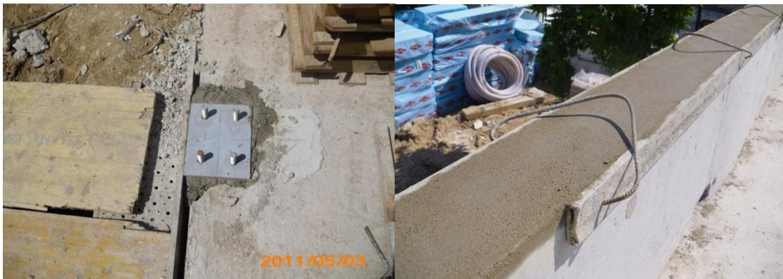
Fig 74 e 75 – Colocação de chumbadouros e execução de meio fio.
