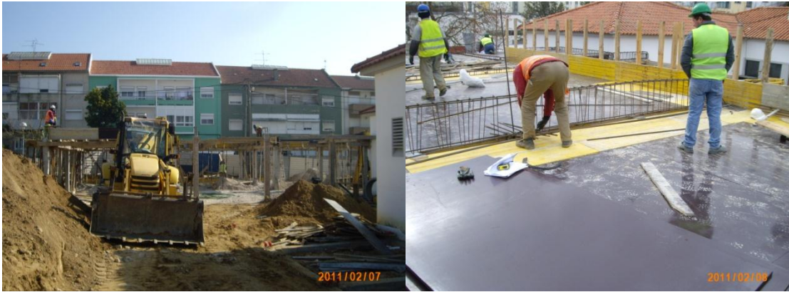
Fig 31 e 32- Cofragem das vigas e armação da laje.
