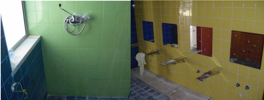
Fig 108 e 109 – Colocação de equipamento sanitário.
