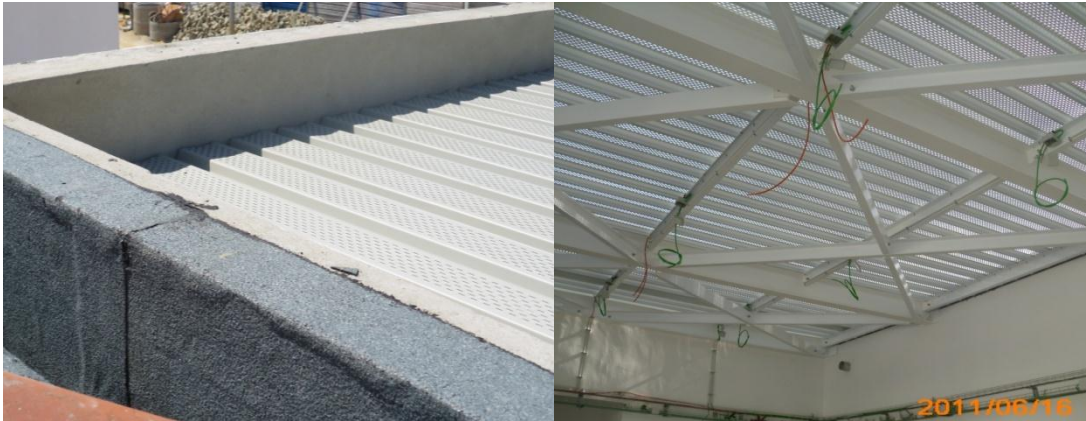
Fig 98 e 99 – Estrutura metálica e revestimento da cobertura.
