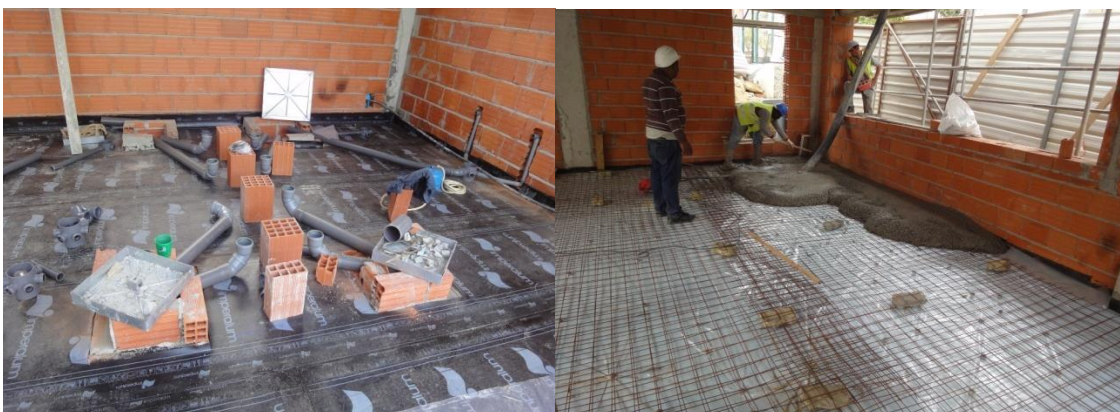
Fig 52 e 53 – Tubagem nas IS e betonagem do pavimento.
