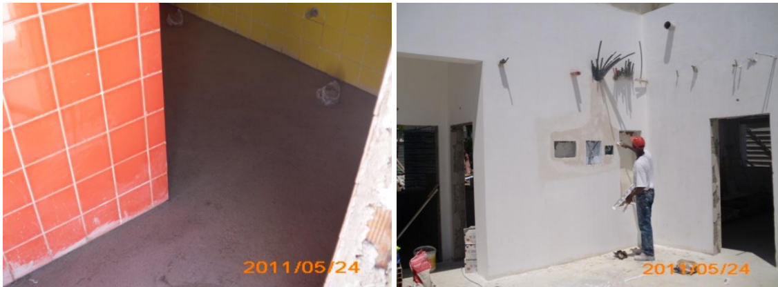
Fig 86 e 87 – Betonilha e reparação de estuque.
