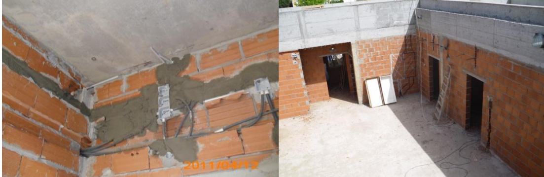
Fig 62 e 63 – Refechamento dos roços e betão no pavimento.
