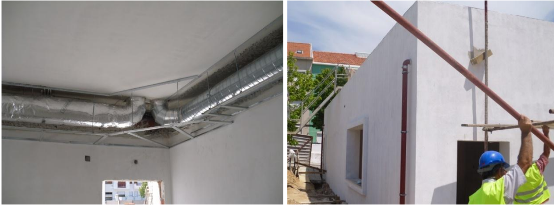
Fig 82 e 83 – Forras nas tubagens para AVAC e pintura das paredes exteriores.
