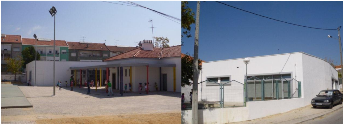
Fig 114 e 115 – Obra terminada e em fase de utilização.
