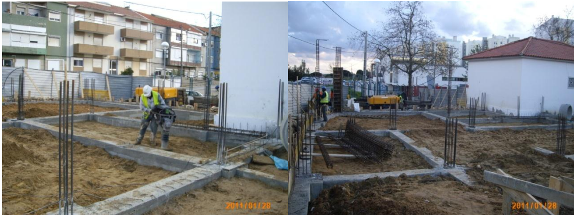
Fig 27 e 28 – Compactação do terreno e armação e cofragem de pilares.
