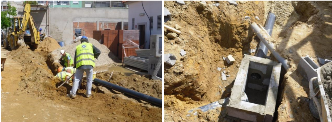
Fig 66 e 67 – Drenagem Pluvial.
