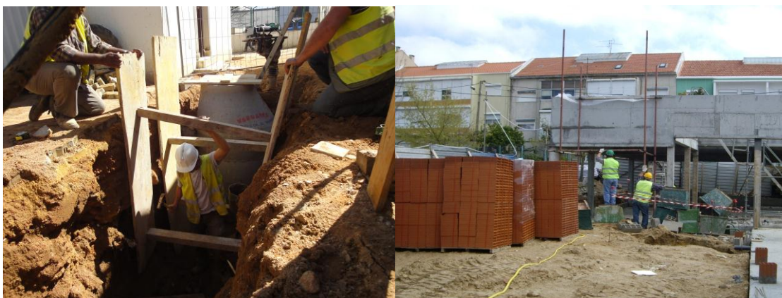
Fig 42 e 43 – Execução de entivação e construção de torre de apoio.
