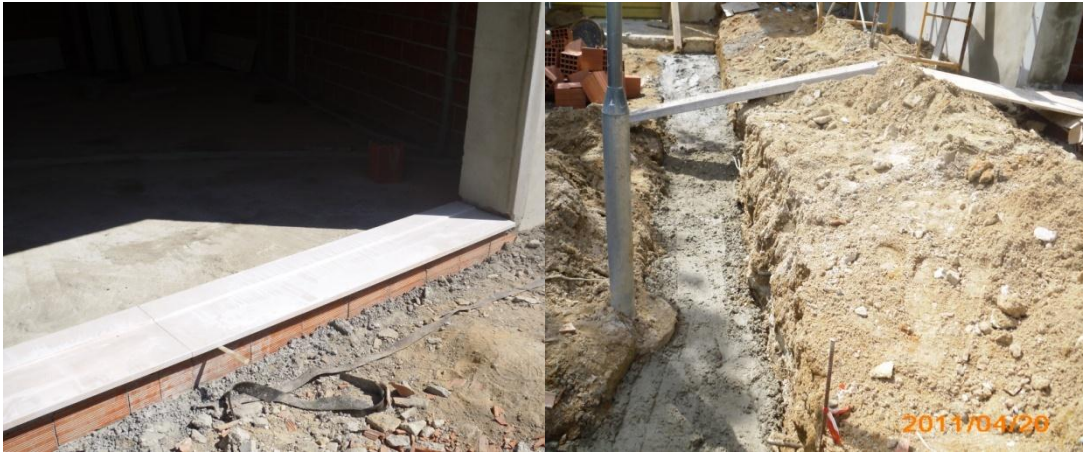
Fig 64 e 65 – Pedra de cantaria e tapamento de valas.
