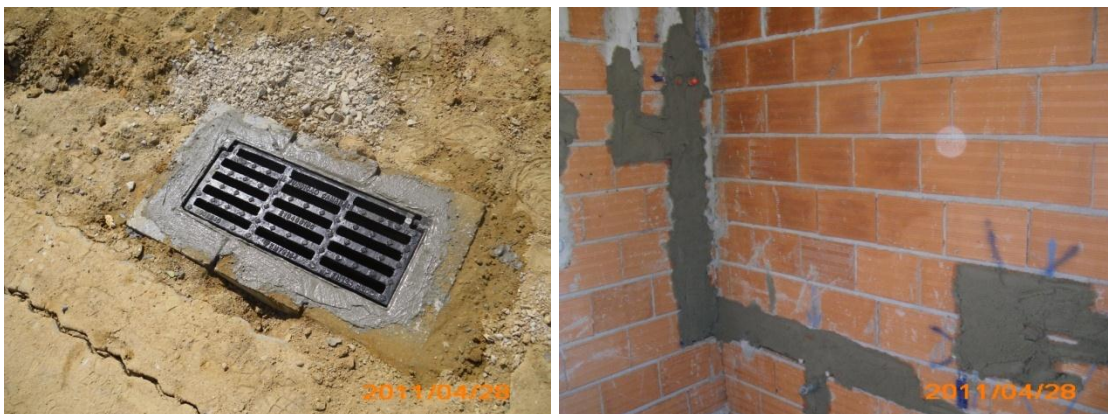
Fig 72 e 73 - Drenagem Pluvial e refechamento dos roços.
