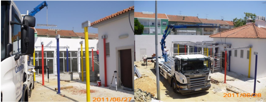
Fig 110 e 111 – Montagem de pilares e vigas metálicas.
