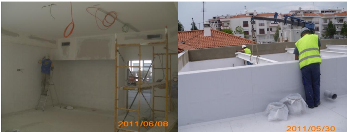
Fig 90 e 91 – Execução da sanca e montagem da estrutura metálica.
