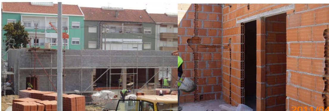
Fig 56 e 57 – Reboco exterior e abertura de roços.
