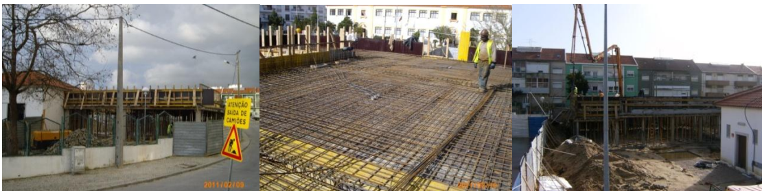
Fig 35, 36 e 37- Cofragem, armação e betonagem da laje.
