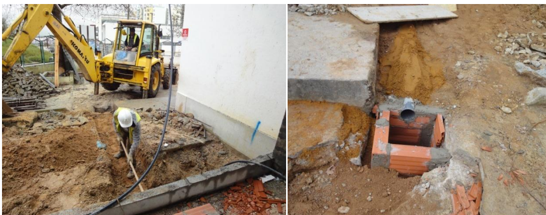
Fig 58 e 59 – Redes de águas residuais.
