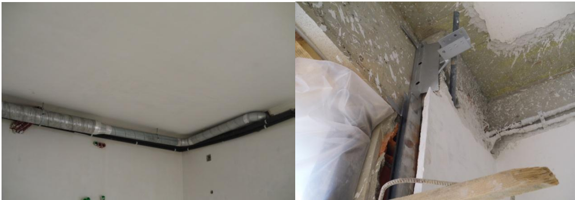
Fig 80 e 81 – Execução da rede de AVAC e instalação de estores.
