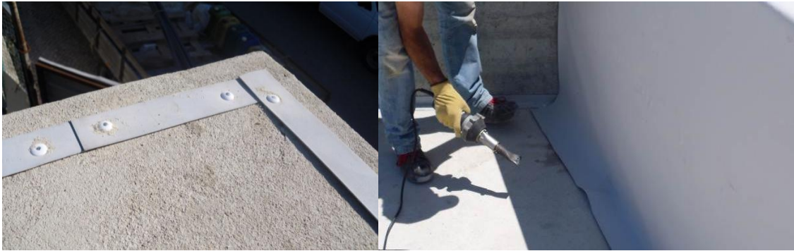
Fig 76 e 77- Trabalhos de impermeabilização na cobertura.
