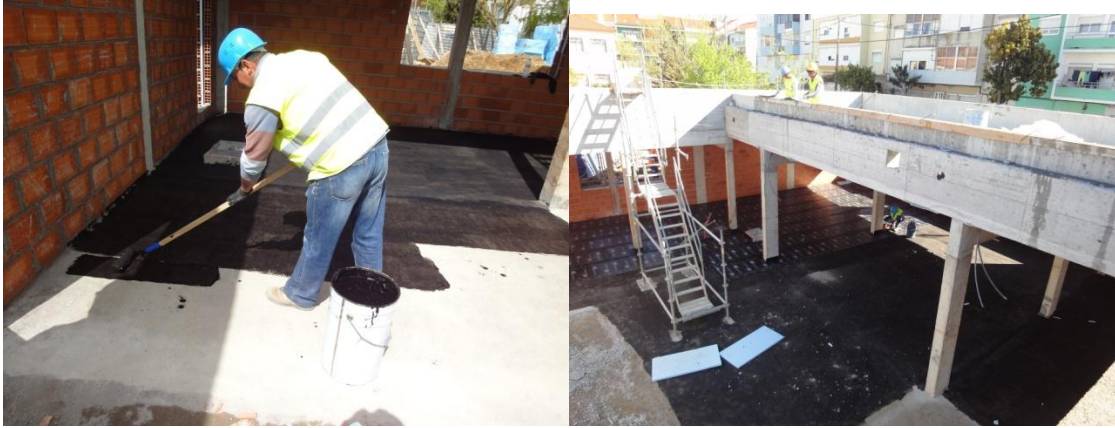
Fig 48 e 49 – Trabalhos de impermeabilização do pavimento térreo.
