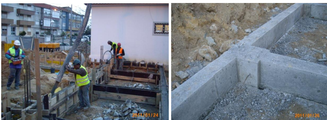
Fig 21 e 22 – Betonagem e descofragem das vigas de fundação.
