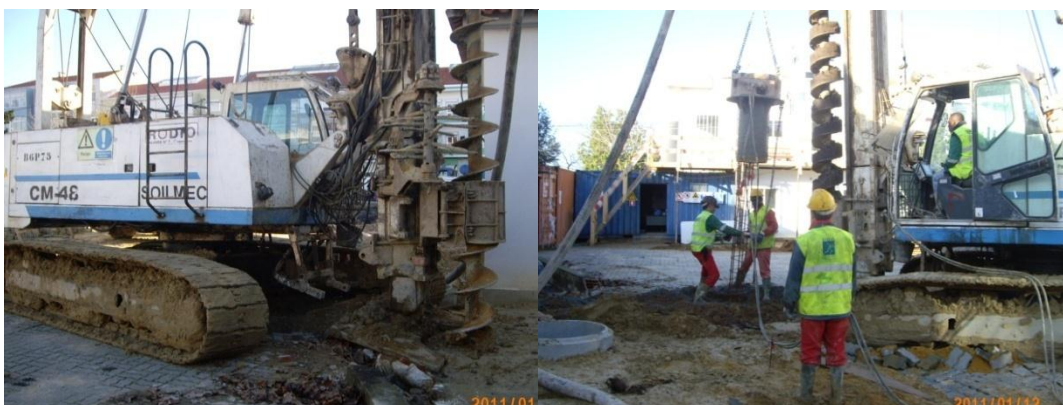
Fig. 14 e 15 – Máquina de trado contínuo e furação no terreno.
