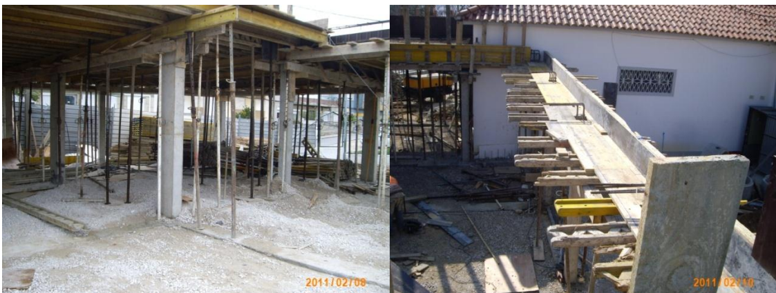
Fig 33 e 34 – Escoramento das vigas e laje.
