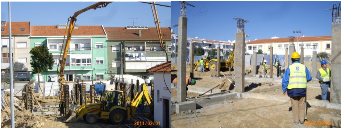
Fig 29 e 30- Betonagem dos pilares e descofragem dos mesmos.
