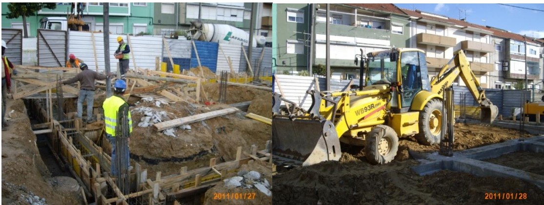
Fig 25 e 26 – Betonagem das vigas de fundação e movimentação de terras.
