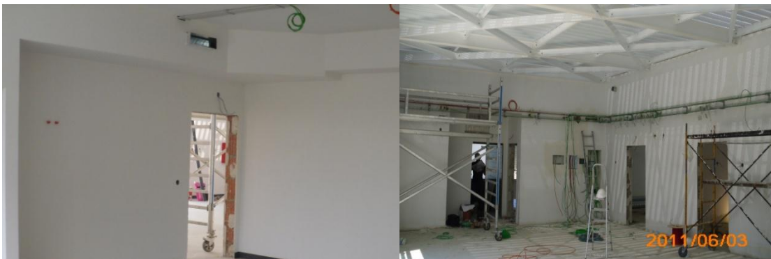
Fig 96 e 97 – Pintura das sancas e colocação de cablagem.
