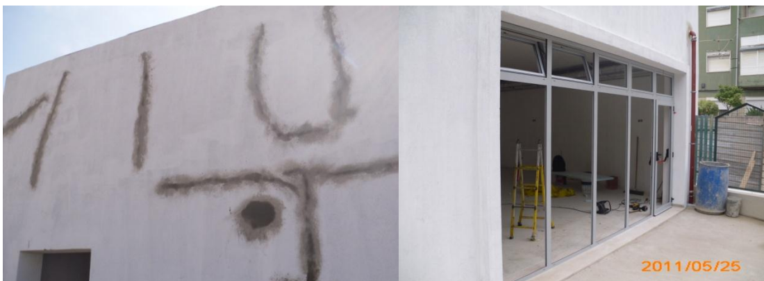
Fig 88 e 89 – Reparações nas paredes exteriores e execução de caixilharias.
