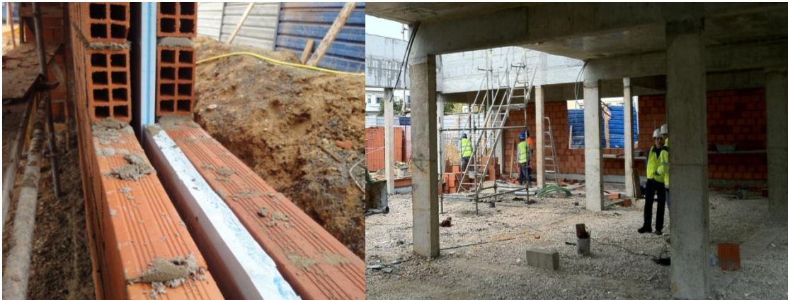
Fig 46 e 47- Alvenarias exteriores.
