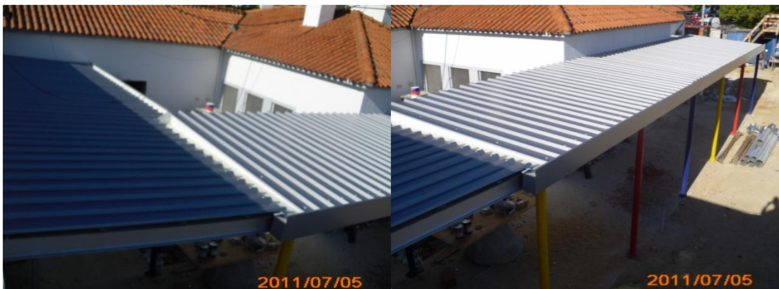
Fig 112 e 113 – Cobertura da estrutura metálica.
