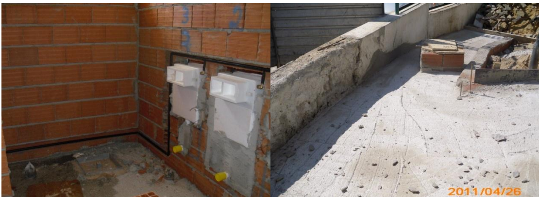
Fig 68 e 69- Tubagem nas IS e reconstrução do murete.
