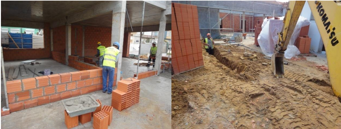
Fig 54 e 55 – Alvenarias Interiores e abertura de vala.
