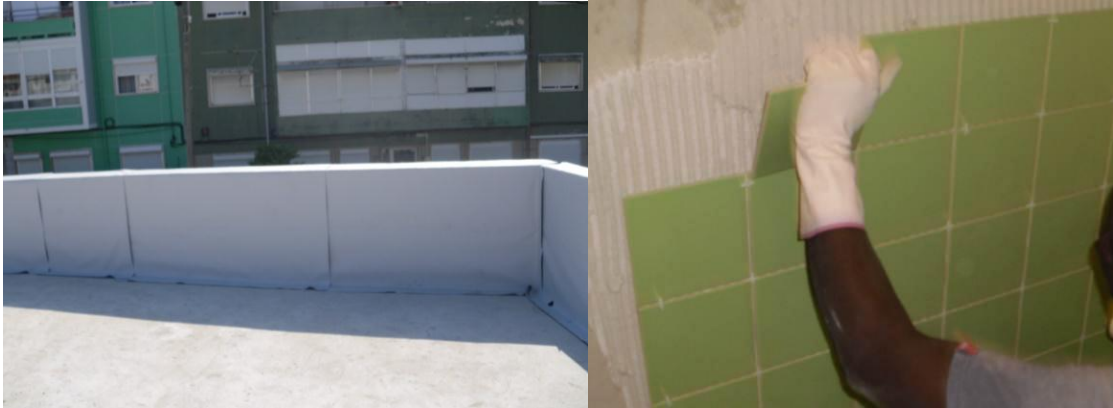
Fig 78 e 79 – Impermeabilização da cobertura e assentamento de azulejos.
