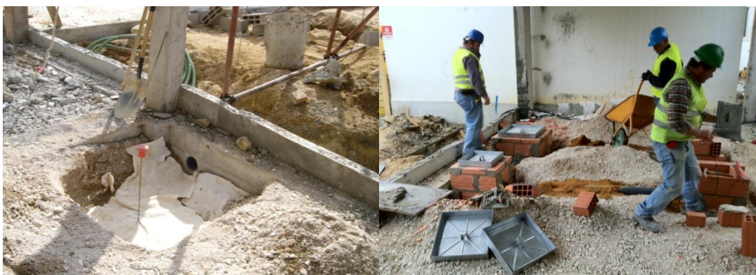
Fig 44 e 45 – Execução da rede de esgotos no interior do edifício.
