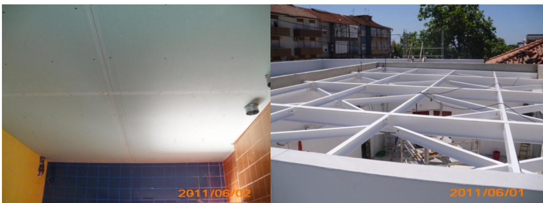
Fig 92 e 93 – Tecto falso nas IS e estrutura metálica na cobertura.
