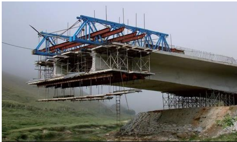
Figura 2.25- Troço de uma ponte executado com o auxílio de carrinho de avanço pelo método dos avanços sucessivos (Nakamura, 2012)
