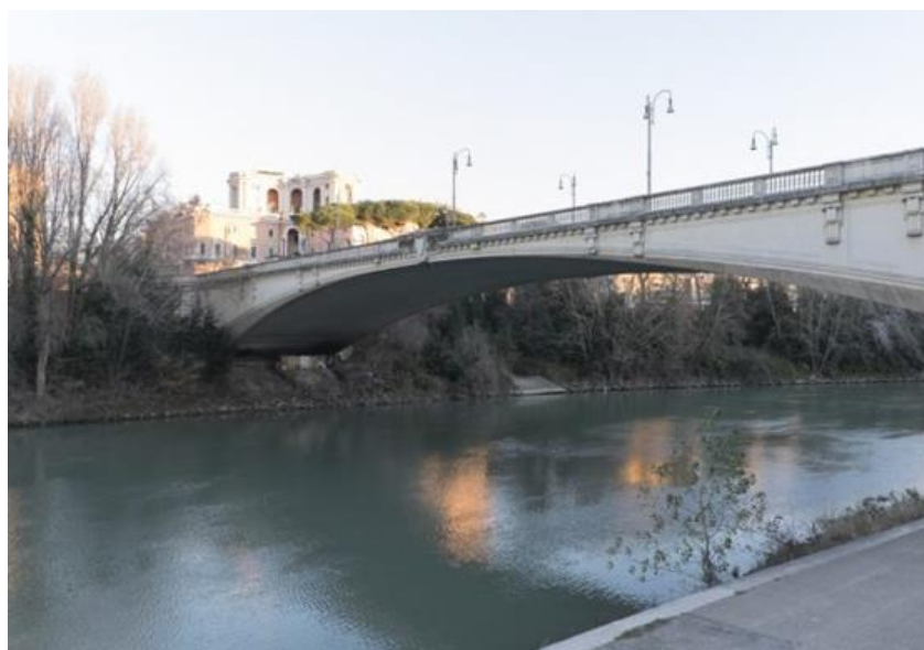
Figura 2.3- Ponte do Resorgimento, Primeira Ponte de betão armado com viga em caixão (F. Hennebique, 1911)
