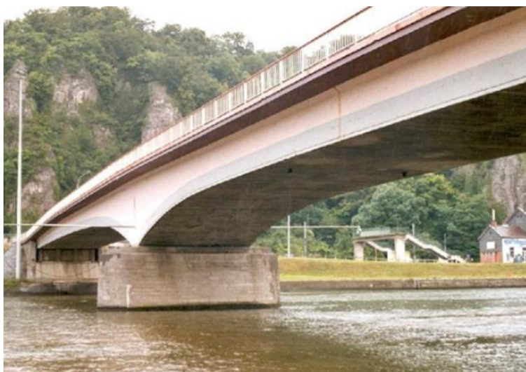
Figura 2.4- Ponte de Sclayn, Primeira Ponte de betão armado pré-esforçado, com viga em caixão (G. Magnel, 1948)
