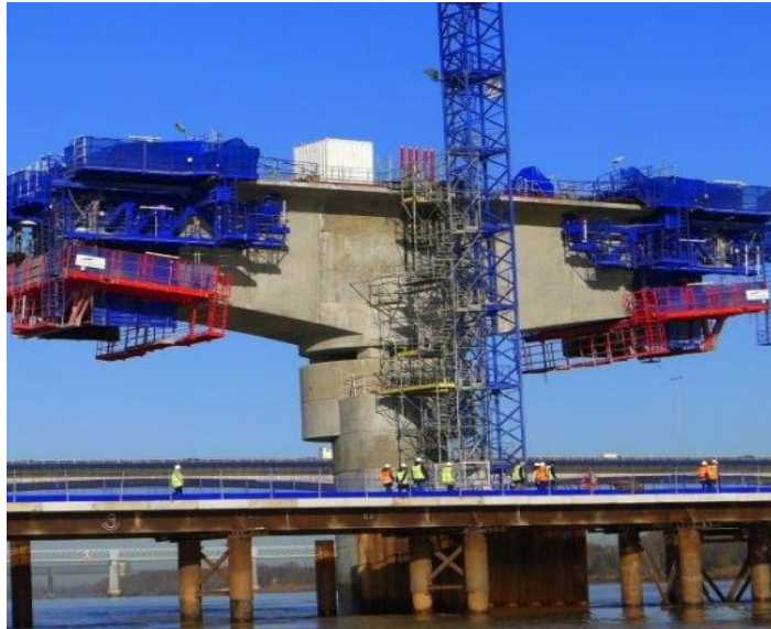
Figura 2.26- Construção simétrica usando o método dos avanços sucessivos (C&Q, 2017)
