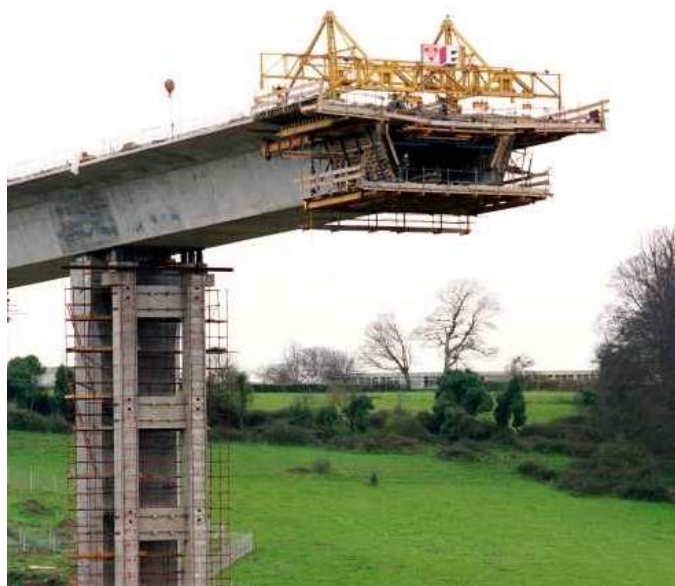
Figura 1.1 Construção de um troço do tabuleiro com viga-caixão, pelo método dos avanços sucessivos (Council, n.d.)
