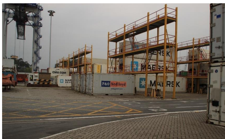
Figura 2.6 – Estruturas metálicas de acesso para alimentação elétrica aos contentores frigoríficos "Reefers".
