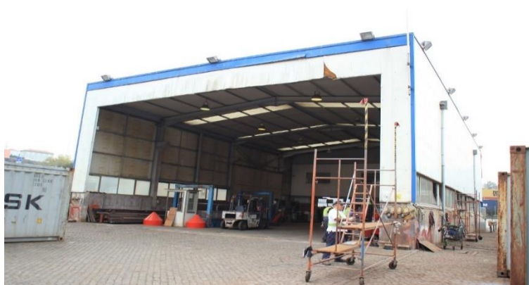
Figura 2.8 – Oficina existente de Manutenção de Equipamentos e contentores a desmontar.
