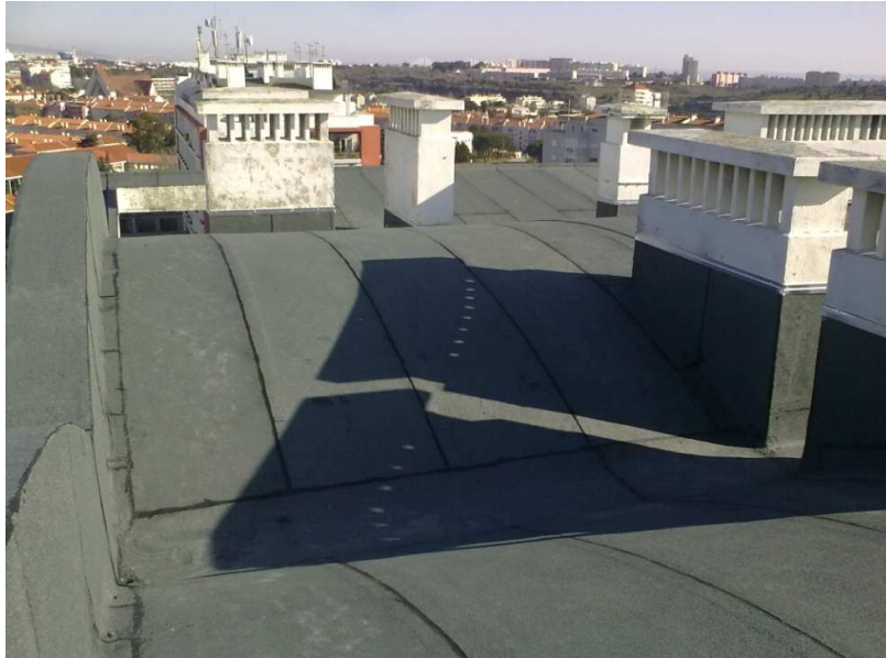
Figura 5.1.2 - Cobertura "acima indicada" após reabilitação.
