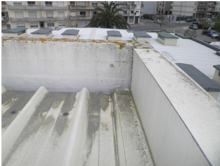
Figura 8 - Muretes de platibanda na envolvente da cobertura
