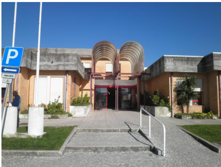
Figura 1 - Entrada Principal (Oeste)
