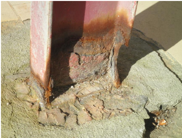
Figura 10 - Estrutura metálica da pala de sombreamento
