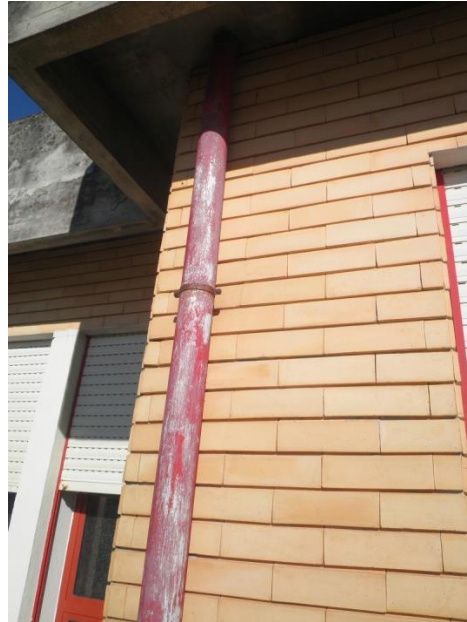
Figura 11 - Tubos de queda e revestimento cerâmico
