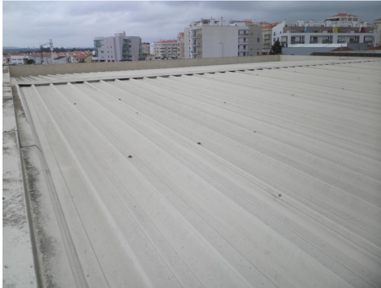
Figura 7 - Cobertura chapas metálicas
