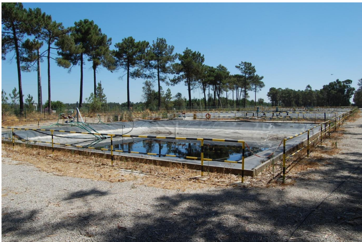
Figura 3.12 - Lagoa de decantação.
