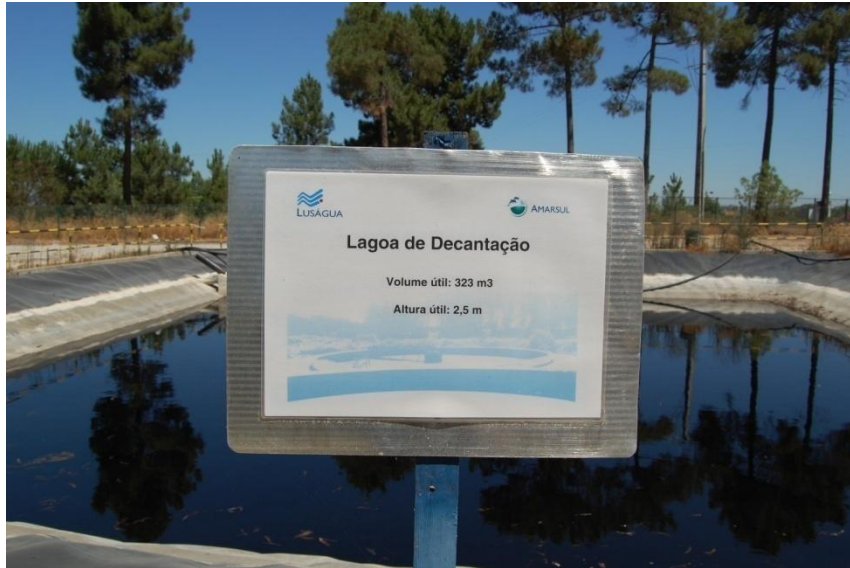
Figura 3.11 - Placa de identificação da lagoa de decantação.
