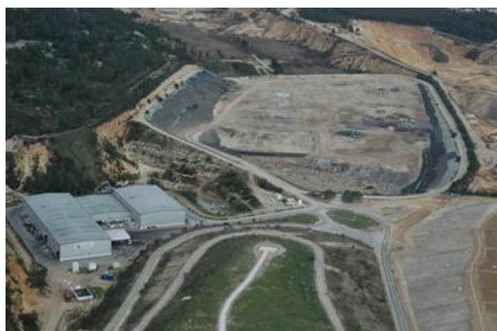
Figura 3.1 - Aterro sanitário de Palmela (18).
