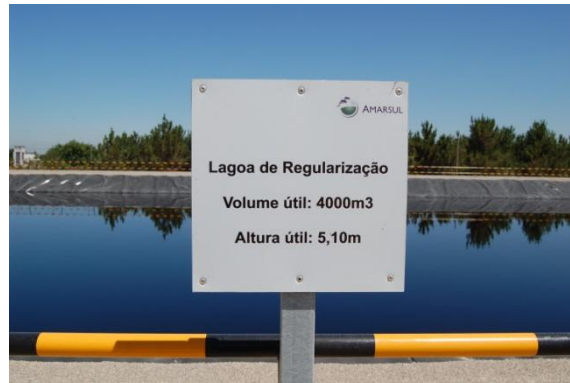
Figura 3.4 - Placa de sinalização da lagoa de regularização.
