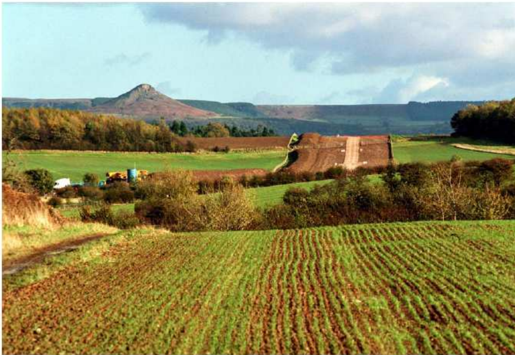
Fig. 17 - Escavações para a passagem de cabos de 400kV Nunthorpe-Newby no Reino Unido [1].
