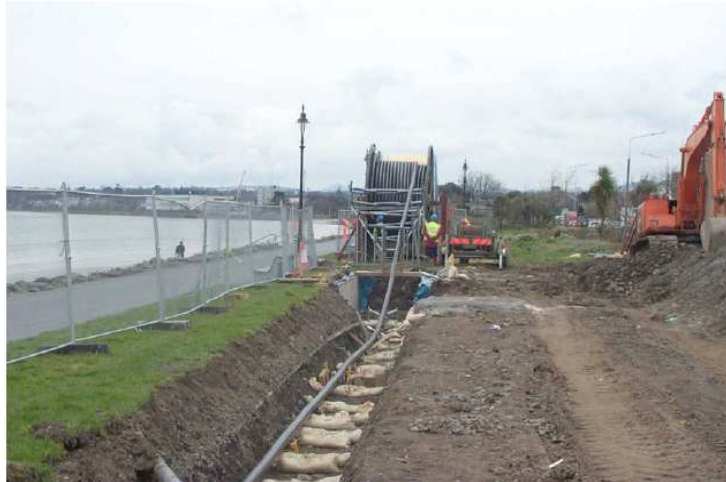
Fig. 14 - Passagem de um cabo de MAT em terreno aberto [1].
