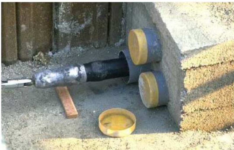
Fig. 13 - Puxe de um cabo de MAT dentro de um tubo de PVC [1].
