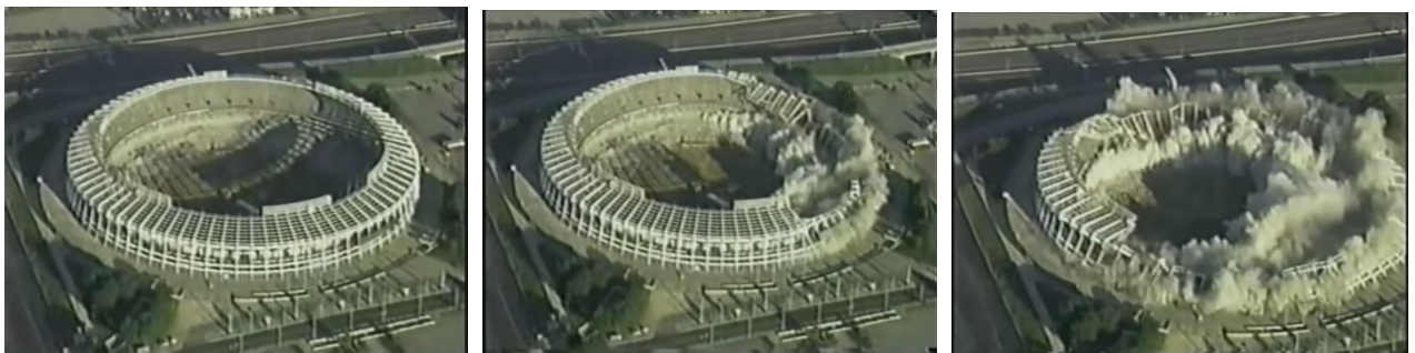
Figura 5 – N.a. Building Demolition Compilation . Imagens retiradas do vídeo online:
