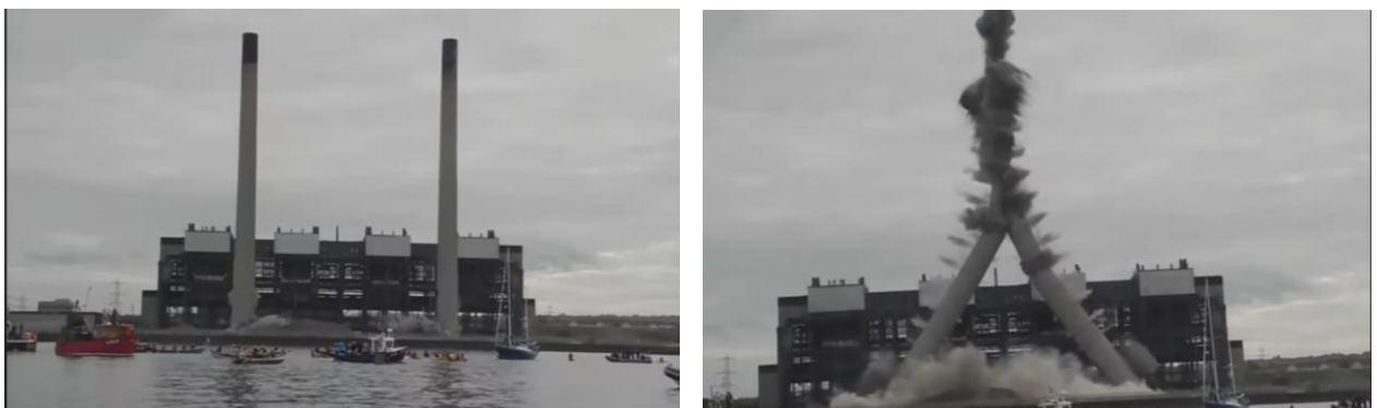
Figura 6 - N.a. Building Demolition Compilation . Imagens retiradas do vídeo online:
