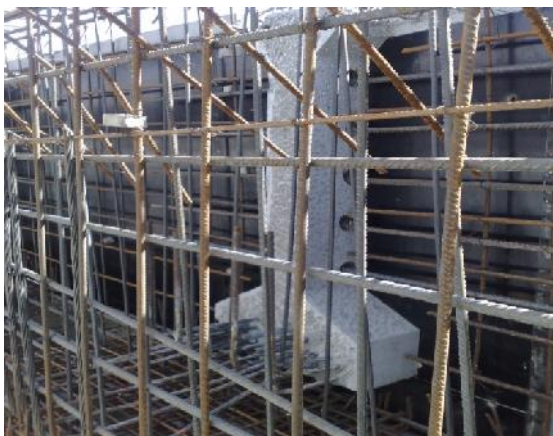
Vigas e pré-lajes, pré-fabricadas
