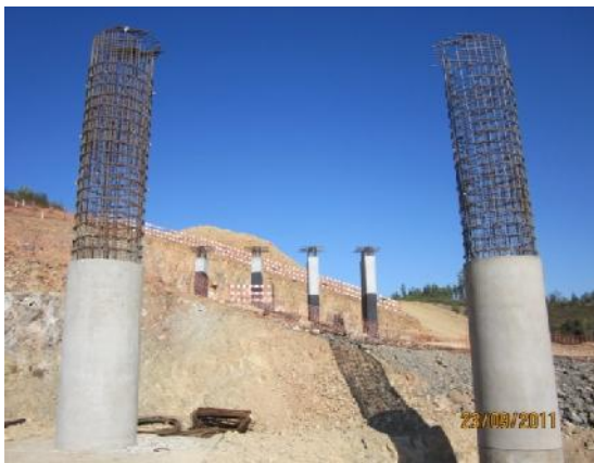
Cofragem para os pilares. A betonagem destes elementos foi faseada, estando cada fase limitada pelo comprimento/altura da cofragem (cerca de 3 m)
