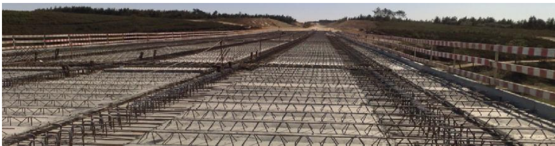
Viga carlinga: à esquerda armadura e à direita já betonada.
