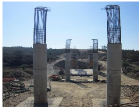
Cofragem para os pilares. A betonagem destes elementos foi faseada, estando cada fase limitada pelo comprimento/altura da cofragem (cerca de 3 m)
