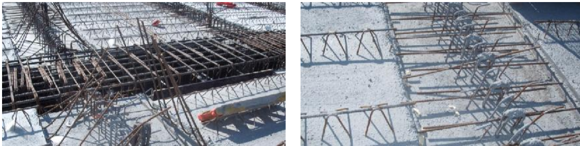
Viga carlinga: à esquerda armadura e à direita já betonada.
