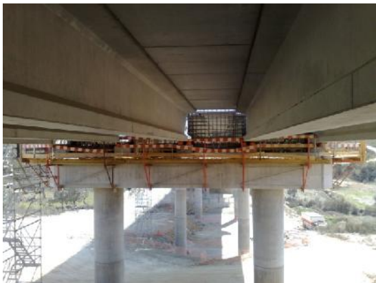
Vigas e pré-lajes, pré-fabricadas
