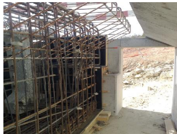
Vigas e pré-lajes, pré-fabricadas
