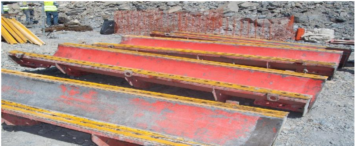
Cofragem para os pilares. A betonagem destes elementos foi faseada, estando cada fase limitada pelo comprimento/altura da cofragem (cerca de 3 m)
