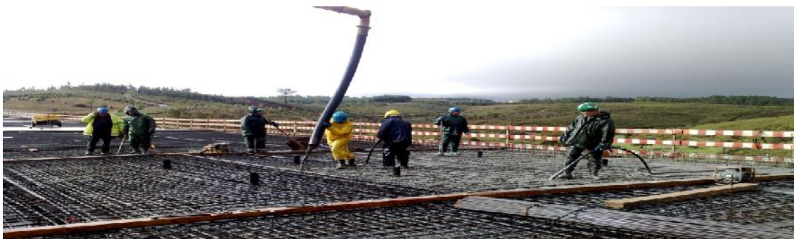
Betonagem do tabuleiro
