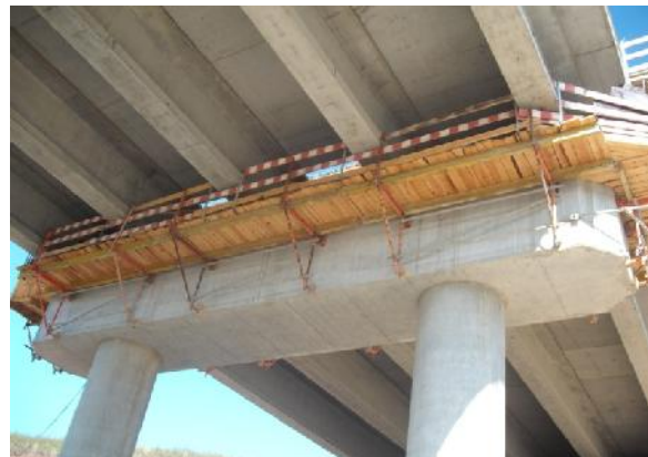
Vigas e pré-lajes, pré-fabricadas
