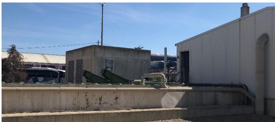
Figura 3.14 – Ventilação do Canal de Parshall.
