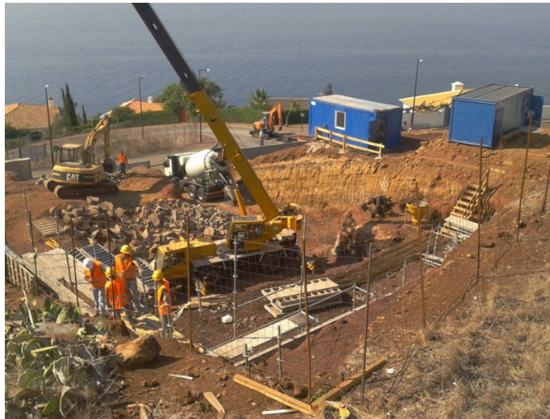
Figura 3.19 - Utilização de grua móvel em obra
