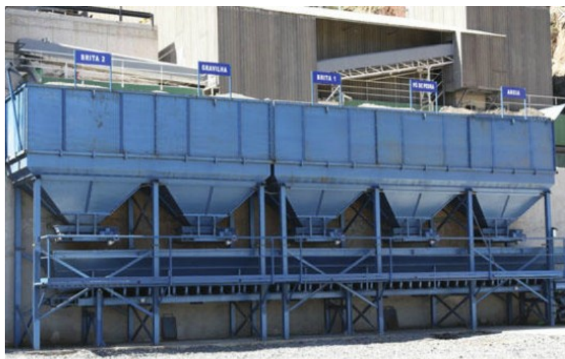
Figura 1.2 - Depósito de inertes de auxílio à central de betão
