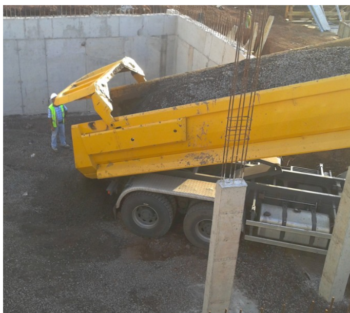
Figura 3.34– Fornecimento de Tout venant à obra
