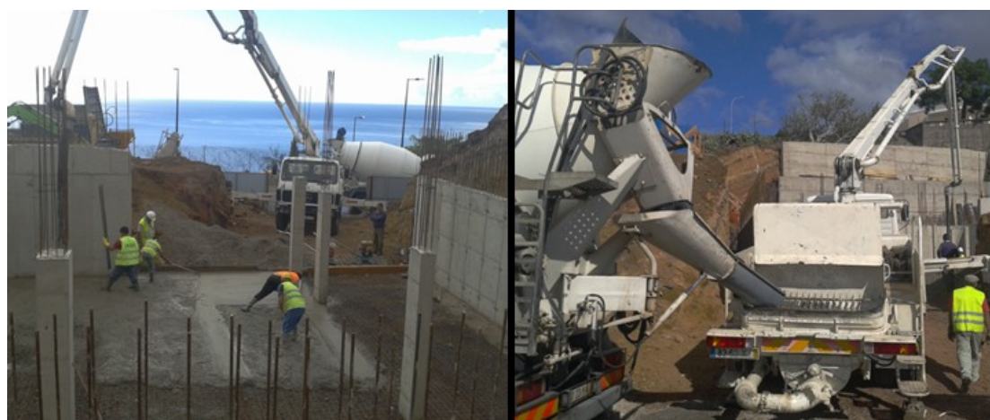
Figura 3.36 - Betonagem com recurso a auto bomba (vista de dois ângulos)
