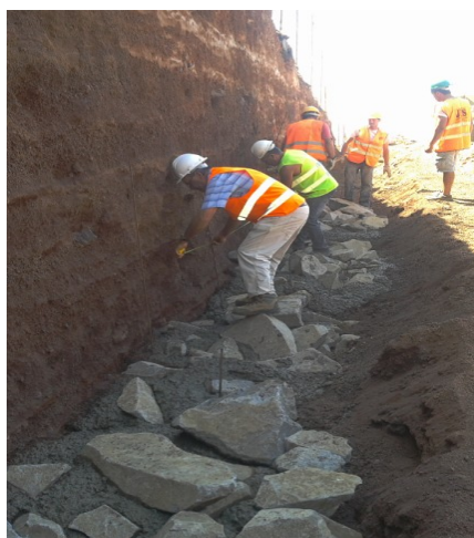
Figura 3.26 - Execução da base do muro de contenção em betão ciclópico
