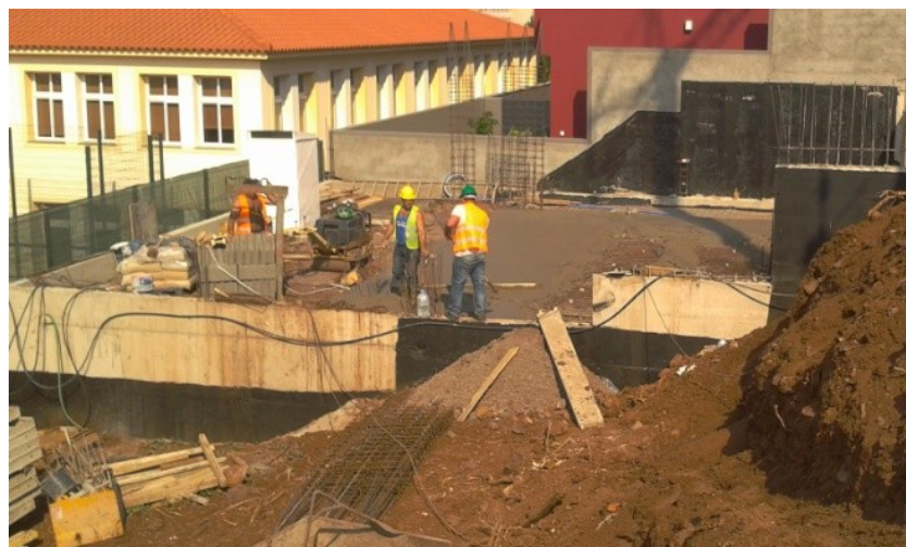
Figura 3.50 - Muro de contenção no alçado Este
