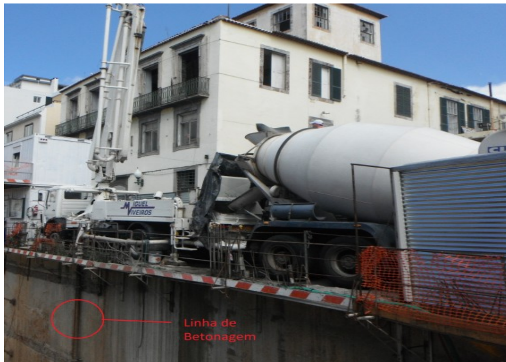
Figura 2.18 - Início da linha de betonagem
