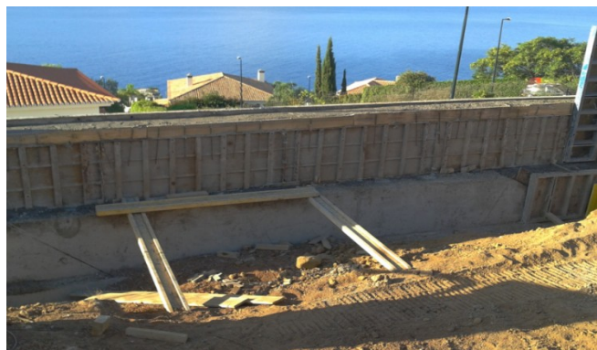
Figura 3.23 - Muro de betão ciclópico em degraus utilizado no alçado a sul
