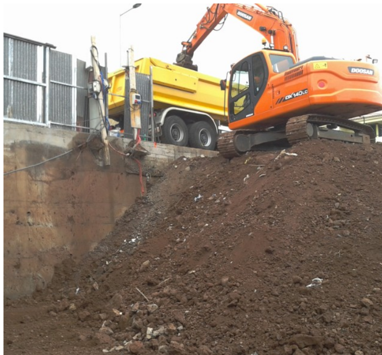
Figura 3.46 - Escavação com recurso a uma escavadora hidráulica
