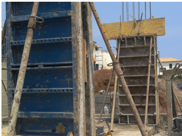
Figura 3.53 – Cofragem dos pilares
