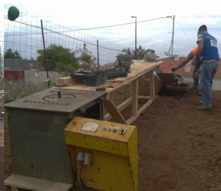
Figura3.21 - Local de armazenagem dos varões de aço
