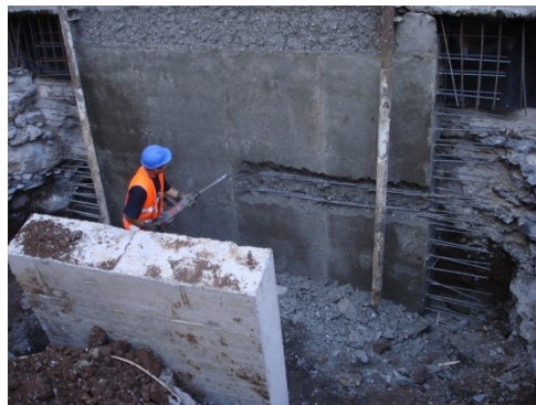
Figura 2.27 - Abertura das paredes de contenção para destaque das armaduras
