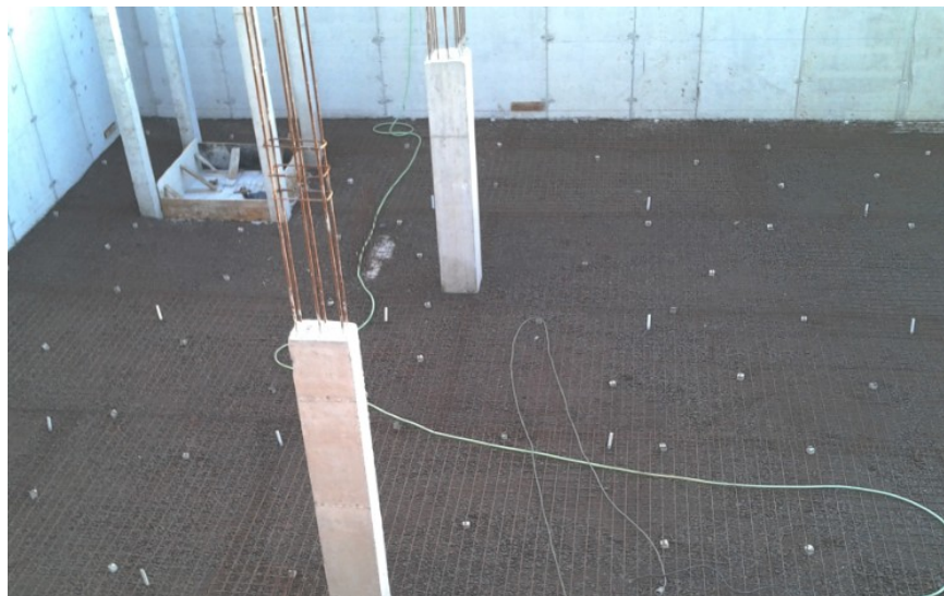
Figura 3.35 - Preparação do pavimento do piso térreo - malhasol com espaçadores
