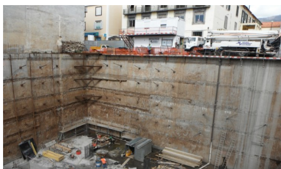
Figura 2.20 - Área reduzida de estaleiro
