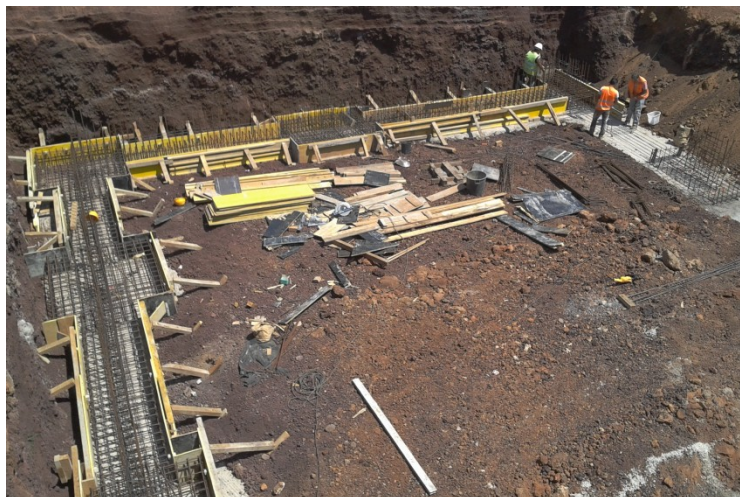
Figura 3.31 - Execução das fundações - cofragem e colocação das armaduras
