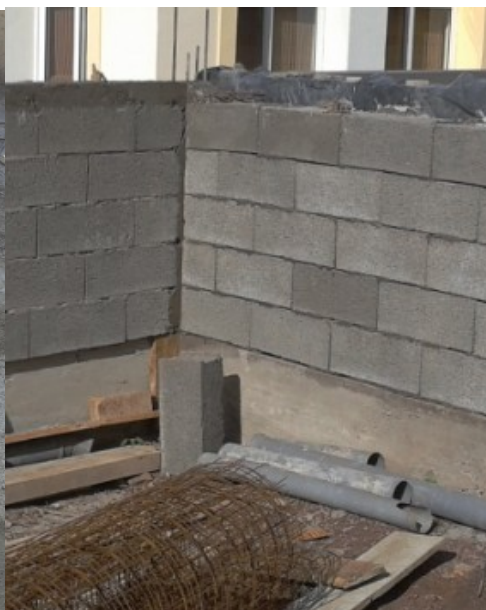
Figura 3.55 – Alvenaria em muros exteriores
