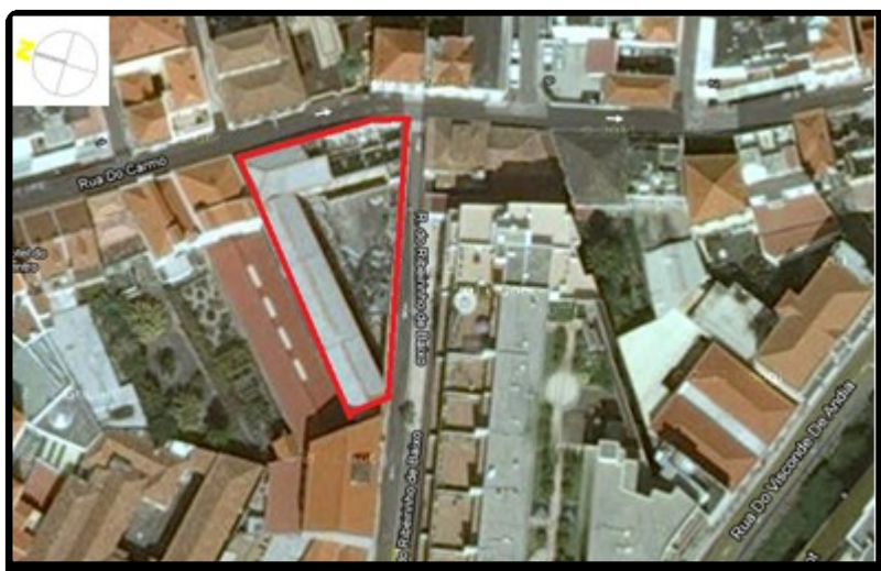
Figura 2.2 - Fotografia aérea da localização da obra
