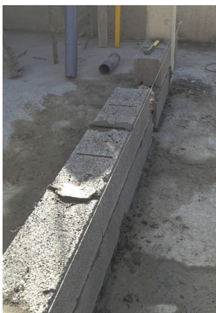
Figura 3.54 – Alvenaria em parede interior
