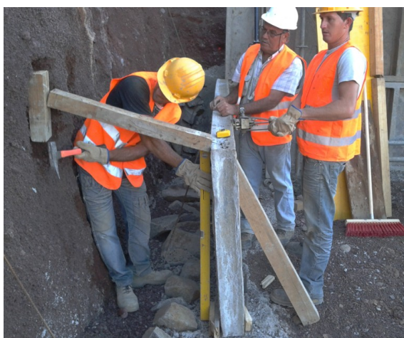
Figura 3.27 - Execução do muro de betão ciclópico (verificação do ângulo de inclinação)
