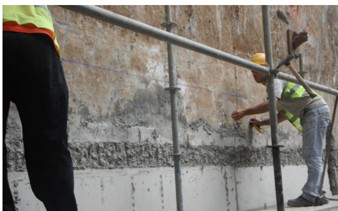
Figura 2.29 - Marcação da zona onde ocorrerá a ligação laje-parede de contenção
