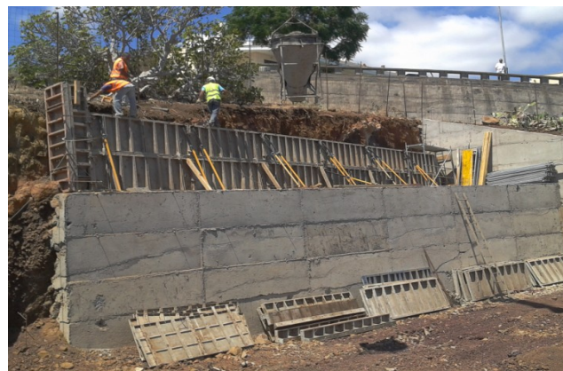
Figura 3.24 - Muro de betão ciclópico com face inclinada
