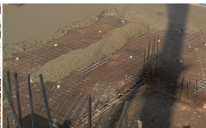
Figura 3.52 - Betonagem do piso térreo
