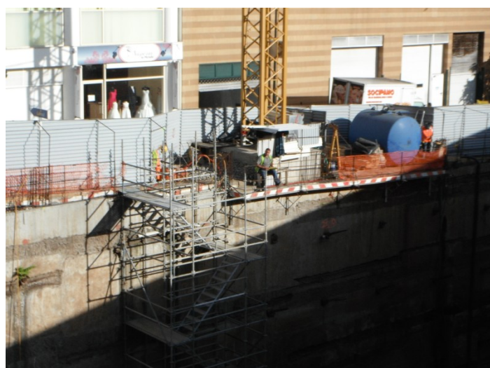
Figura 2.21 - Zona de implantação da grua
