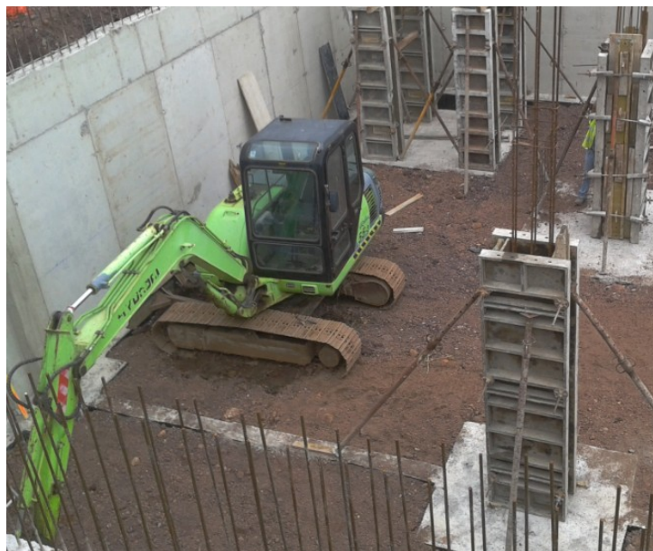
Figura 3.33 - Mini escavadora hidráulica giratória (Hyundai 55-7)
