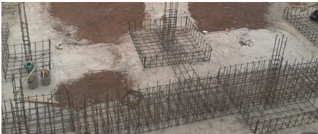
Figura 3.47 - Colocação das armaduras sobre camada de regularização
