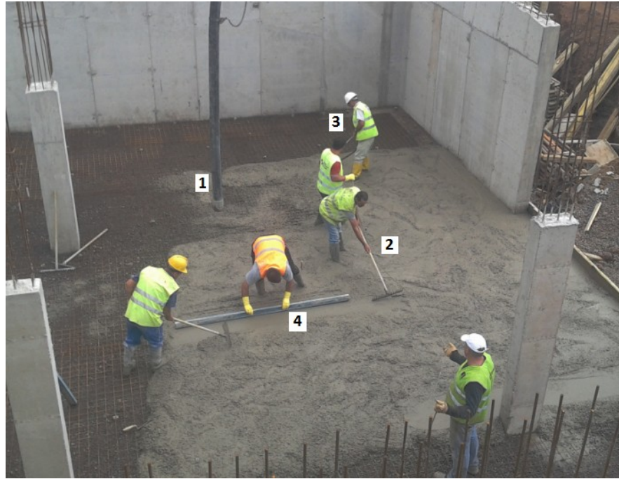
Figura 3.37 - Processos na betonagem da laje do piso térreo
