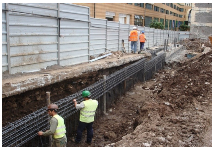
Figura 2.22 – Execução da viga de coroamento
