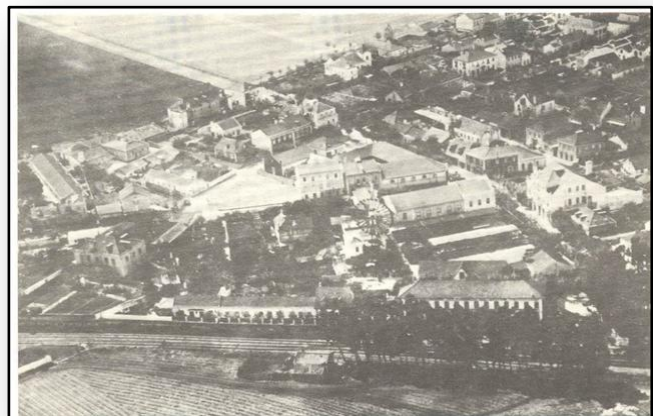
Figura 2-4 - Vista aérea da AMADORA [50]
