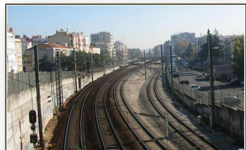
Figura 2-10 - Estação [Norte] da Amadora, vista atual [57]
