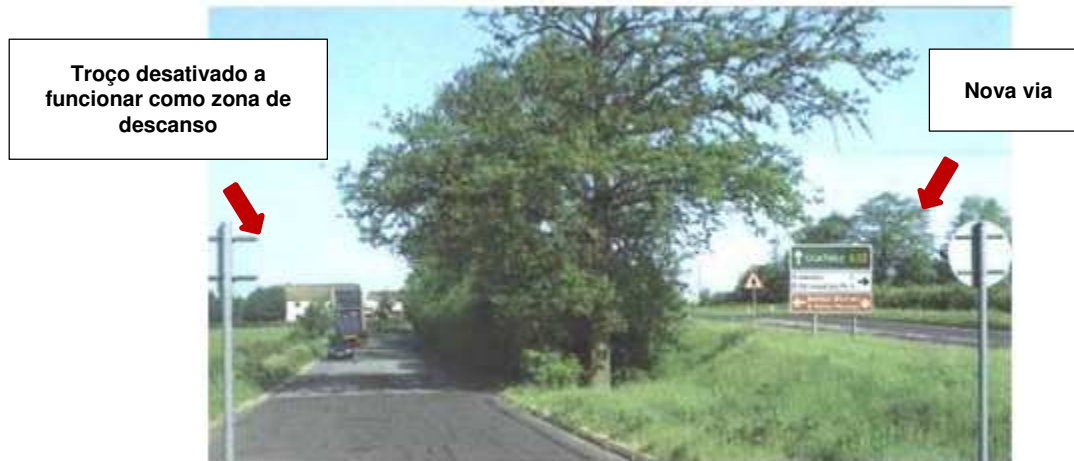
Figura 4.12 – Troço desativado a funcionar como zona de descanso, Reino Unido (Highway Agency, 1997)
