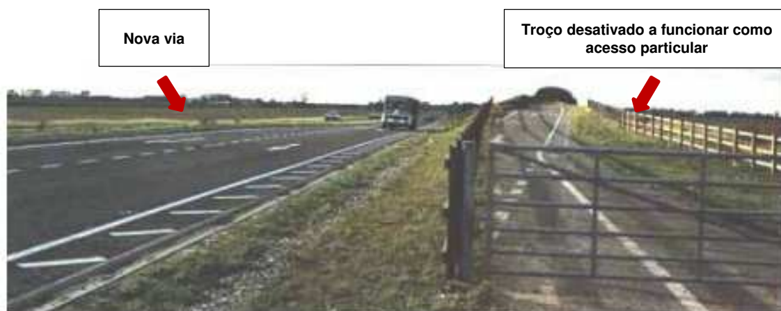
Figura 4.11 – Troço desativado a funcionar como acesso particular, Reino Unido (Highway Agency, 1997)
