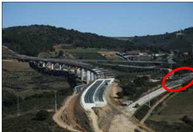
Figura 5.4 – Utilização das zonas do IP4 desativadas como depósito de terras (CAET XXI, Mar2012 (n.º 757))
