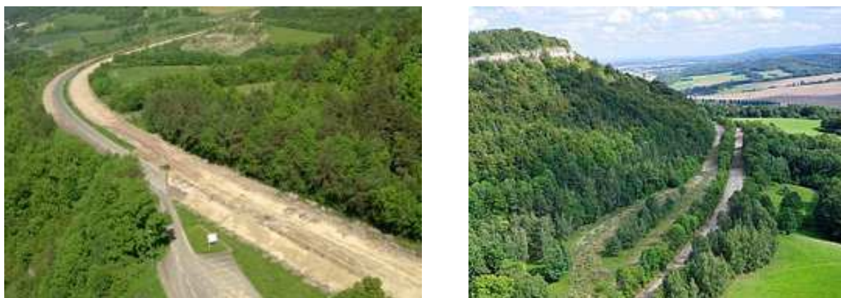
Figura 4.5 – Renaturalização da antiga ligação a Eisenach, A4, Alemanha
