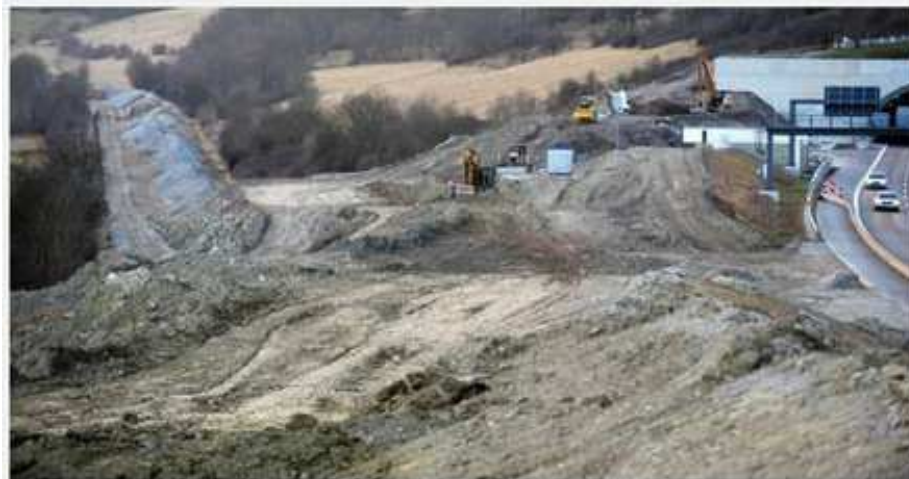
Figura 4.7 – Desmantelamento da antiga A4, Jena, Alemanha (Zipel, 2015) [97]
