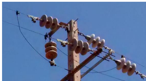
Figura 7 - Cadeias de amarração ascendente e descendente
