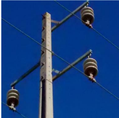
Figura 6- Cadeia de isoladores em suspensão
