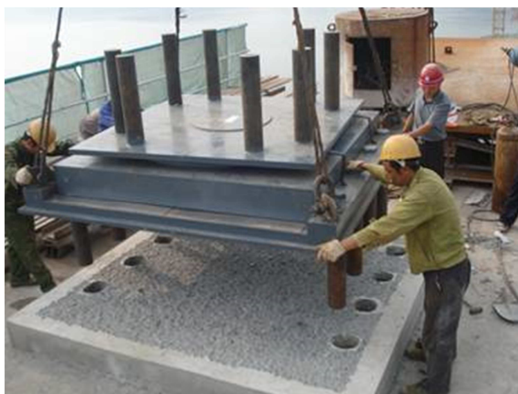
Figura 43. Transporte de um AA para o local de instalação
