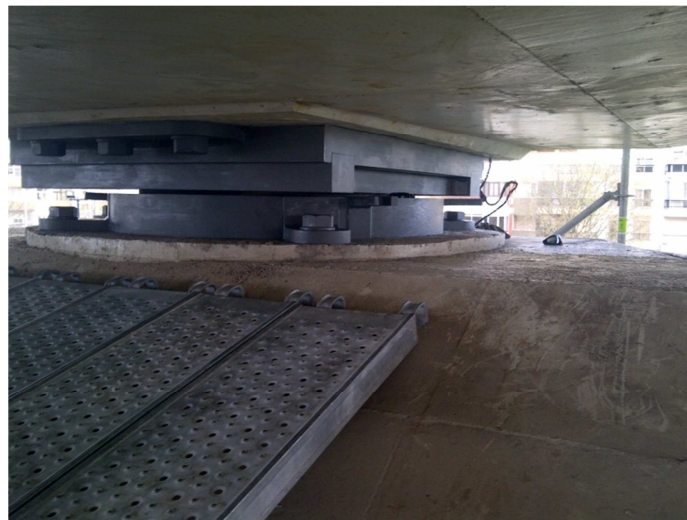
Figura 73. Aparelho de apoio depois da aplicação do primário de protecção
