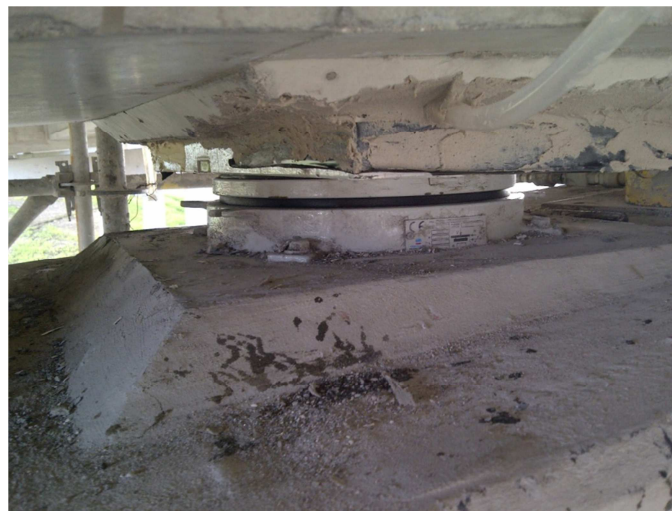
Figura 80. Injeção do plinto superior do AA
