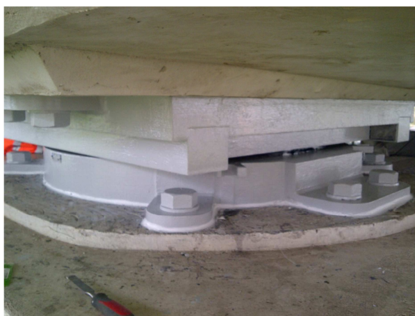
Figura 75. Aspecto final do Aparelho de apoio após manutenção
