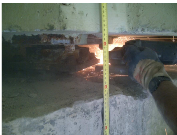
Figura 89. Remoção de AA com recurso a rebarbadora
