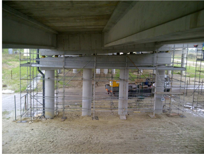
Figura 77. Montagem de andaimes num dos alinhamentos
