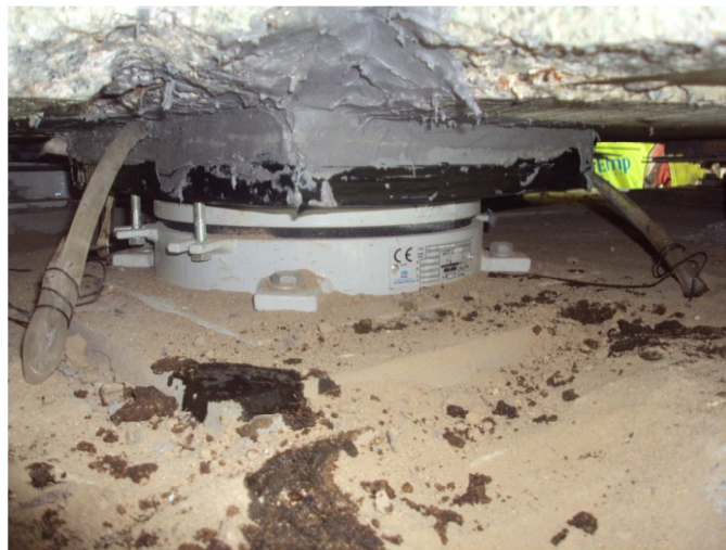
Figura 91. Injeção do plinto superior do AA
