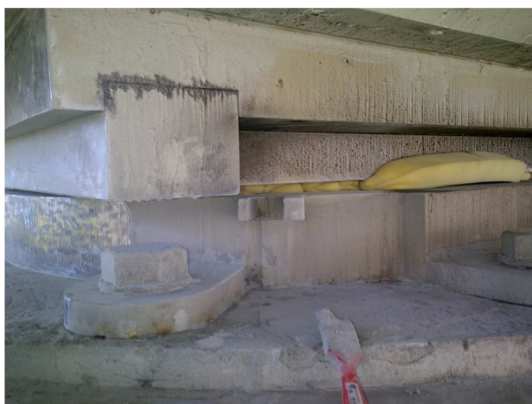
Figura 71. Colocação de esponja para impedir a entrada de detritos
