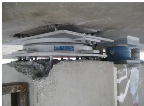
Figura 63. Substituição de aparelho de apoio
