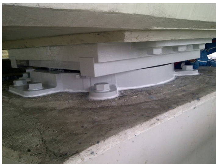
Figura 62. Aparelho de Apoio Eixo Norte-Sul após aplicação de protecção anti-corrosiva
