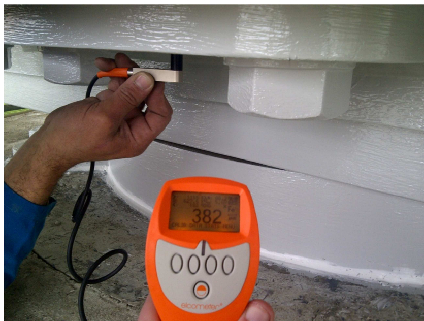
Figura 68. Medição da camada de protecção anti-corrosiva
