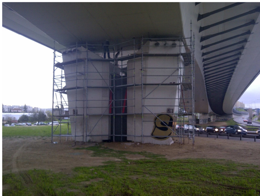
Figura 70. Fase de montagem de andaimes
