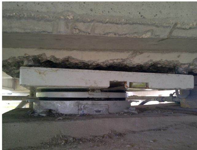
Figura 78. AA após colocação da chapa superior
