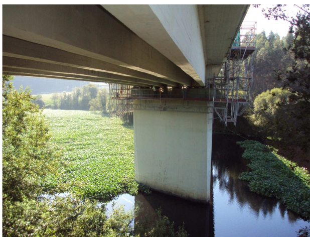
Figura 88. Realização de trabalhos no pilar submerso
