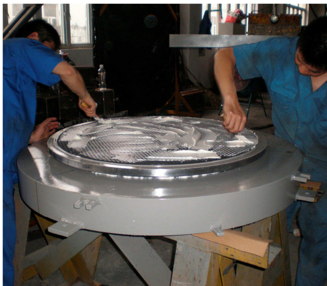
Figura 61. Lubrificação do Aparelho de Apoio
