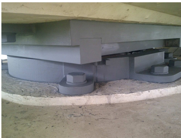
Figura 74. AA com aplicação da camada de protecção intermédia
