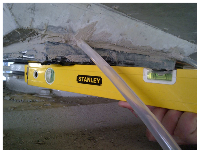
Figura 81. Verificação do nivelamento nos AA após injeção
