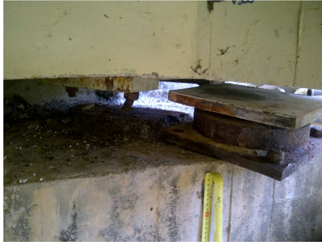
Figura 90. Remoção de Aparelho de Apoio existente
