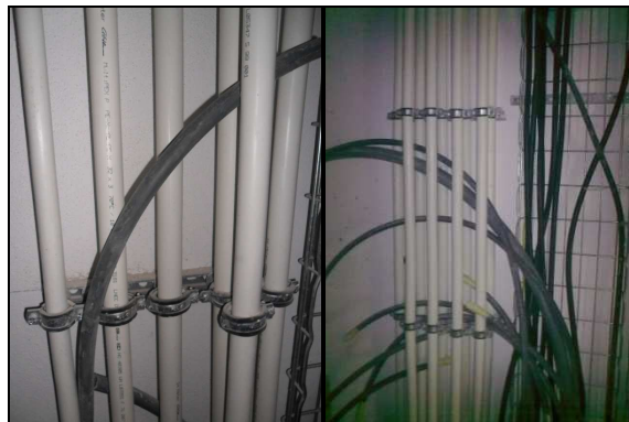
Figura 3. 7 - Fixação das colunas ao suporte
