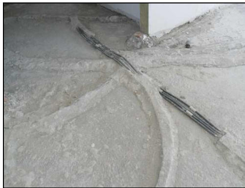
Figura 3. 43 - Tubo “ERFE” no pavimento
