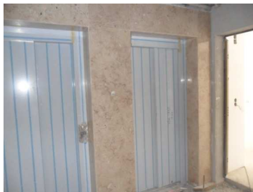
Figura 4. 17 - Pedra Lioz nos halls dos elevadores
