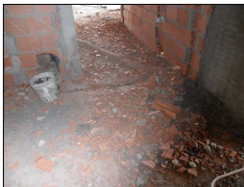
Figura 3. 59 – Abertura de roços
