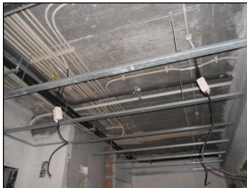
Figura 3. 46 - Instalação embebida no tecto falso
