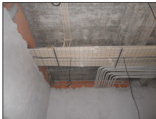
Figura 3. 44 - Desenvolvimento da tubagem no tecto
