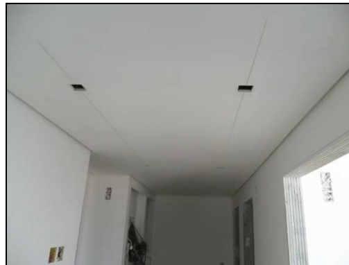
Figura 3. 65 - Marcação da localização das luminárias no tecto falso
