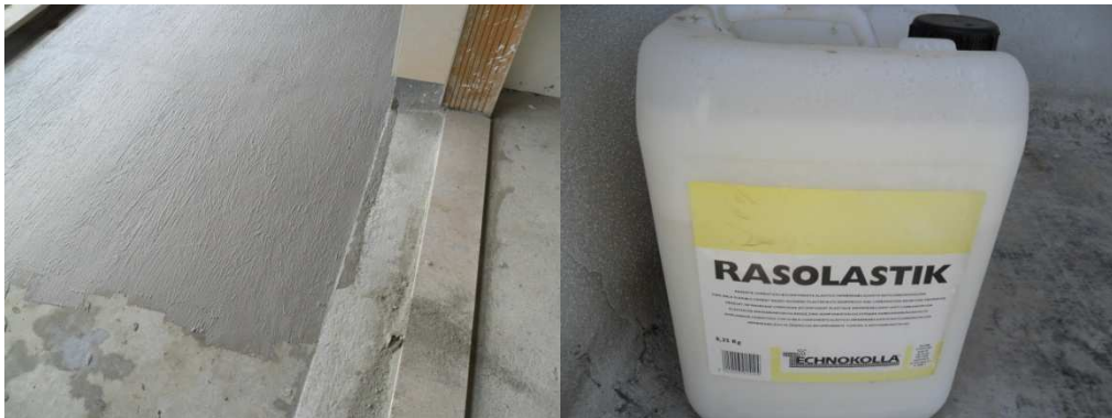
Figura 4. 31 - Impermeabilização das varandas
