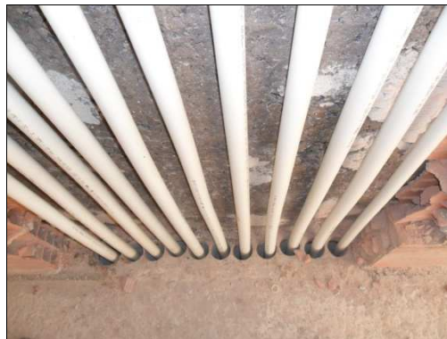
Figura 3. 9 – Carotagem do pavimento
