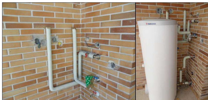
Figura 3. 12 - Reservatório de acumulação de água
