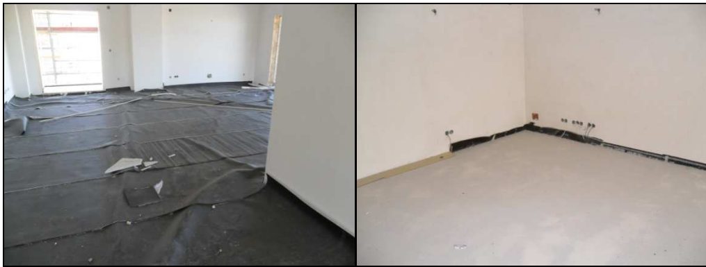
Figura 4. 23 - Betonilha sobre isolamento acústico
