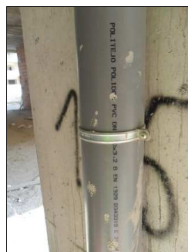
Figura 3. 19 - Fixação da tubagem
