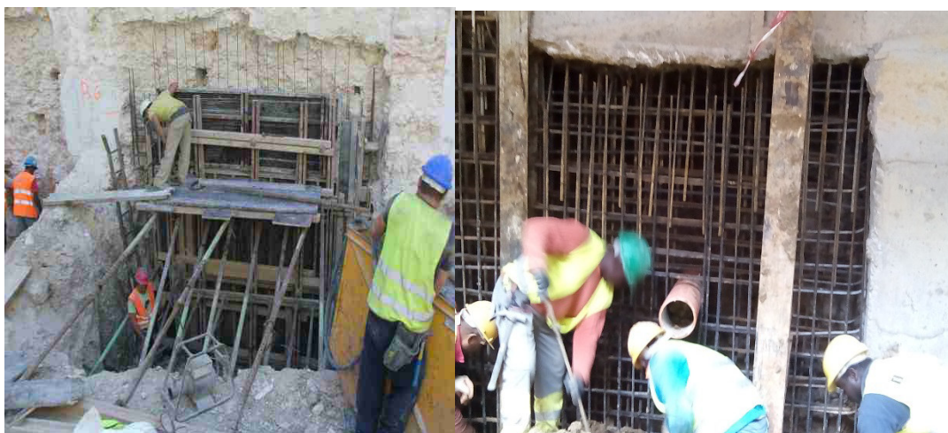
Figura 3.29 – Painel principal para betonar.
