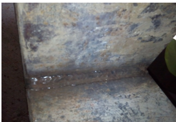
Figura 4.6 - Limpeza da base.
