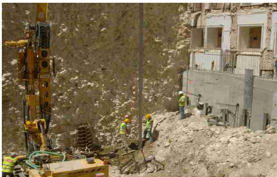
Figura 3.24 – Colocação dos perfis metálicos.
