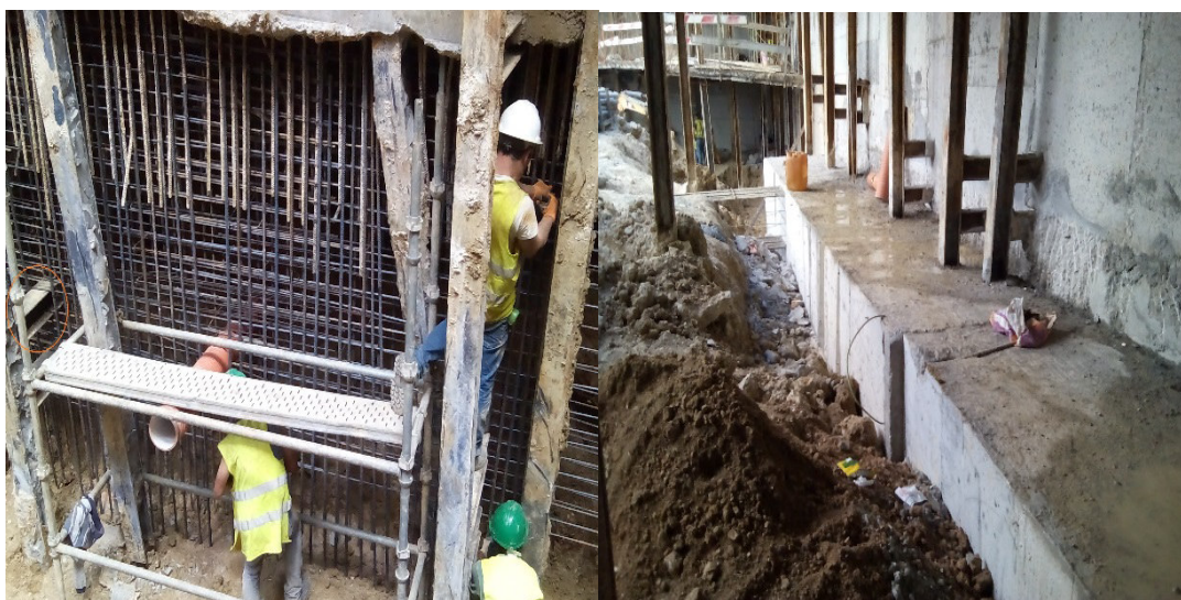
Figura 3.31 – Ligação perfis – painéis antes e após a betonagem.
