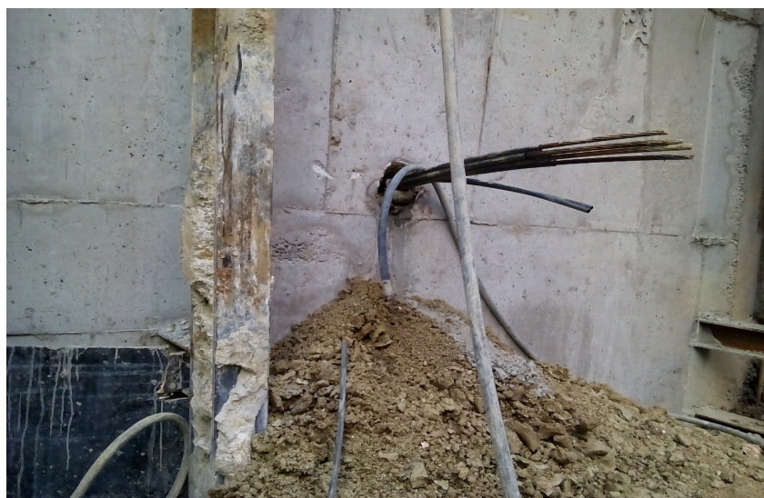
Figura 3.39 – Fim de reinjeção com derrame de calda de cimento.
