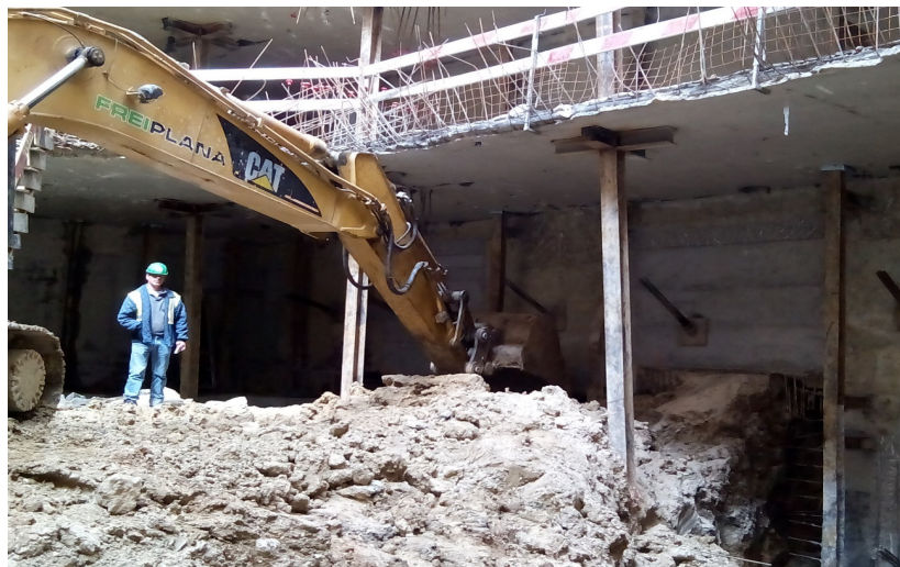
Figura 3.45 – Cruzeta soldada a perfil metálico para sustentação de laje.
