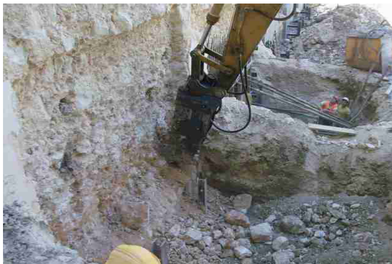
Figura 3.28 – Escavação de painéis primários e banquetas (painéis secundários).
