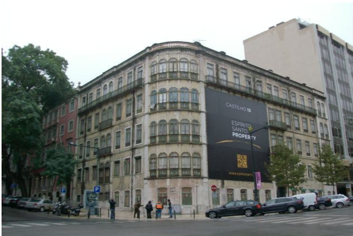
Figura 2.49 – Fachada Castilho 15 (Cruzamento rua Castilho com rua Rosa Araújo).
