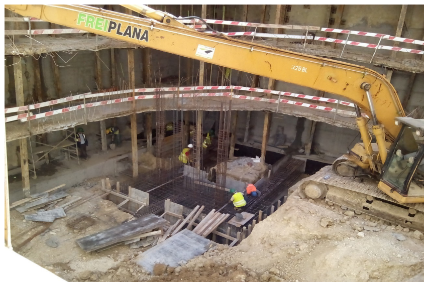
Figura 3.47 – Sapata Isolada S1 e arranque de pilar P2
