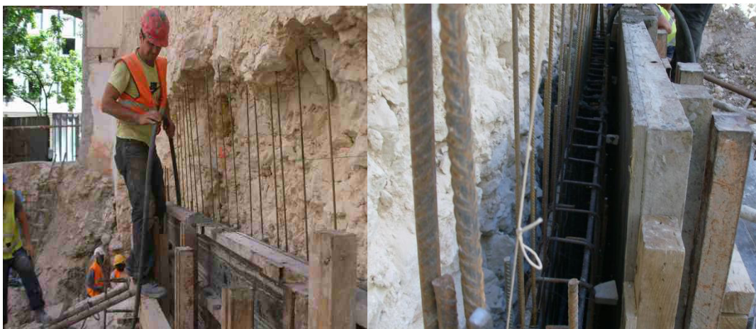
Figura 3.26 – Execução da viga de coroamento.
