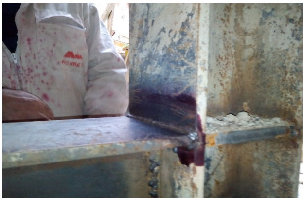
Figura 4.7 – Aplicação do penetrante.
