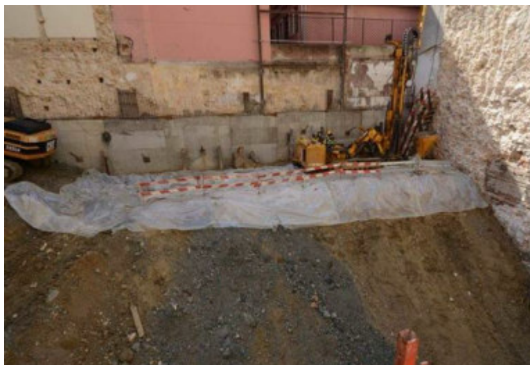
Figura 3.14 - Aterro na zona do Alçado D até à cota -3.00 m. [Fonte: Aditamento projeto de Execução]
