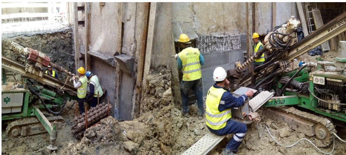
Figura 3.37 – Furação para introdução da armadura das ancoragens.
