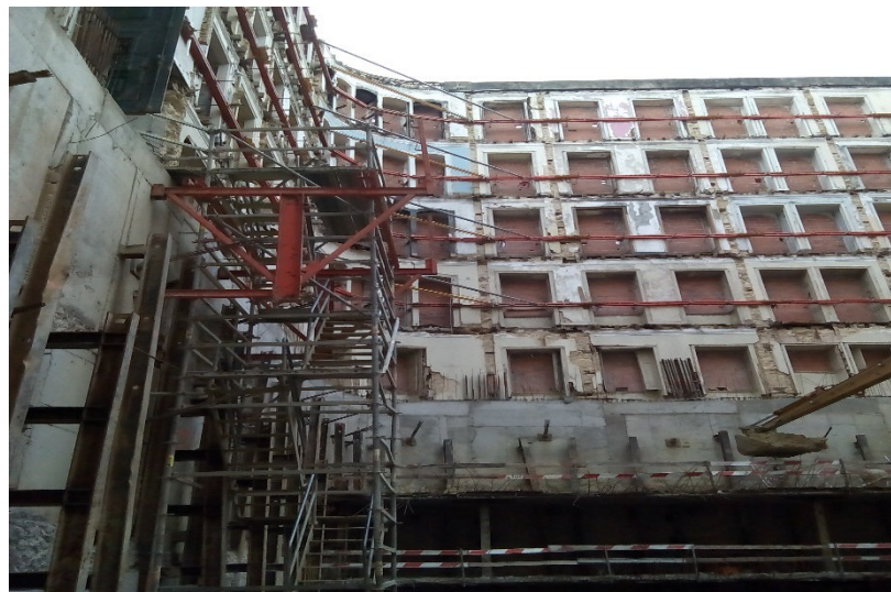
Figura 3.4 - EMCF vista do interior do edifício.
