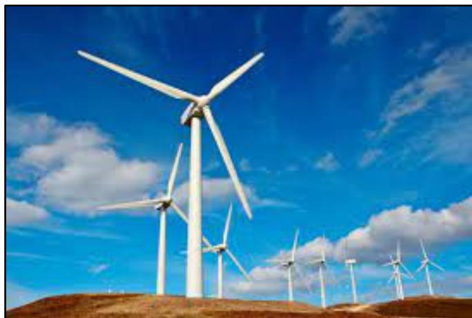
Figura 1 – Parque Eólico Cabeólica, Monte São Filipe (Praia, Ilha de Santiago) [13]
