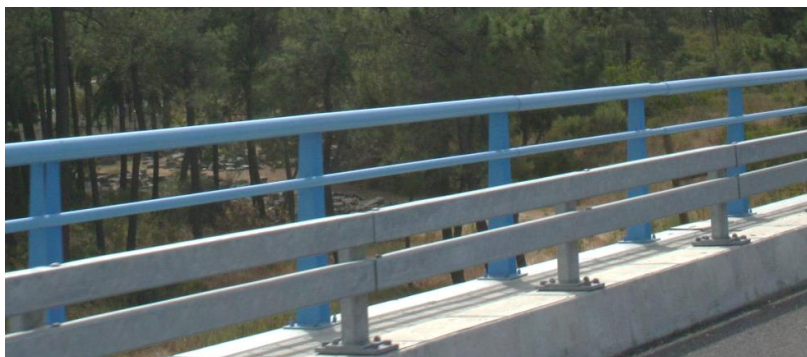
Figura 4.11 – Guarda de segurança dupla com perfil U em obra-de-arte
