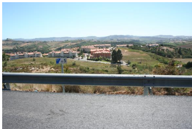
Figura 4.16 – Altura insuficiente entre a viga e solo
