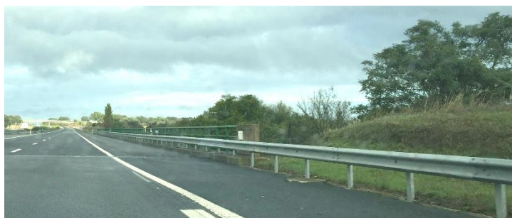
Figura 5.25 – Aproximação a obra-de-arte com prumos afastados de 2,0 metros
