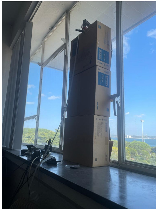
Figura 4.33: Montagem do sistema de detecção.
