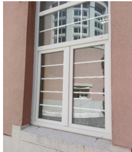
Figura 16 – Janelas em PVC [Autor, 2016]
