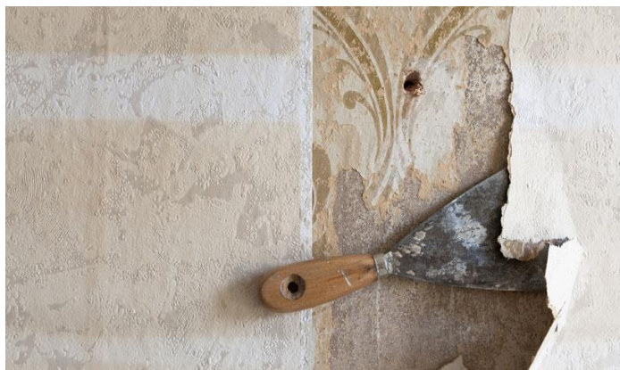
Figura 109 - Remoção da camada de tinta deteriorada
