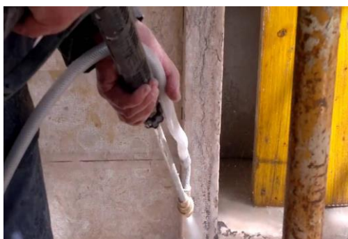
Figura 114 – Aplicação de um jato de água na pedra
