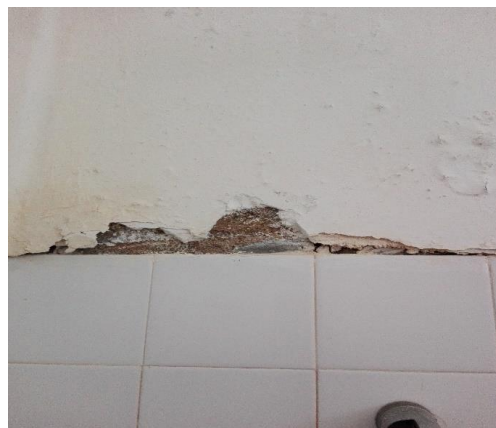
Figura 20 – Revestimento das paredes das instalações sanitárias
