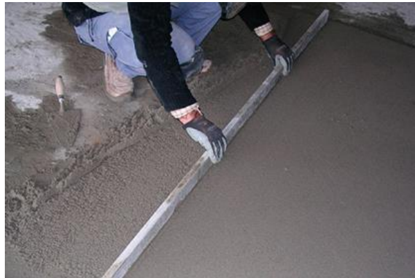
Figura 101 – Aplicação de betonilha no pavimento [Secil Argamassas – Betonilha, 2016]
