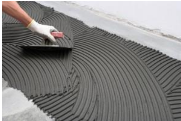
Figura 102 – Aplicação de cimento cola com um pente de Ladrilhador
