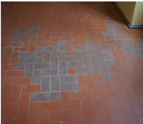
Figura 47 – Reparação dos empolamentos do pavimento
