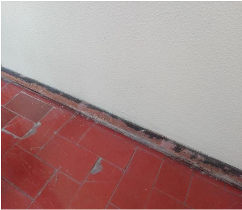
Figura 9 – Rodapé em madeira [Autor, 2016]
