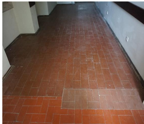
Figura 46 – Reparação dos empolamentos do pavimento
