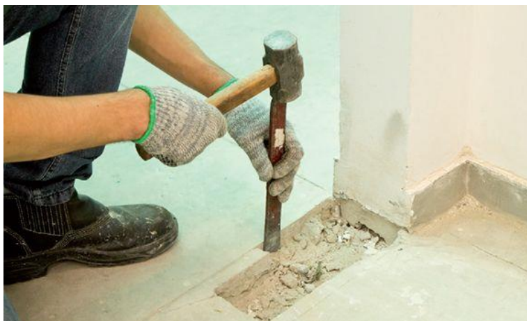
Figura 100 – Remoção do mosaico do pavimento
