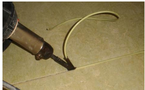
Figura 106- Aplicação do cordão de soldar com pistola de ar quente
