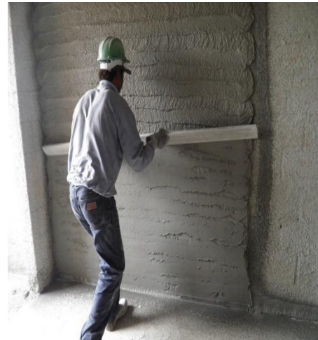
Figura 99 – Sarrafar o reboco com régua [Serraglio – Sarrafar o Reboco Projetado, 2013]
