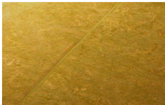
Figura 108 – Resultado final da junta termosoldada
