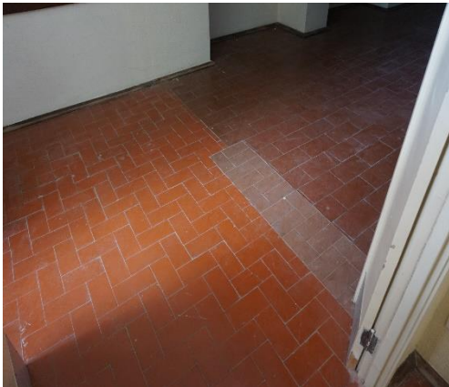
Figura 45 – Reparação dos empolamentos do pavimento
