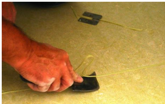
Figura 107 – Remoção do cordão de soldar em excesso aplicado
