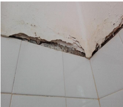
Figura 19 – Revestimento das paredes das instalações sanitárias
