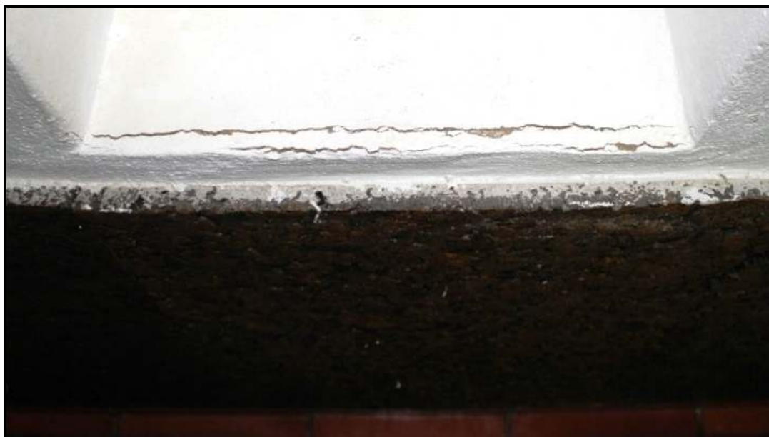
Figura 6.1: Parede forrada com aglomerado de cortiça com humidade ascensional, de autor
