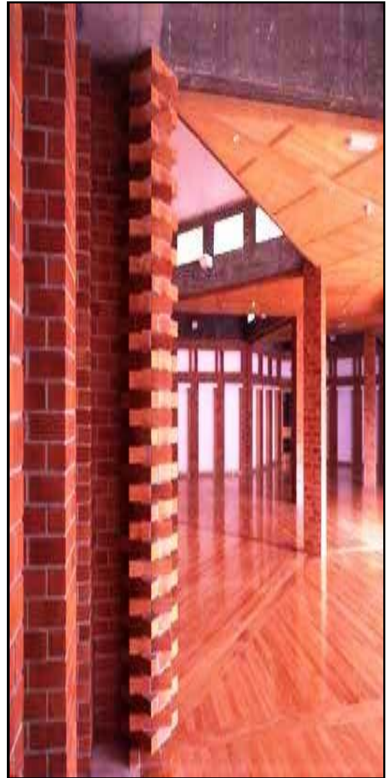
Figura 2.7: Parede interior – Bib. da Moita [13].
