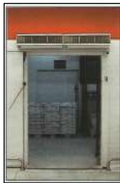
Figura 11 - Entrada de câmara com cortina de ar (Cunha, 1999)
