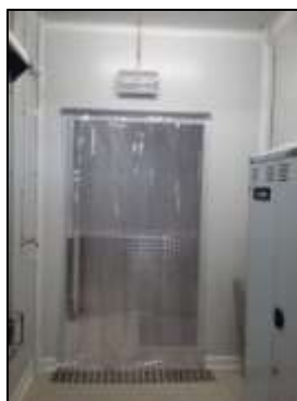
Figura 12 - Cortinas de plástico à entrada da câmara (Cunha, 1999)
