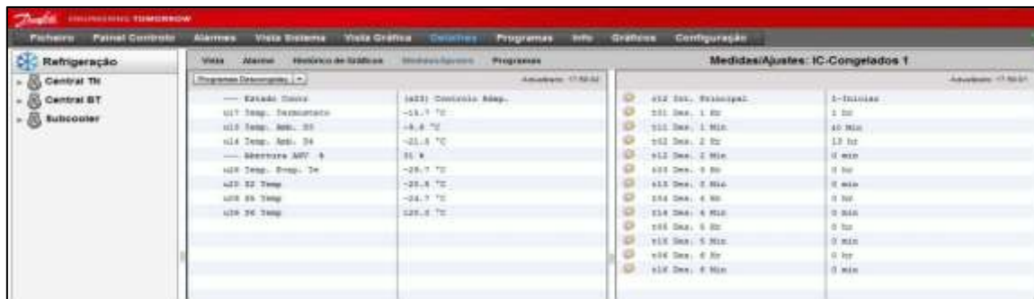
Figura 73 - Dados de leitura do controlador (à esquerda), funções de programação de descongelação sobre o controlador (à direita) de uma ilha de congelados, através do software store view by Danfoss
