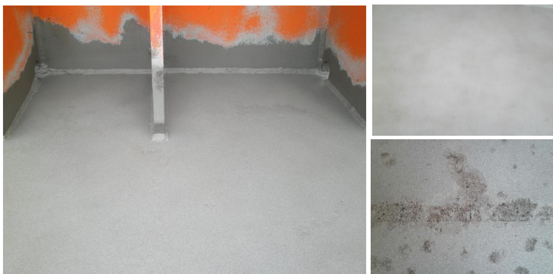
Fotografia 13 – Condição final de limpeza ao grau SA2. [3]
