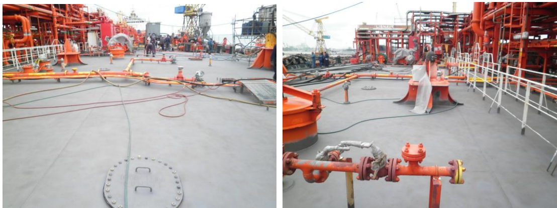
Fotografia 12 – Após o primeiro dia de decapagem e limpeza. [3]
