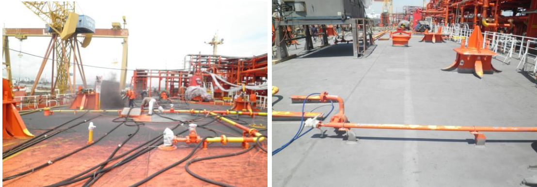
Fotografia 11 – Início da decapagem. [3]
