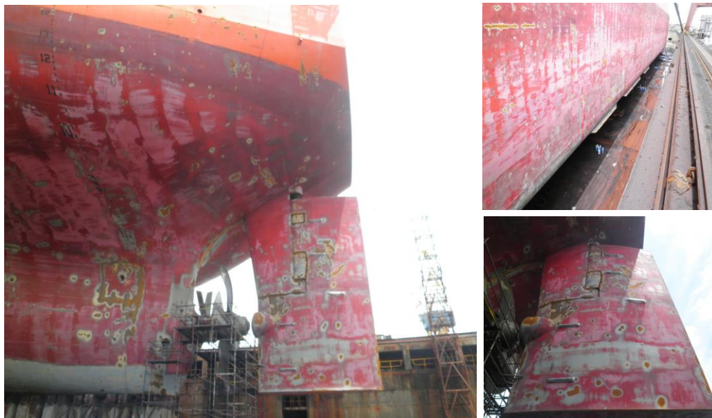
Fotografia 10 – Costado após lavagem da decapagem a 200bar. [3]
