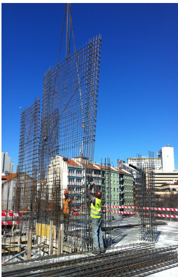
Figura 47 Transporte e colocação da armadura numa parede
