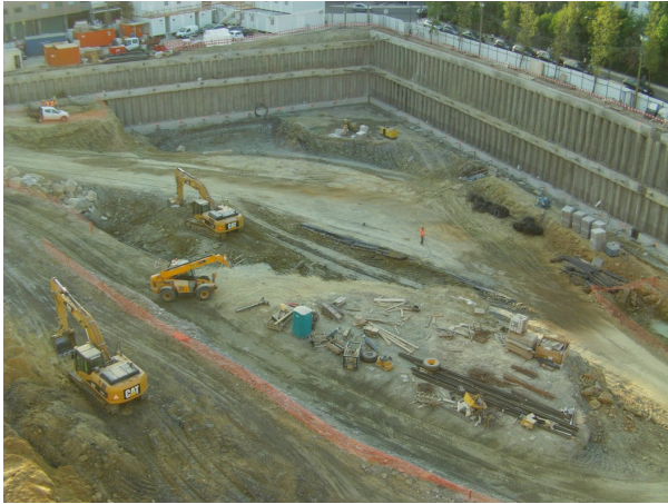
Figura 22 Escavação faseada com a criação de rampas de circulação
