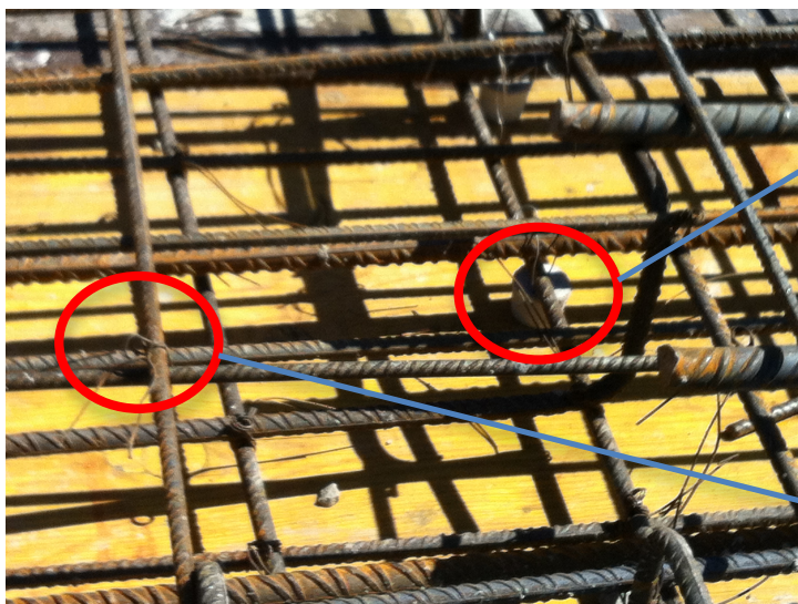
Figura 38 Armadura da laje
