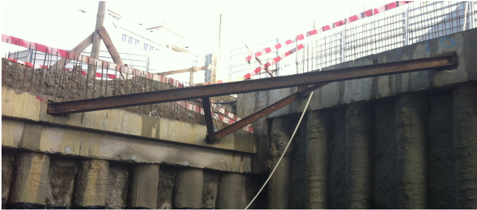
Figura 26 Aplicação de escoramentos de canto
