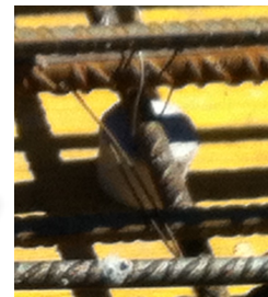
Figura 36 Espaçador na laje
