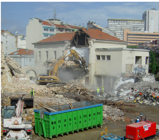
Figura 18 Demolição do edifício da Escola de Medicina Veterinária
