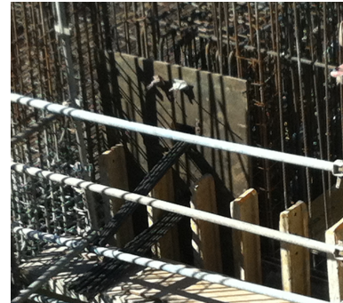
Figura 45 Cabeça das armaduras de pré-esforço
