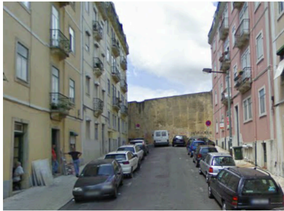
Figura 19 Muro a demolir
