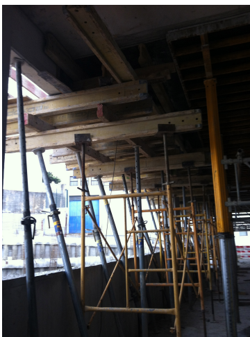
Figura 30 Estrutura do cimbria com as vigas Doka
