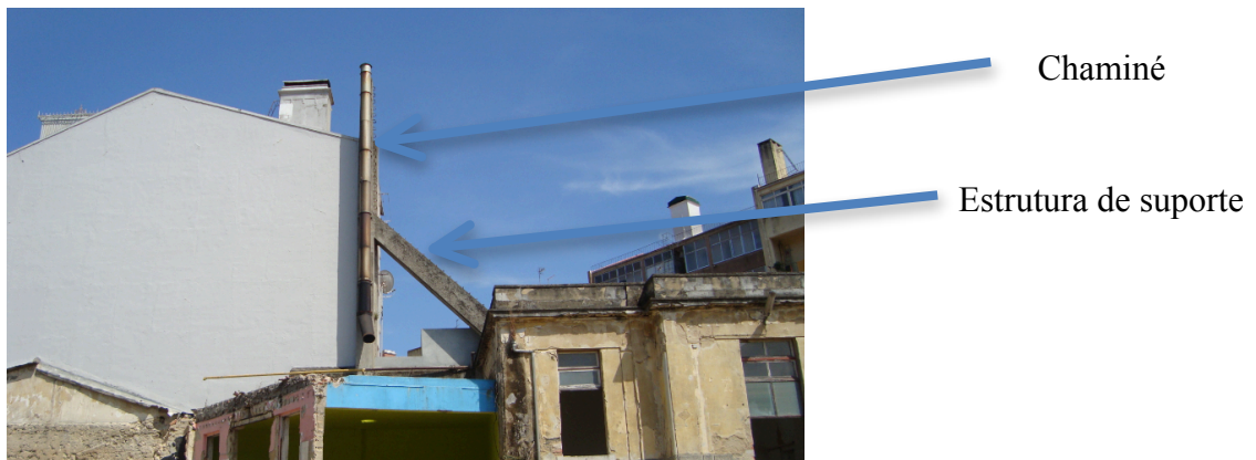
Figura 20 Chaminé e respectiva estrutura de suporte a demolir
