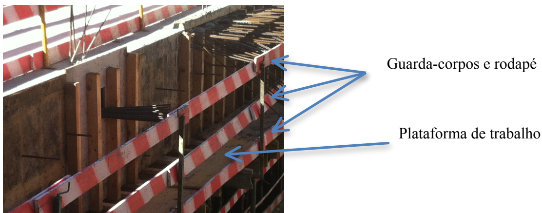
Figura 76 Plataforma de trabalho com as devidas proteções
