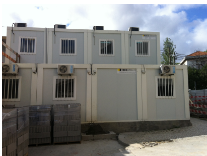
Figura 11 Montagem dos contentores em altura
