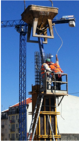
Figura 48 Betonagem de um pilar
