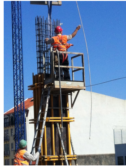
Figura 61 Plataforma de trabalho do pilar
