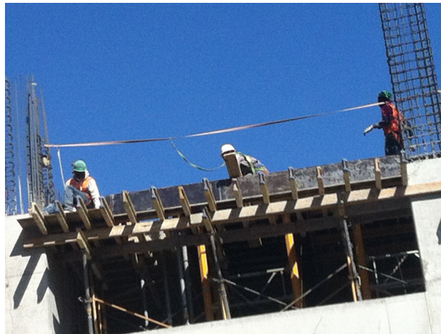
Figura 32 Utilização de linhas de vida na execução da viga de bordadura
