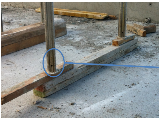
Figura 58 Prumos da mesa de cofragem sobre vigas de madeira
