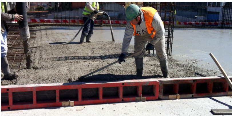
Figura 39 Colocação, espalhamento e vibração do betão
