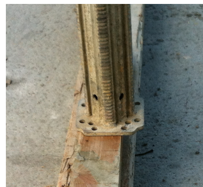
Figura 59 Pormenor do prumo da mesa de cofragem sobre vigas de madeira
