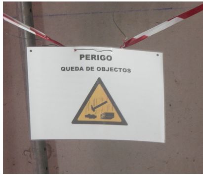
Figura 9 Sinalética de aviso – andaime em manutenção
