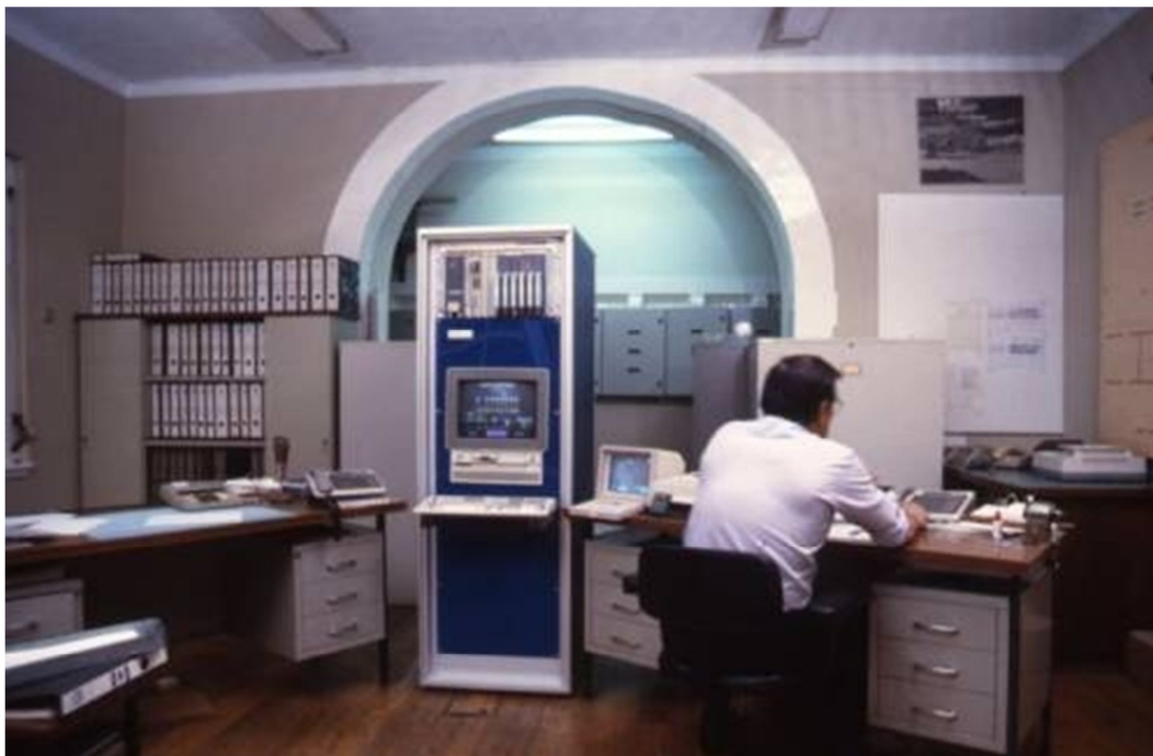
FOTO 4.2 – VISTA GERAL DO CENTRO DE COMANDO DE LISBOA (ARQUIVO HISTÓRICO DA EPAL, 1990)
