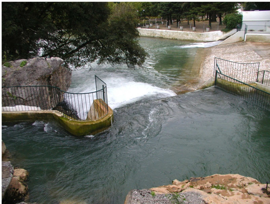
FOTO 2.3 – CAPTAÇÃO SUBTERRÂNEA DE OLHOS DE ÁGUA (ARQUIVO PESSOAL, 2006)
