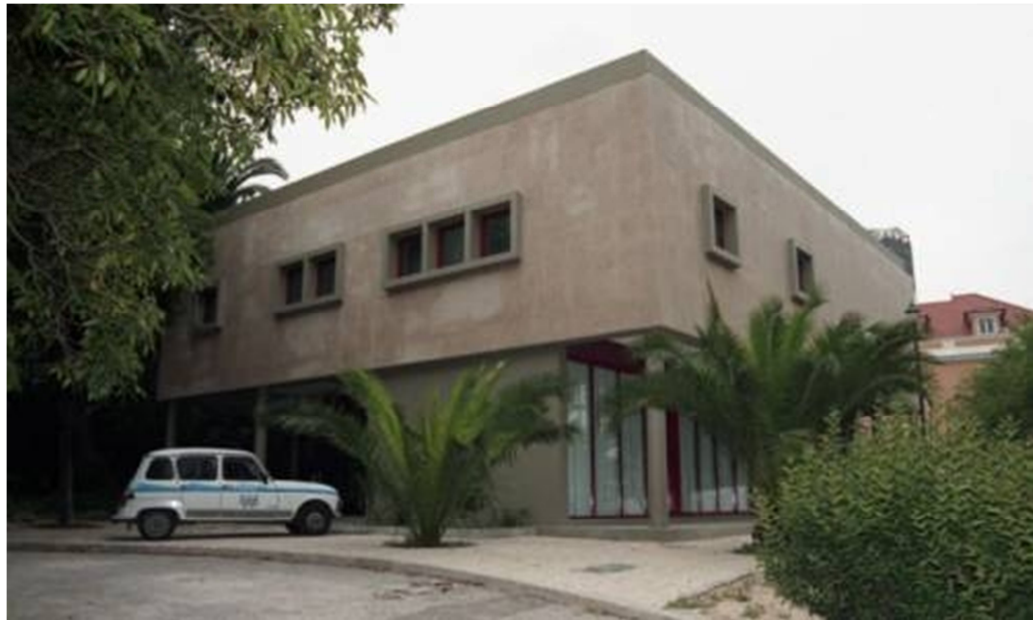
FOTO 4.5 – EDIFÍCIO DO CENTRO DE COMANDO NO RECINTO DO ARCO (ARQUIVO HISTÓRICO DA EPAL, 1995)
