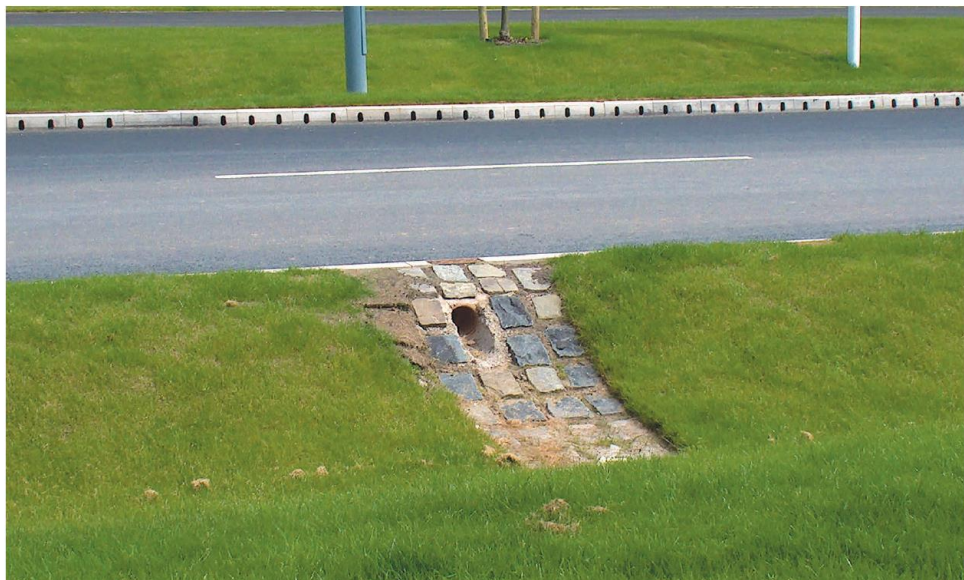
Figura 43 – Sistema de recolha no interior de lancil com descarga em canal não revestido (ACO IBERIA, 2016)
