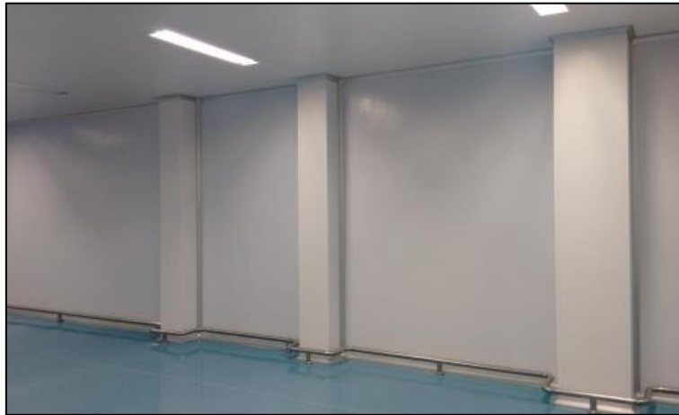
Figura 3.28-Parede constituída com painéis isotérmicos [31].
