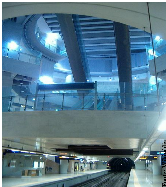
Fig. 31 - Estação de Metro da Ameixoeira
